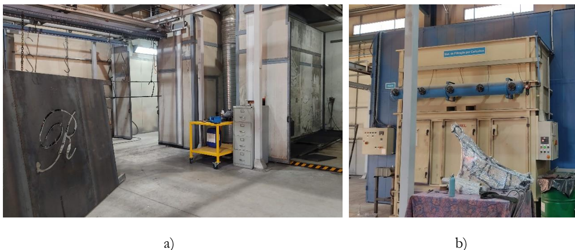
Figura 3.7 – Secção de Lavagem e Pintura: a) Zona de pintura e lavagem; b) Estufa com sistema de filtração de poluentes gerados no processo.
