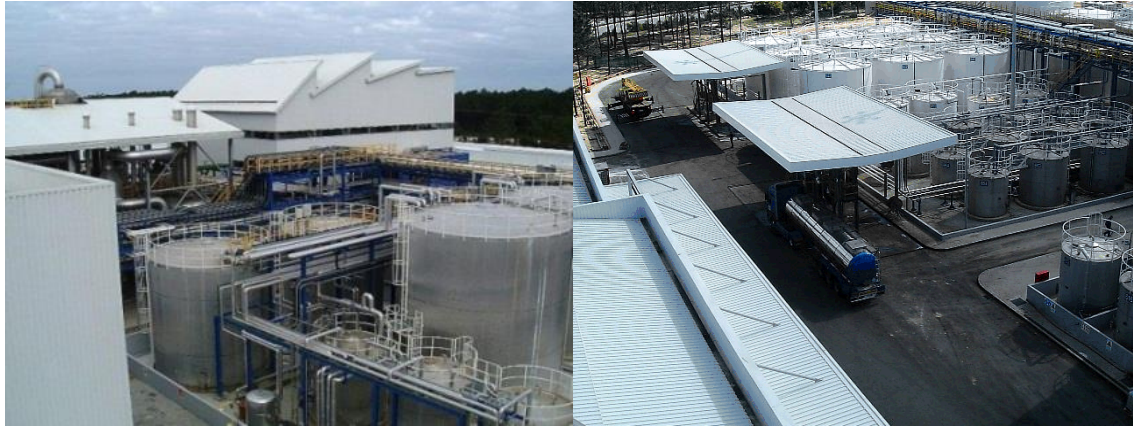
Figura 4.2 – Unidade Industrial da Euroresinas S.A. em Sines (Euroresinas, 2013).
