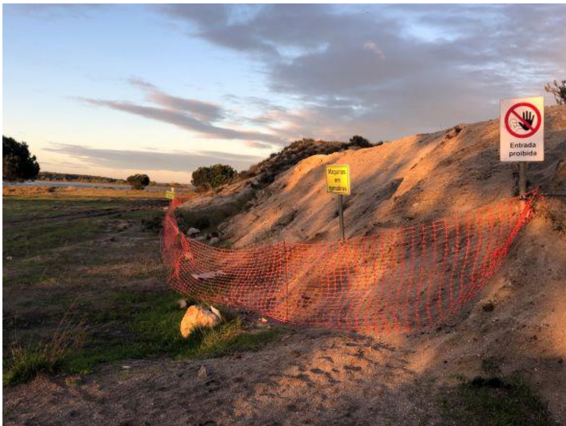
Figura 10 – Sinalização de segurança instalada na delimitação do local da obra
