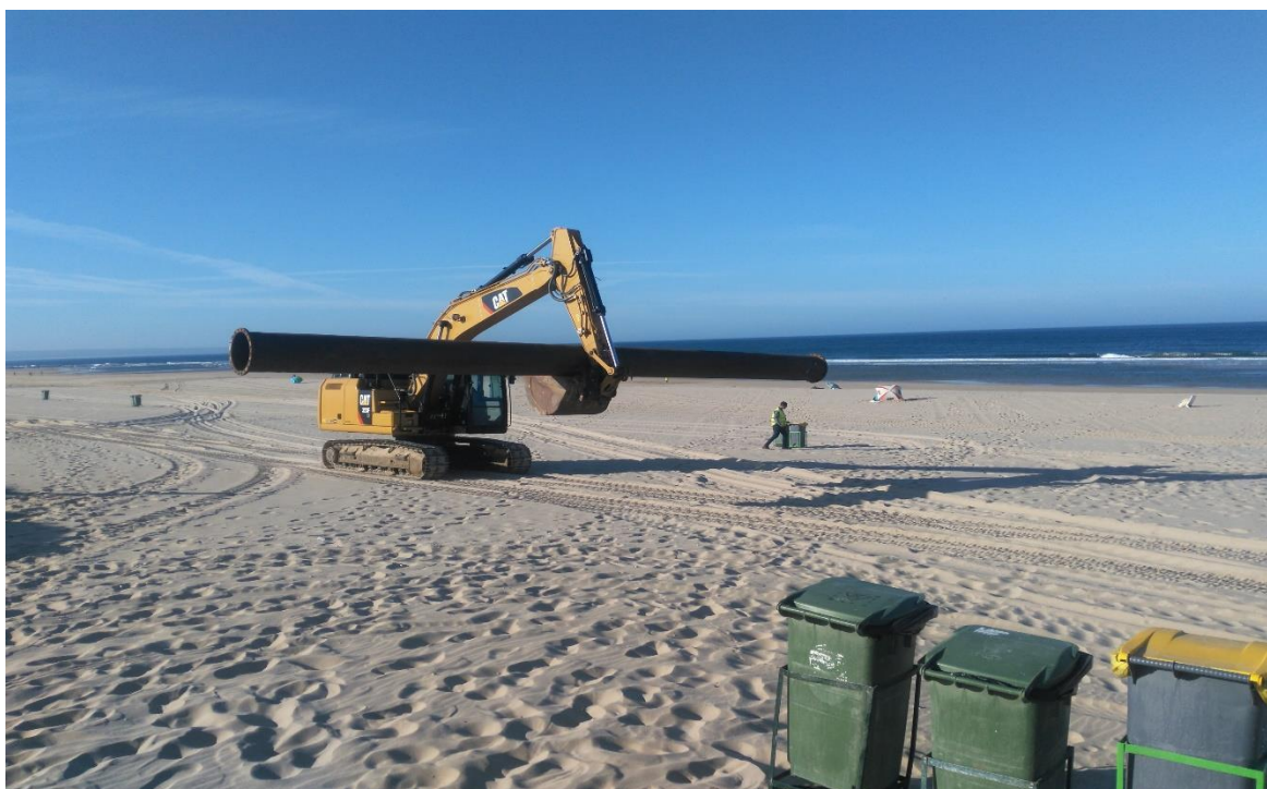
Figura 23 – Desmobilização dos tubos de aço
