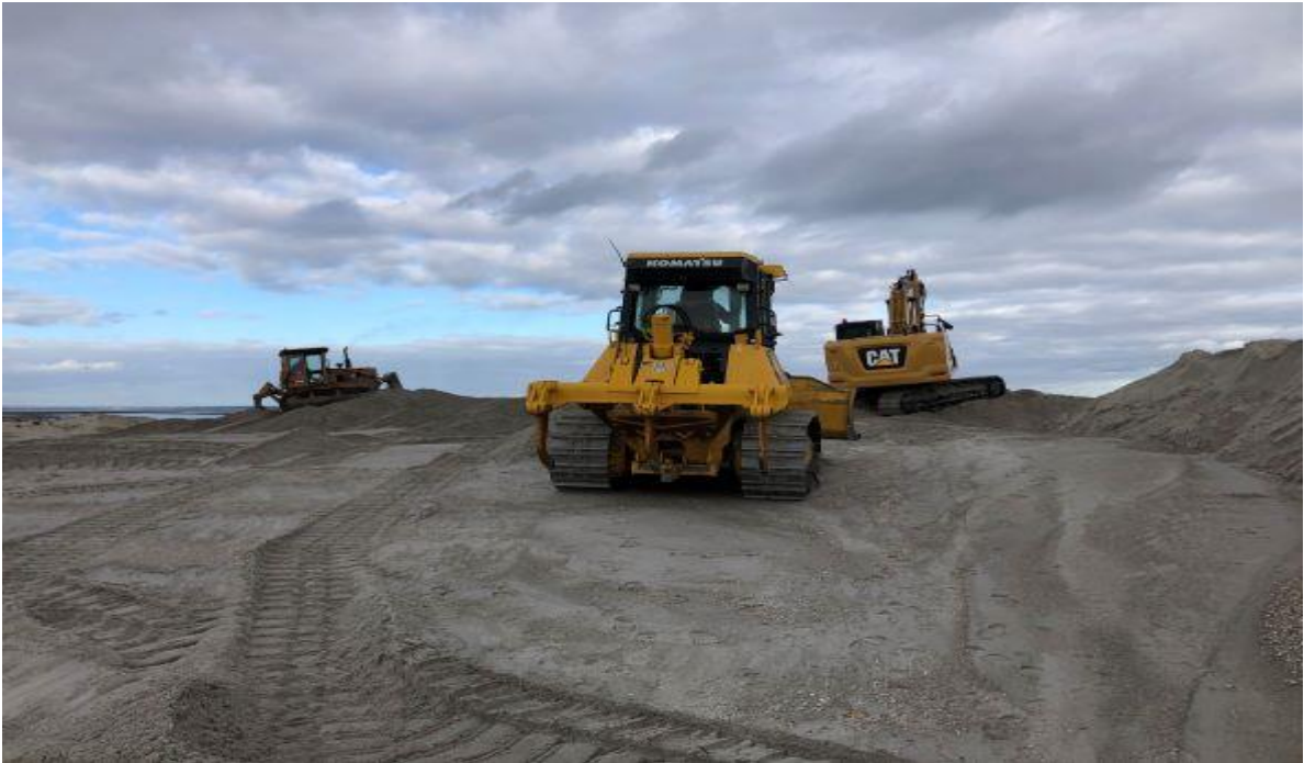
Figura 11 – Equipamentos de movimentação de terras em operação
