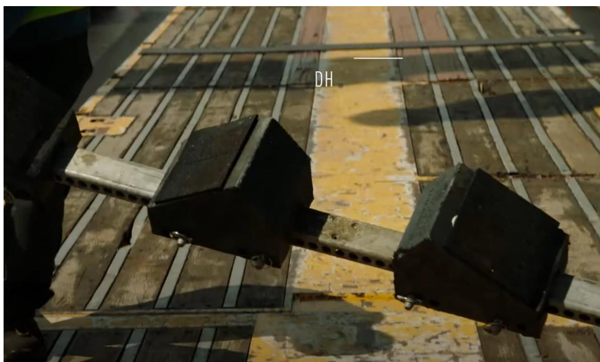
Figura 7 – Berços com batentes reguláveis para assentamento dos tubos
