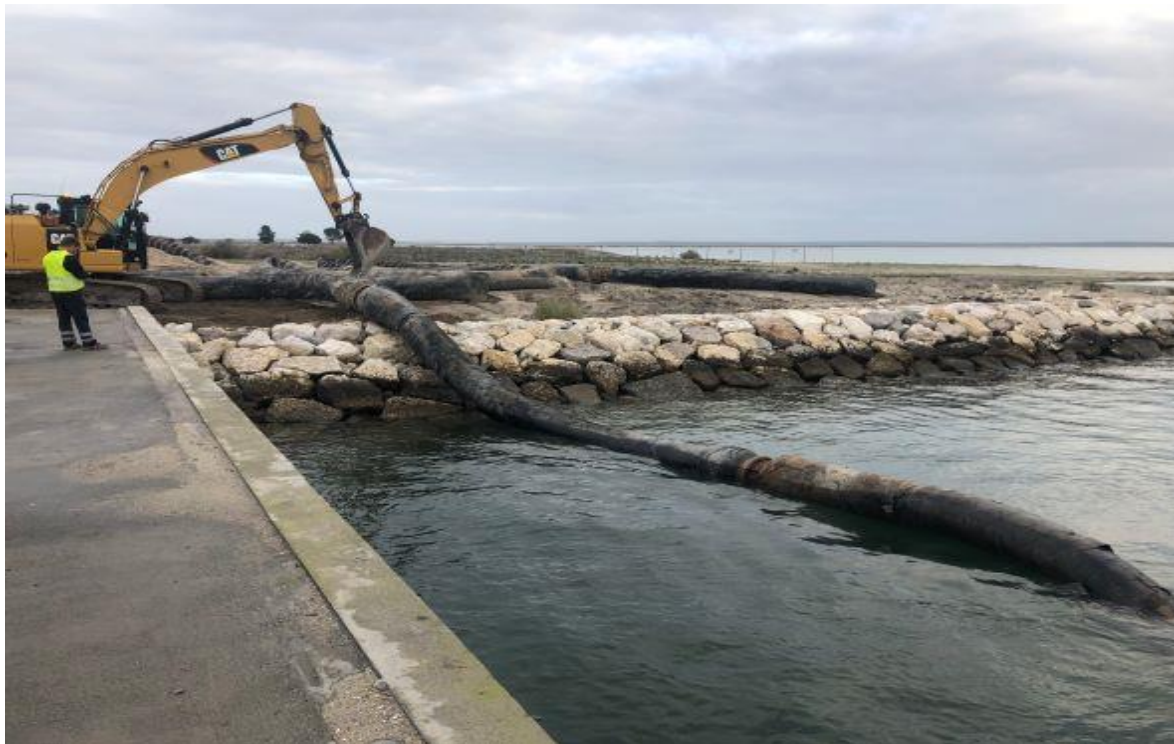
Figura 13 – Operação de colocação do pipeline na água
