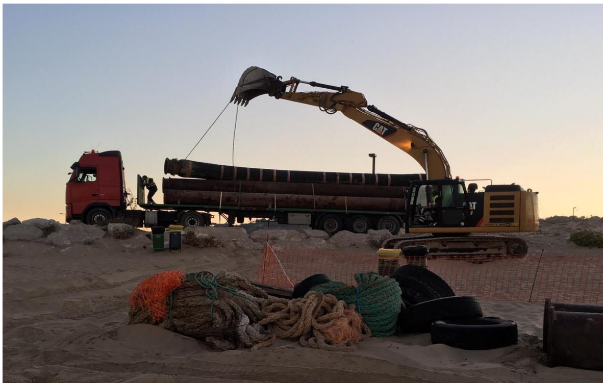
Figura 15 – Descarregamento de tubos
