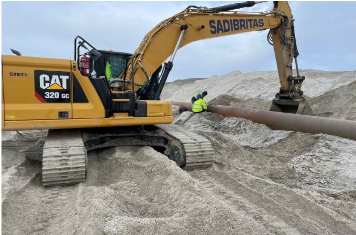
Figura 9 – Operação de montagem do pipeline no terrapleno
