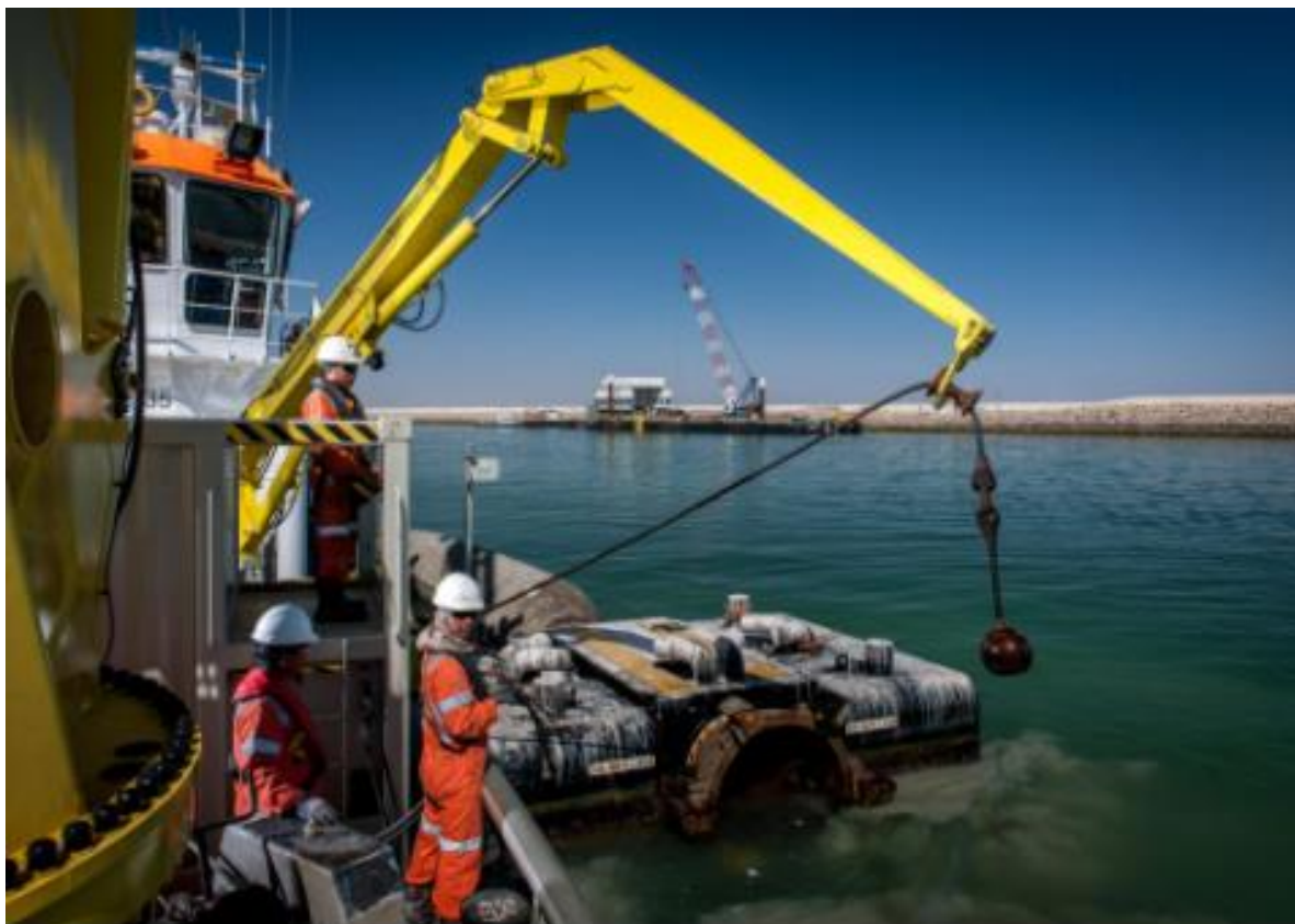
Figura 3 – Sistema de acoplamento automático de pipelines flutuantes
