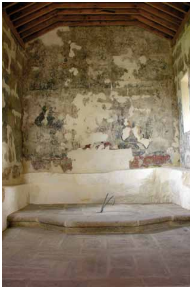
Aspecto da parede fundeira da capela-mor após a conclusão dos trabalhos.
