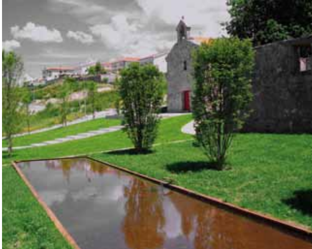
Tina de água e restantes arranjos exteriores depois das obras.
