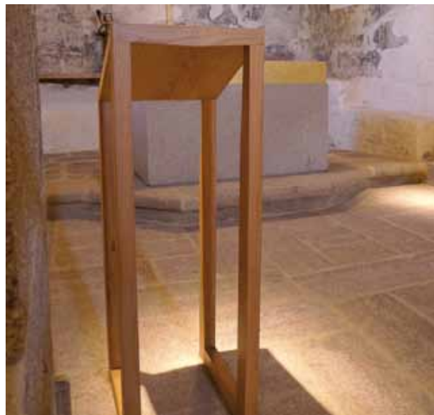
Pavimento da capela-mor em granito.
