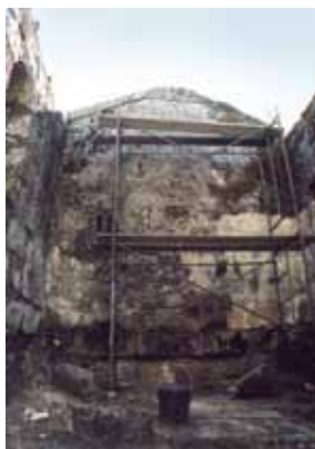
Aspecto da parede fundeira da capela-mor durante a primeira fase de intervenção.
