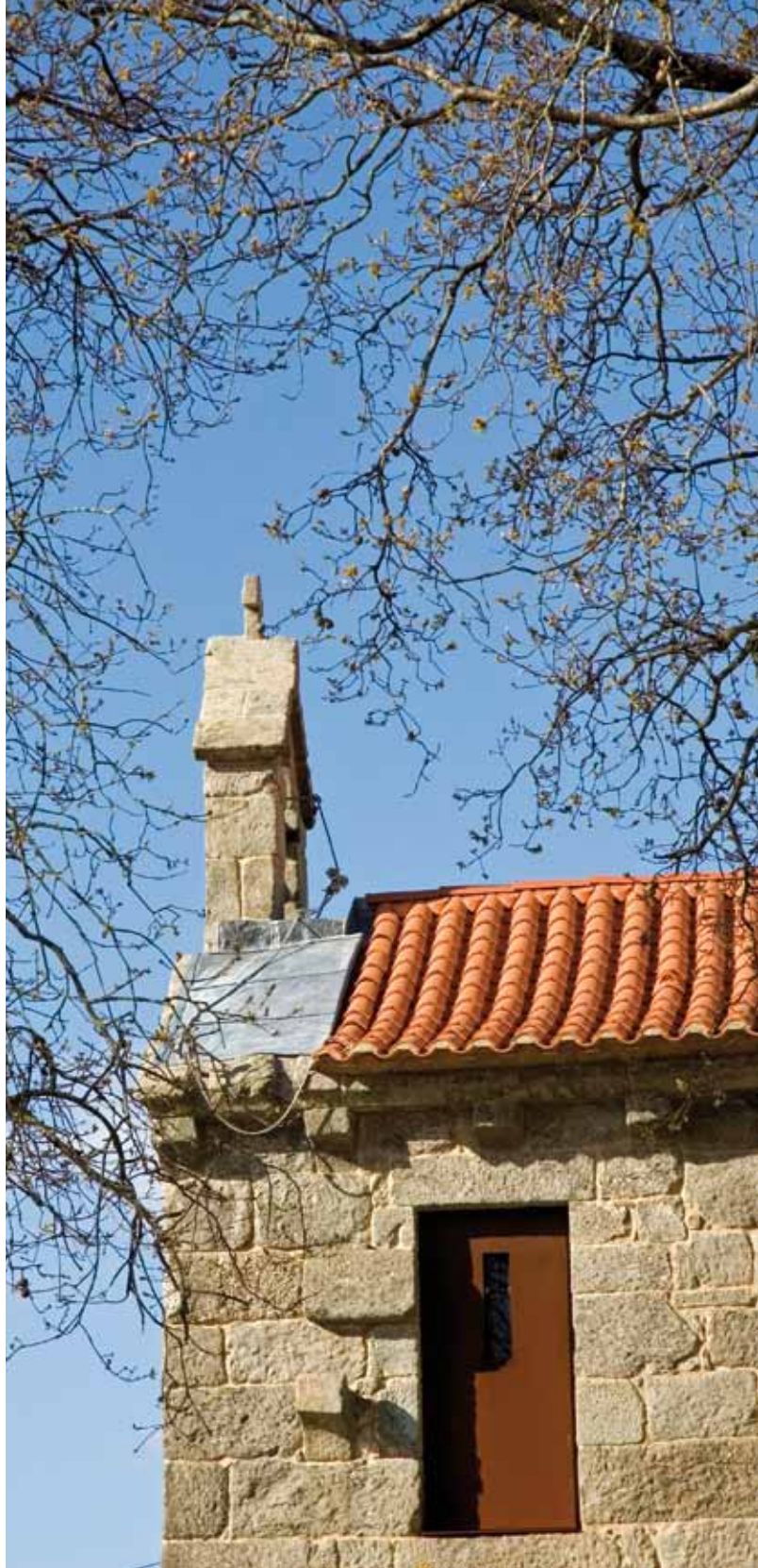
Caixilho metálico em aço corten-a de encerramento da porta de acesso ao coro-alto e recriação de fresta de iluminação.
