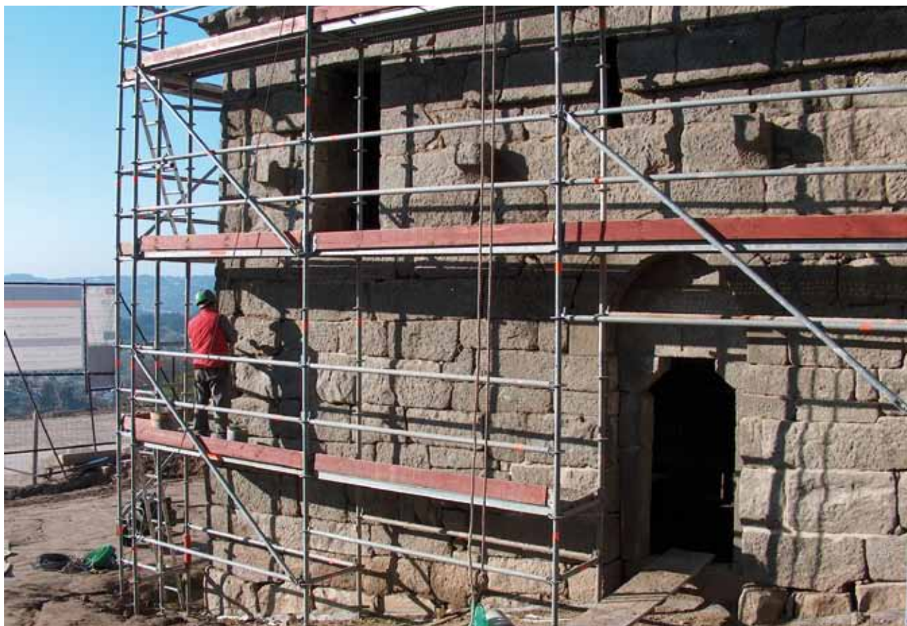
Refechamento das juntas.
