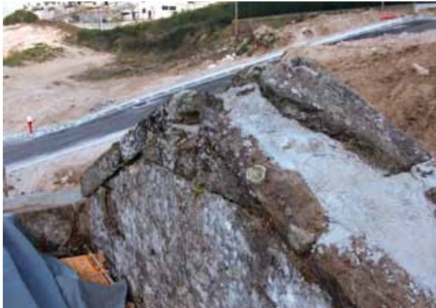
Consolidação do topo da parede da empena posterior.
