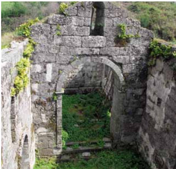
Interior da ruína em março de 2004.
