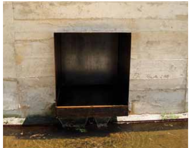
Bica de água da mina.
