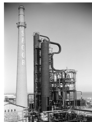
Fig.153 Refinaria Cabo Ruivo. Trabalhos de colocação de tubagem e destilação do petróleo bruto, Lisboa, 1940.
