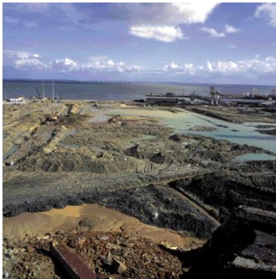
Figura 8 - Fase de construção
