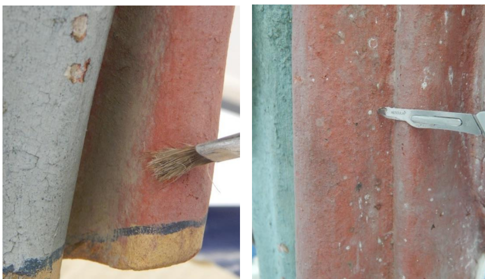
Figuras 148 e 149 – Limpeza mecânica com trinchas e bisturi. A.P.
