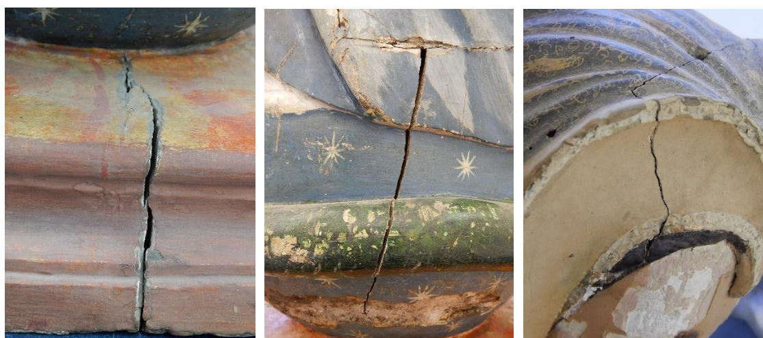
Figuras 126, 127 e 128 - Fendas e fissuras no suporte das esculturas em madeira. A.P.
