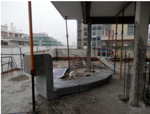
Figura 109 – Remoção de equipamentos eletromecânicos
