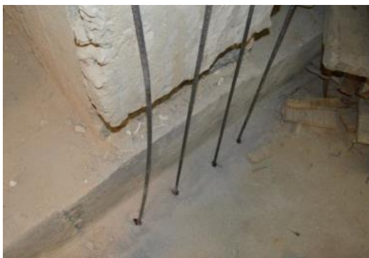
Figura 142 – Selagem de varões para reforço de pilares
