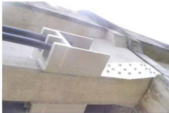
Figura 46 – Adição de pré-esforço (pós-esforço) exterior
