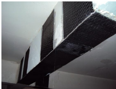
Figura 47 – Reforço de viga com fibras (FRP)
