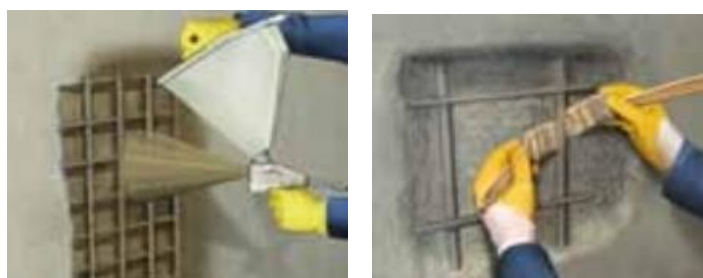
Figura 28 – Técnicas de aplicação da protecção anticorrosiva: pistola e trincha
