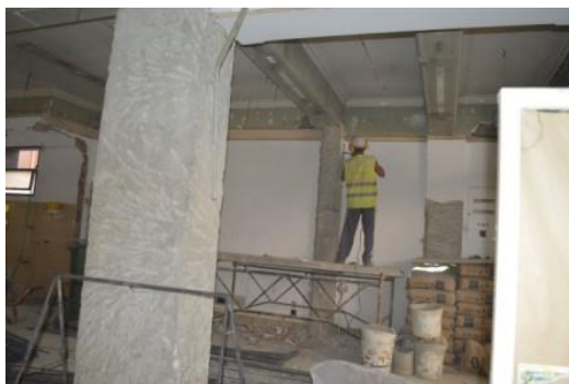
Figura 115 – Escarificação de pilares do piso 0
