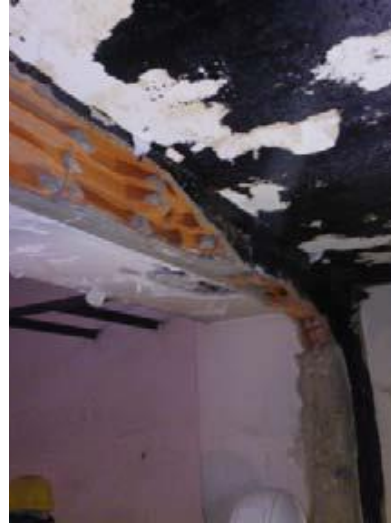
Figura 118 – Viga forrada com tijolo
