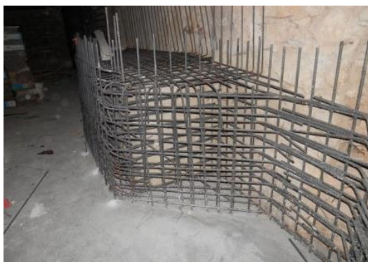
Figura 206 – Armadura da parede periférica orientada a norte
