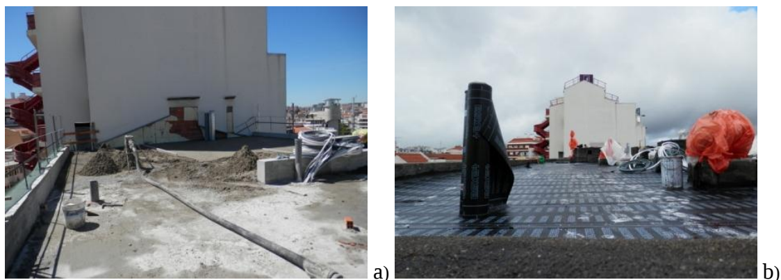
Figura 229 – Fases da execução da cobertura do Piso 7: a) colocação de betonilhas sobre a laje de betão; b) Aplicação de tela após a aplicação de betonilhas sobre a laje de betão
