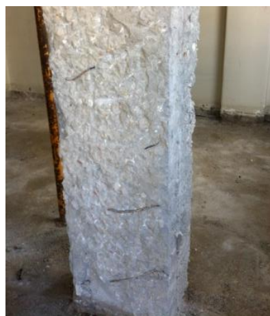
Figura 87 – Sondagem efetuada nos pilares dos pisos superiores onde se verifica: a) a armadura existente no interior dos pilares; b) a desagregação dos materiais
