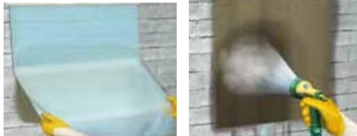
Figura 31 – Processo de cura: filme plástico e serapilheira humedecida
