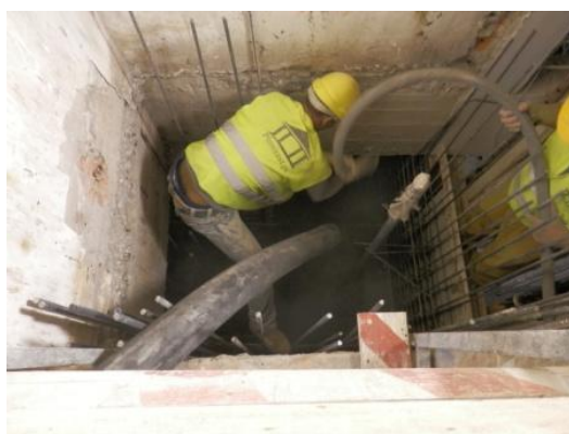
Figura 199 – Betonagem do poço existente
