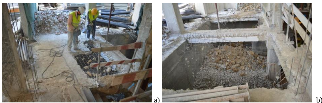
Figura 166 - Laje piso 0 na zona das I.S a) demolição da laje; b) remoção da armadura
