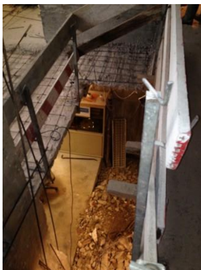
Figura 187 – Demolição de escadas de acesso à cave
