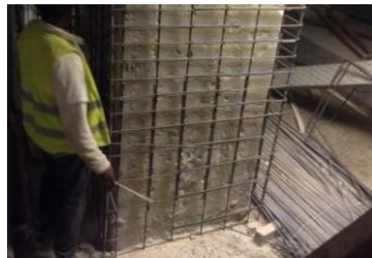
Figura 143 – Colocação armaduras pilares R/Chão
