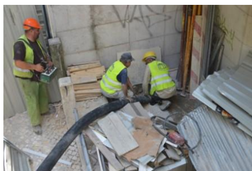
Figura 211 – Betonagem da parede periférica orientada a sul
