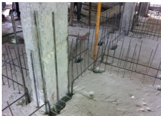
Figura 182 – Armadura do pilar prevendo a ligação às nervuras da laje – piso 1
