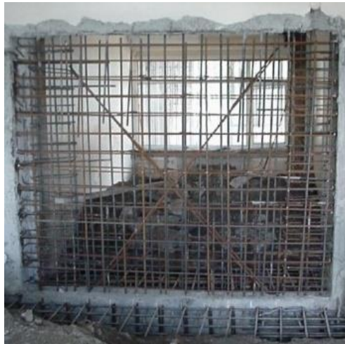
Figura 44 – Adição de paredes resistentes de betão armado
