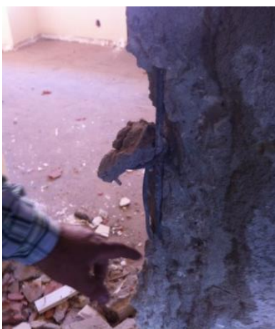
Figura 87 – Sondagem efetuada nos pilares dos pisos superiores onde se verifica: a) a armadura existente no interior dos pilares; b) a desagregação dos materiais
