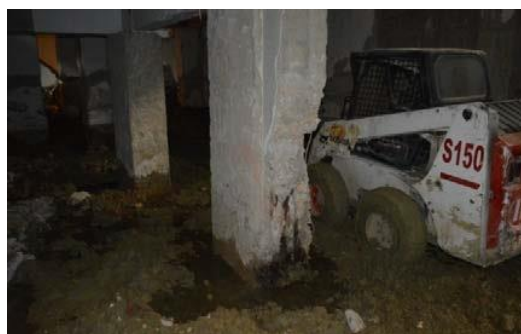
Figura 114 – Trabalhos de transportes de resíduos da escavação com mini pá carregadora
