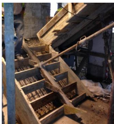
Figura 185 – Escadas centrais do piso 0 ao piso 1: a) preparação da cofragem em madeira; b) betonagem
