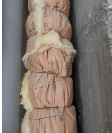
Figura 235 – Isolamento, com lã de rocha, em torno da tubagem da rede de esgotos
