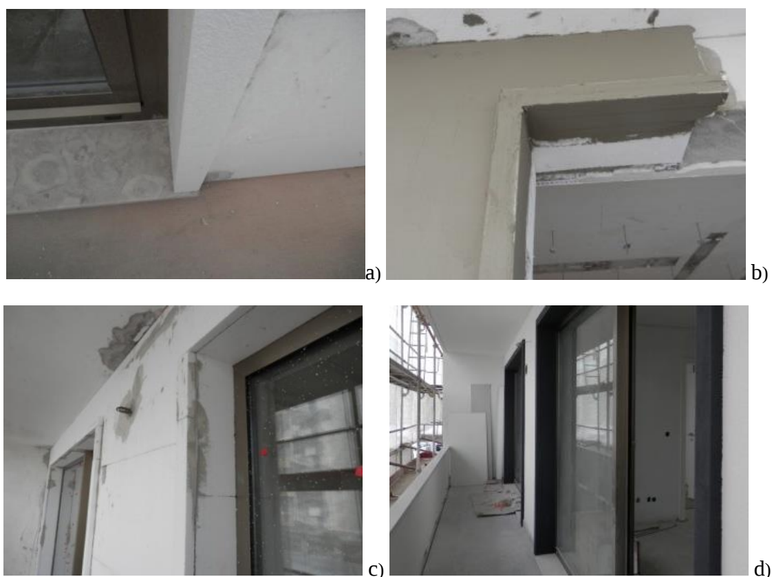
Figura 223 – a) execução do sistema de isolamento pelo exterior, sobre a soleira, com a formação da moldura na envolvente do vão; b) aplicação das molduras em torno das janelas; c) aplicação do barramento; d) revestimento concluído
