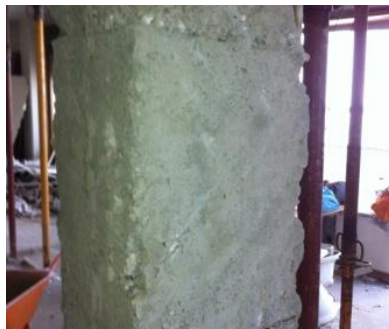
Figura 141 – Escarificação de pilares
