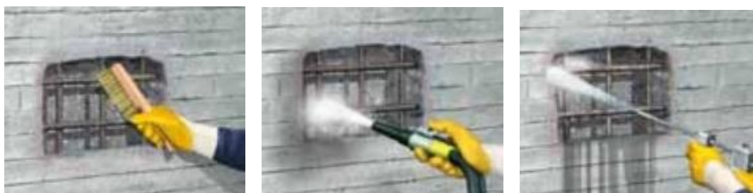
Figura 27 – Técnicas de limpeza: escova de aço, decapagem a jato abrasivo (areia) e jato de água de alta pressão
