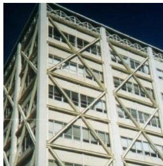
Figura 45 – Adição de estruturas de contraventamento
