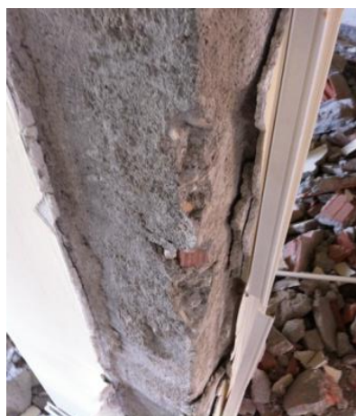
Figura 86 – Sondagem efetuada em pilares dos pisos superiores: a) existência de outros elementos na constituição do pilar de betão; b) restos de elementos cerâmicos
