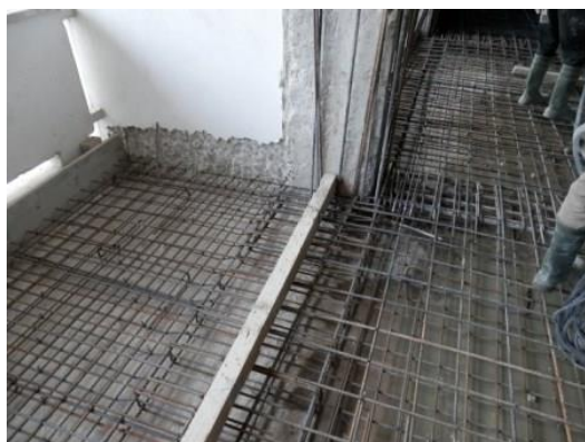
Figura 180 – Transição de cota entre o interior e o exterior (varanda) – piso 1
