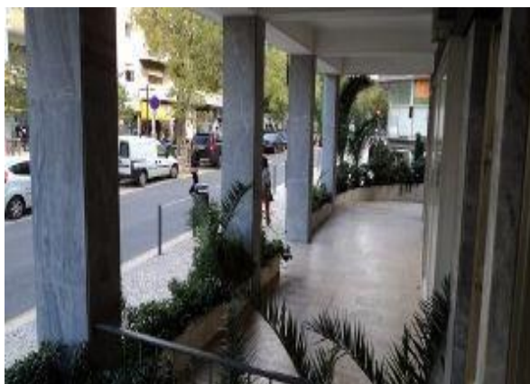
Figura 74 - Vista exterior do piso 0
