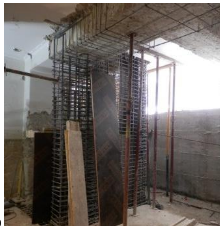
Figura 193 – Parede resistente PB6: a) demolição parcial da laje; b) e c) execução da armadura da parede; d) cofragem
