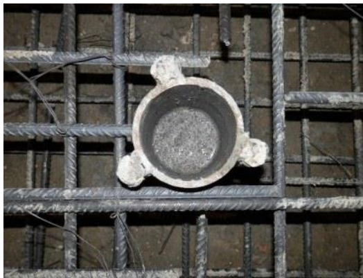
Figura 123 – Cabeça da microestaca
