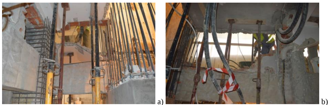
Figura 151 – Demolição: a) de alvenaria sobre a viga V.1.20; b) de alvenaria sobre a viga V.1.10
