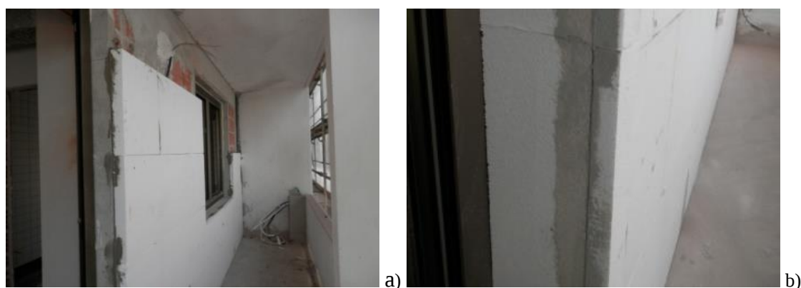
Figura 221 – Fases do processo de execução do sistema de isolamento pelo exterior em: a) paredes; b) ombreiras
