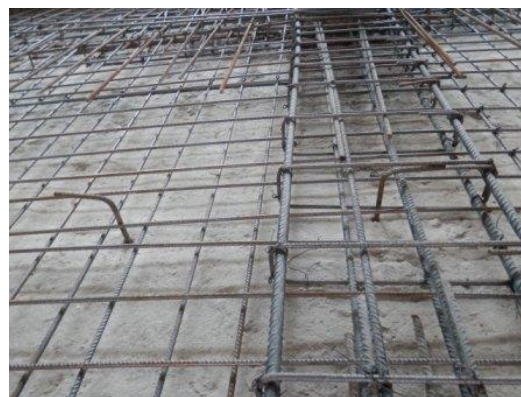
Figura 181 – Selagem de varões estrategicamente localizados para efetuar a ligação entre a laje existente e a nova laje – piso 1
