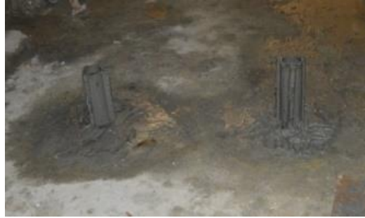
Figura 125 – Aplicação de calda de cimento nas microestacas
