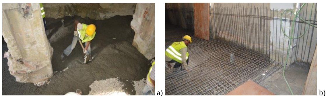
Figura 134 – Ensoleiramento geral: a) espalhamento do betão de limpeza; b) colocação da armadura na laje e no arranque da parede periféricas
