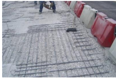
Figura 25 – Remoção do betão através do processo de fresagem
