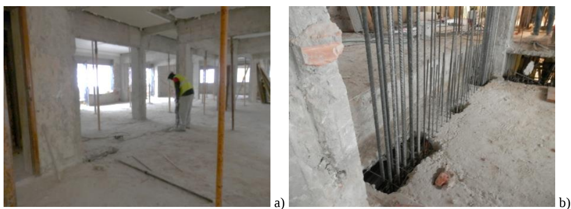
Figura 190 – Parede resistente PB4: a) demolição parcial da laje para atravessamento da armadura; b) atravessamento da armadura
