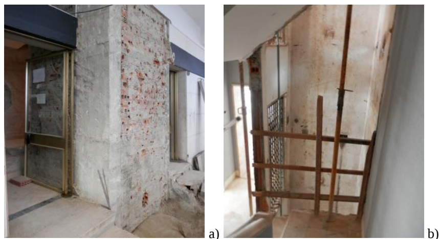
Figura 90 – Sondagem efetuada nas paredes das caixas de elevadores: a) ao nível do piso 0; b) demolição parcial das paredes das caixas de elevadores (vista interior através do núcleo de escadas)
