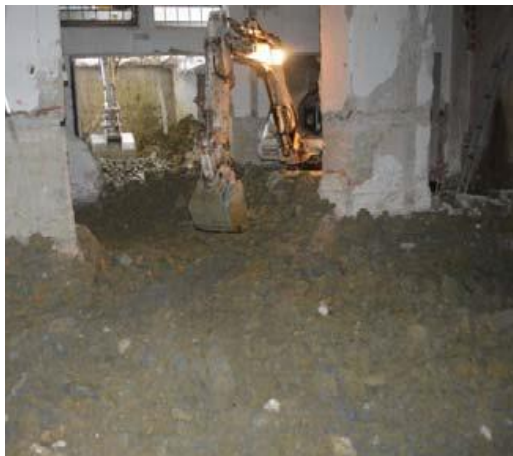
Figura 95 - Trabalhos de escavação na cave com mini escavadora giratória
