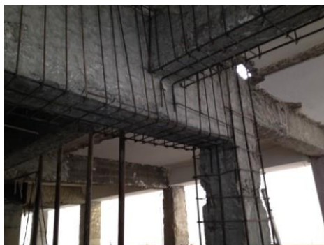
Figura 156 – Armaduras das vigas V.2.17 e V.2.36
