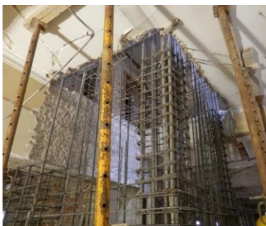
Figura 193 – Parede resistente PB6: a) demolição parcial da laje; b) e c) execução da armadura da parede; d) cofragem
