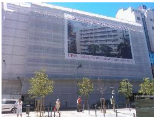
Figura 107 – Colocação de andaime com rede de proteção e de lona publicitária CPAS
