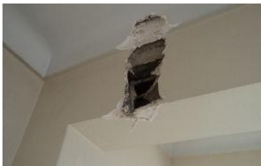
Figura 82 - Revestimento de teto em estuque e viga em estafe
