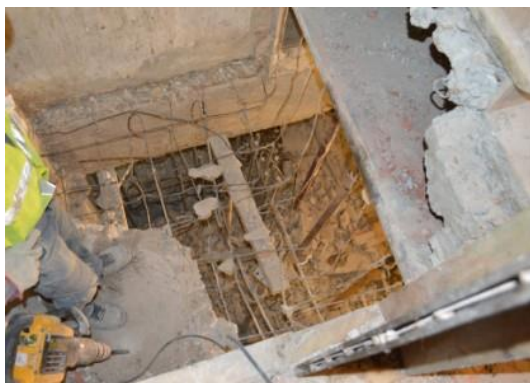
Figura 197 – Demolição do poço existente
