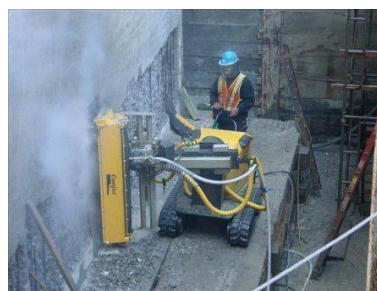
Figura 24 – Remoção do betão através do processo de hidrodemolição
