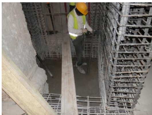
Figura 192 – Fosso da nova caixa de elevador, designada de PB6
