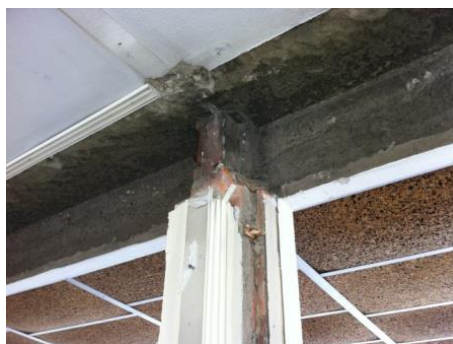
Figura 92 – Exemplo de um pilar do piso 7, após a remoção das caixas de estore
