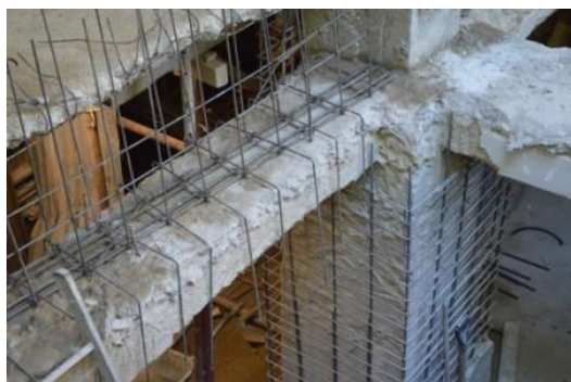
Figura 167 – Armadura da Viga V.1.25
