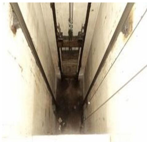
Figura 64 - Vista interior da caixa de elevador
