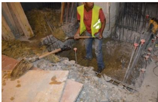
Figura 137 – Escavação posterior à betonagem da laje de ensoleiramento para implantação da caixa nova de elevador
