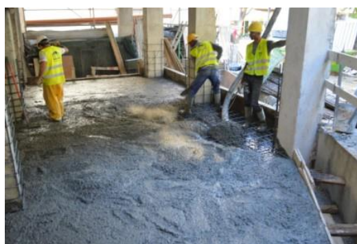
Figura 169 – Nova laje do piso 0: a) armadura da nova laje (já sobrelevada); b) betonagem
