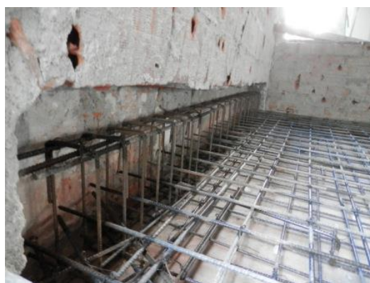
Figura 179 – Armadura da nervura da laje no limite do edifício – piso 1
