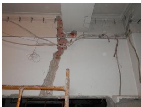
Figura 157 – Demolição da V.1.18
