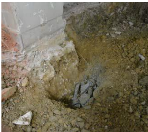
Figura 93 - Trabalhos de escavação onde se verificou a inexistência de sapata
