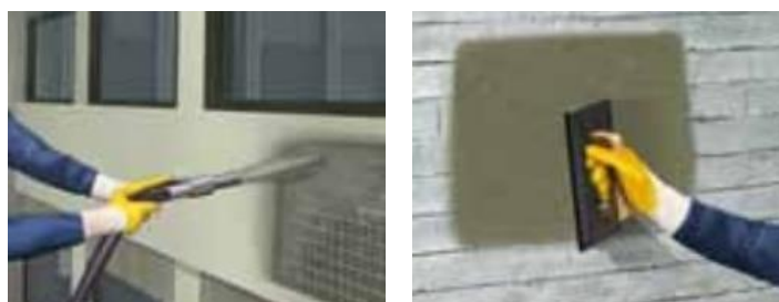
Figura 30 – Técnicas de reparação com projecção por via húmida
