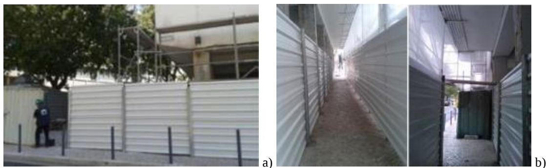
Figura 106 – Tapume: a) vista da Avenida Duque D'Ávila; b) zona de circulação de peões
