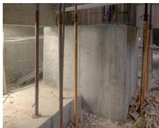
Figura 200 – Descofragem do poço existente
