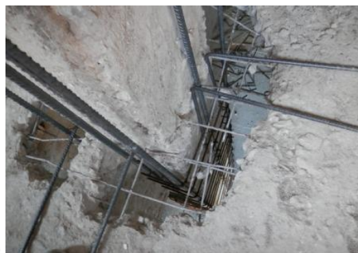
Figura 144 – Betonagem dos pilares na cave: a) através de aberturas na laje do piso 0; b) atravessamento de armadura para dar continuidade à armadura do pilar e à colocação de armadura para ligação à laje a executar
