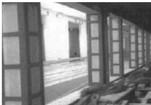
Figura 37 – Reforço de pilares com incorporação de perfis metálicos ligeiros
