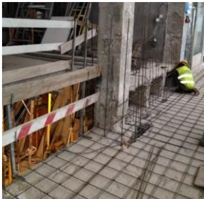
Figura 173 – Armação de reforço de laje do piso 0 na zona da galeria (2ª fase) e armação da viga
