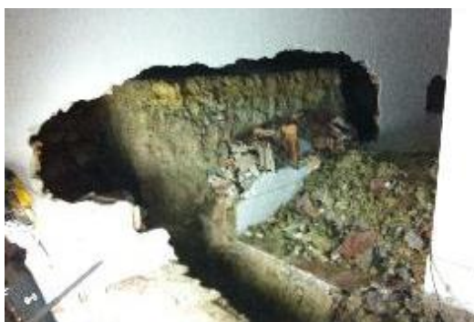
Figura 116 – Sapata do pilar da galeria na cave
