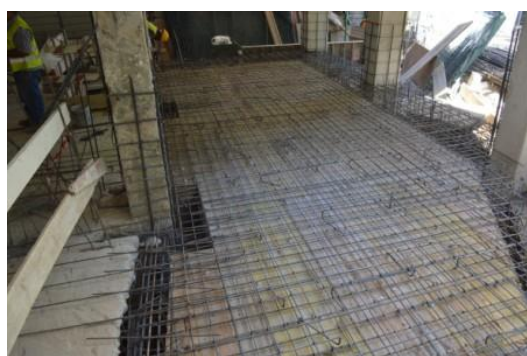
Figura 169 – Nova laje do piso 0: a) armadura da nova laje (já sobrelevada); b) betonagem
