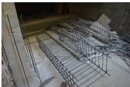
Figura 152 – Moldagem das vigas V.1.17 e V.1.10 em estaleiro
