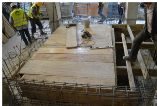
Figura 168 – Cofragem da laje do piso 0 à nova cota
