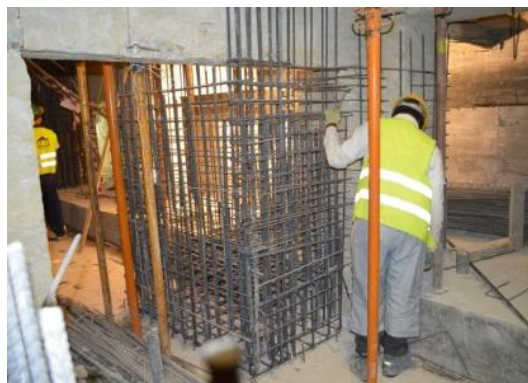
Figura 198 – Armadura da sapata/ fundo do poço de elevador
