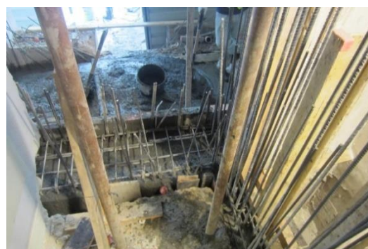
Figura 155 – Betonagem da viga V.1.9
