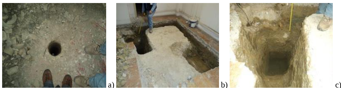
Figura 63 - Execução de sondagens ao nível da cave: a) furação; b) abertura de vala; c) visualização do nível freático
