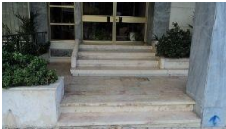
Figura 76 – Revestimento da entrada a pedra
