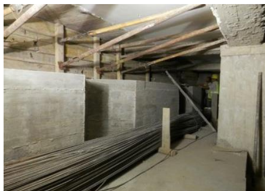
Figura 207 – Descofragem da 1ª fase já betonada seguindo-se a cofragem para a 2ª fase de betonagem da parede periférica orientada a norte
