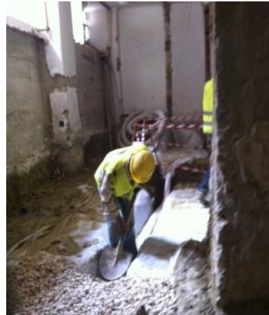
Figura 133 – Colocação de brita sobre o dreno
