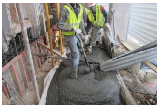
Figura 154 – Descarga de betão para betonagem “a balde” dos vários elementos
