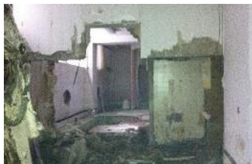
Figura 112 – Trabalhos de escavação e demolição na cave
