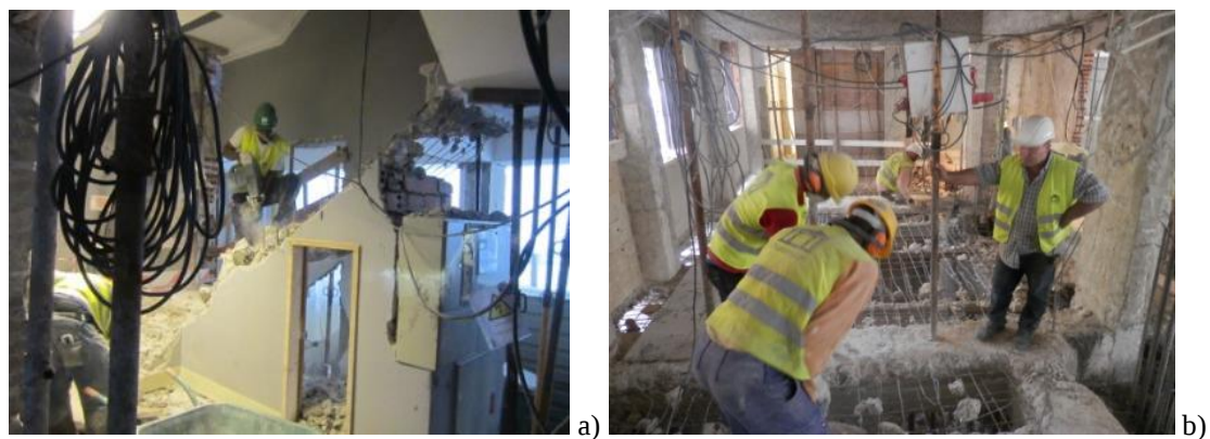
Figura 161 – Demolição: a) das escadas principais; b) da laje do piso 0
