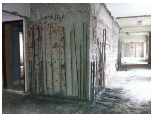
Figura 202 – Atravessamento da armadura para continuidade da execução da parede e colocação de armadura a integrar a laje de piso
