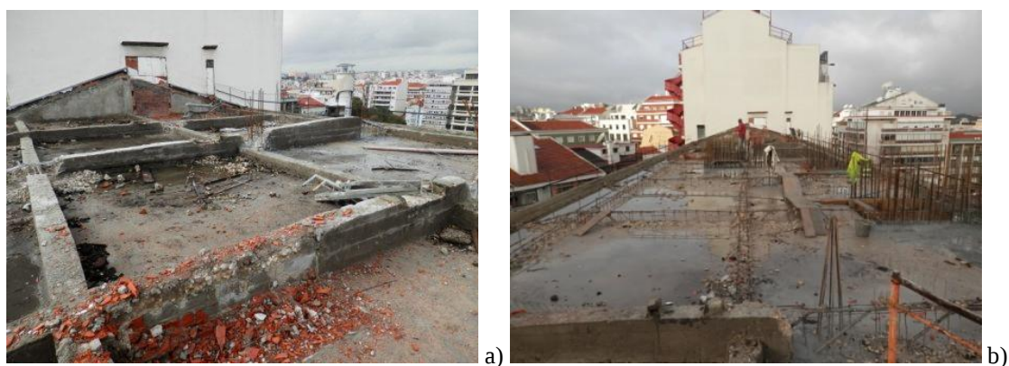
Figura 103 – Laje de cobertura: a) início da demolição das vigas existentes; b) conclusão da demolição das vigas existentes
