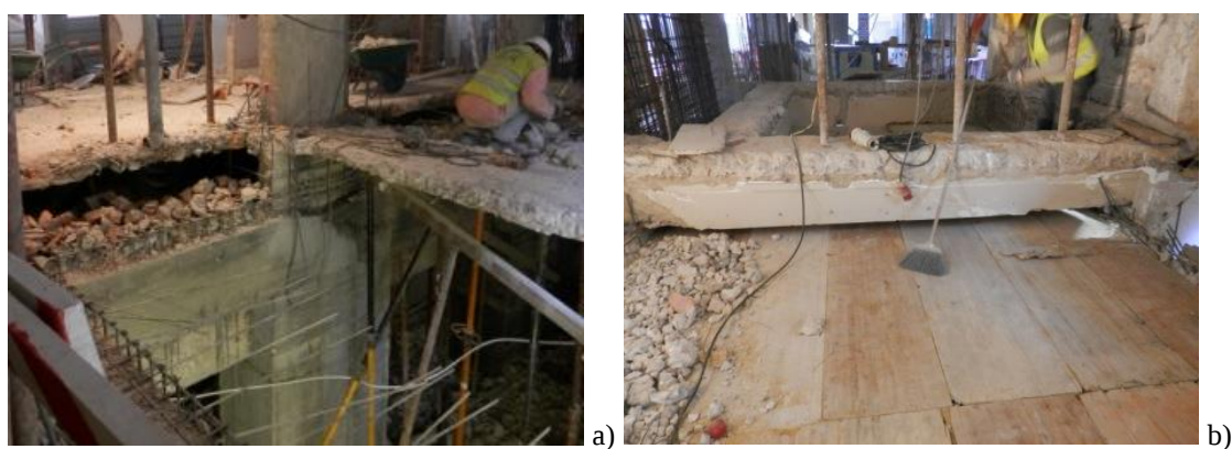
Figura 162 – Piso 0: a) laje após a remoção do betão; b) cofragem para execução da nova laje verificando-se as vigas existentes a demolir posteriormente
