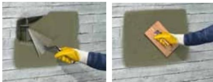
Figura 29 – Técnicas de reparação manual: argamassa colocada à colher
