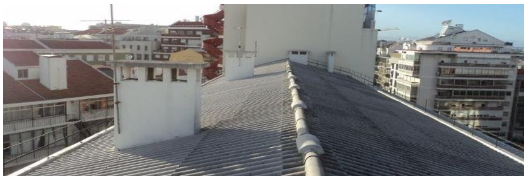
Figura 71 - Vista exterior da Cobertura
