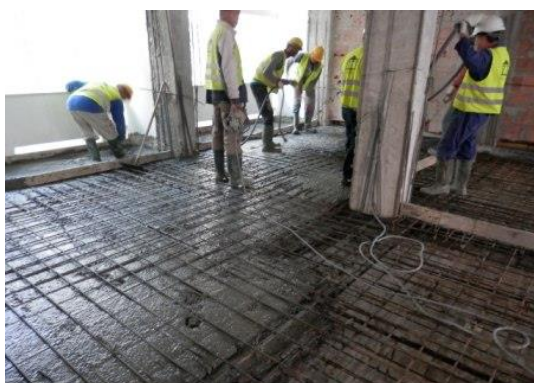
Figura 184 - Laje do piso 1: a) betonagem; b) recurso a equipamento de bombagem do betão
