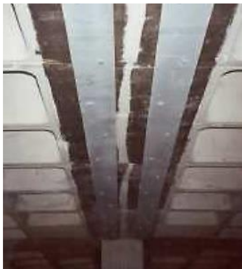
Figura 36 – Reforço de viga nervurada por colagem de chapas metálicas
