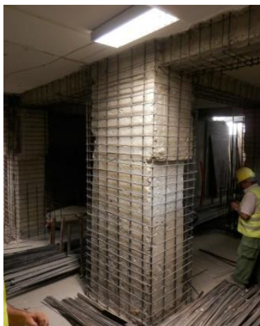
Figura 145 – Vista da armadura longitudinal e transversal
