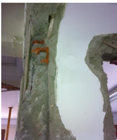
Figura 86 – Sondagem efetuada em pilares dos pisos superiores: a) existência de outros elementos na constituição do pilar de betão; b) restos de elementos cerâmicos
