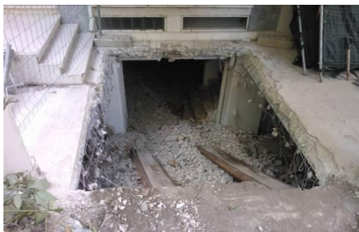
Figura 111 – Demolição da laje da galeria (piso 0)
