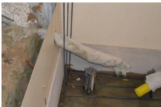
Figura 127 – Execução da microestaca no poço de bombagem
