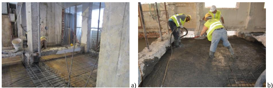
Figura 164 – Laje do piso 0: a) armadura da laje; b) betonagem da laje
