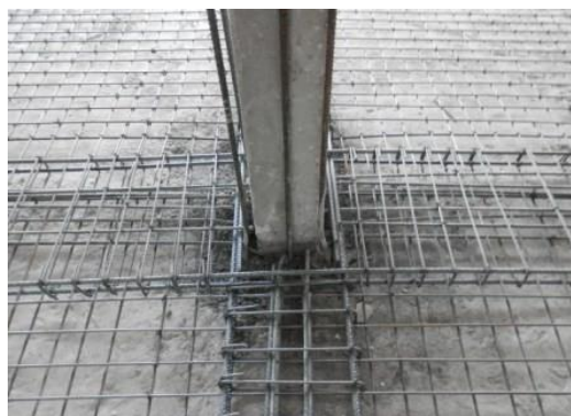
Figura 183 – Armação de nervuras da laje fungiforme junto de um pilar – piso 1
