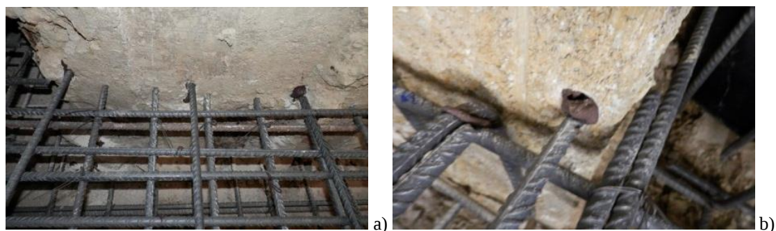
Figura 135 – Laje de ensoleiramento: a) selagem dos varões aos pilares existentes; b) pormenor da selagem dos varões
