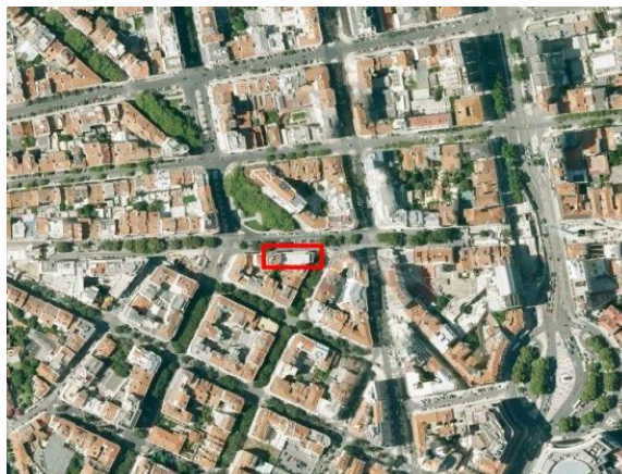
Figura 48 - Localização do edifício (Google Maps)
