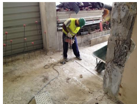
Figura 148 – Furação na laje, para futuro reforço das vigas no piso 0
