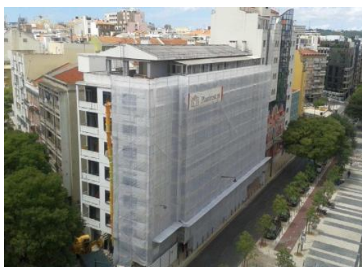
Figura 50 – Vista geral do edifício após o arranque da empreitada de reforço
