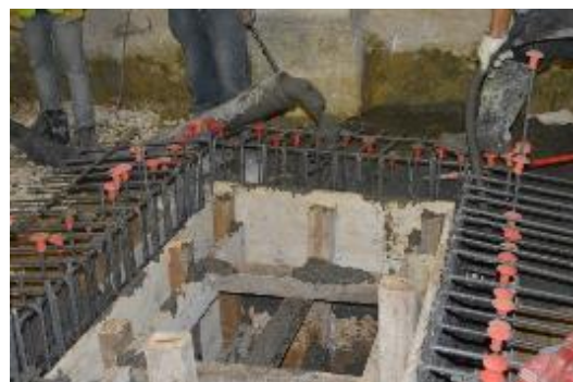
Figura 128 – Betonagem o poço de bombagem
