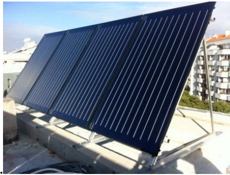
Figura 213 – Instalação de painéis solares na cobertura
