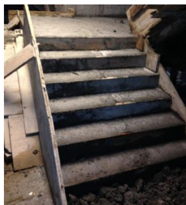
Figura 185 – Escadas centrais do piso 0 ao piso 1: a) preparação da cofragem em madeira; b) betonagem
