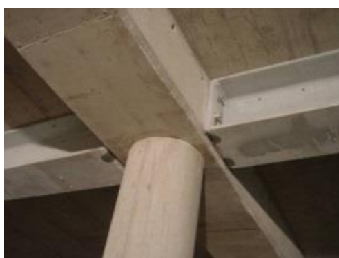
Figura 38 – Perfis soldados às chapas de testa e fixados à viga de betão armado
