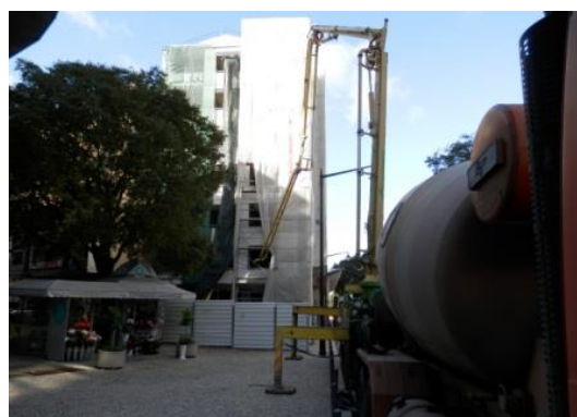
Figura 184 - Laje do piso 1: a) betonagem; b) recurso a equipamento de bombagem do betão
