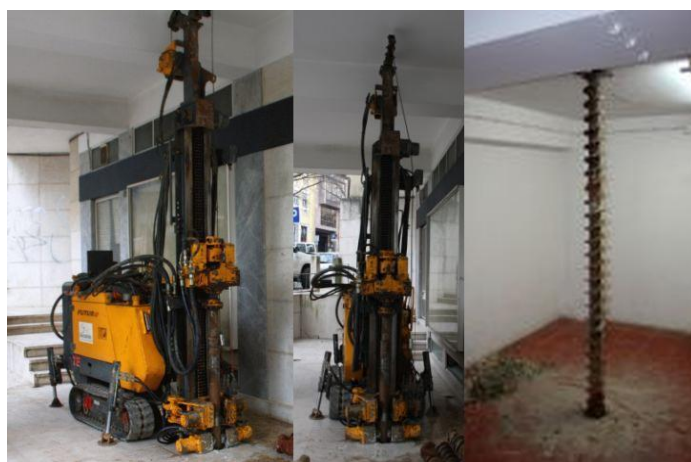
Figura 60 - Execução de furação para estudo geotécnico
