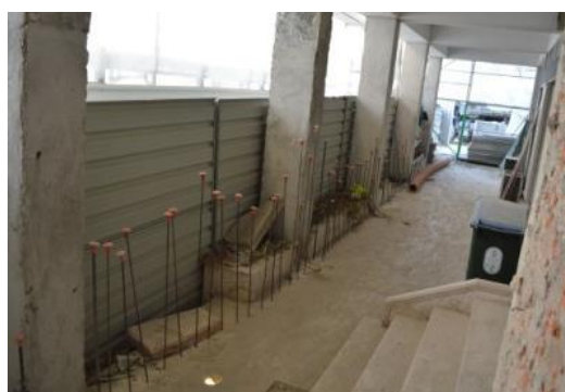
Figura 208 – Atravessamento das armaduras que constituem a parede periférica norte, a integrar a laje do piso 0, na zona da galeria.
