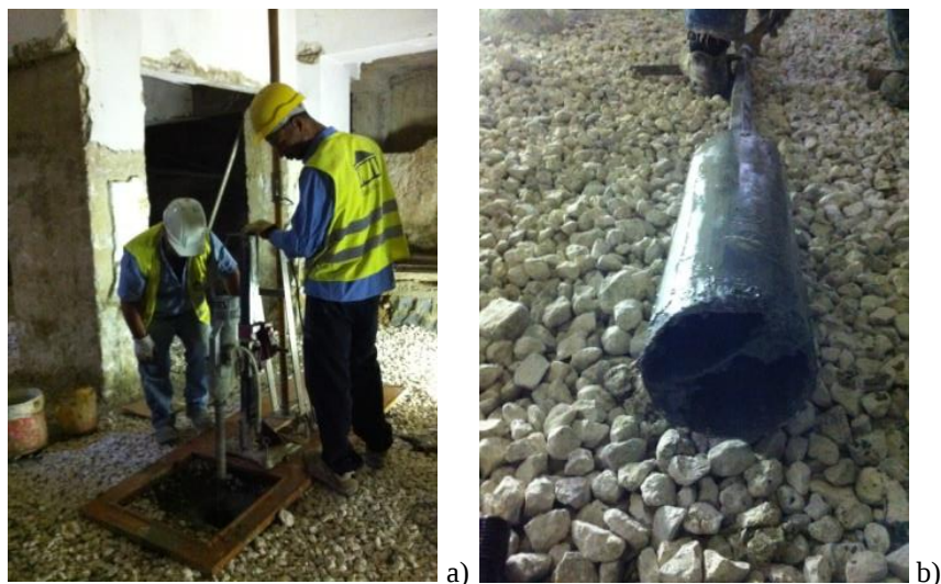
Figura 121 – Limpeza do fundo do furo: a) recurso a carotadora; b) adaptação da coroa
