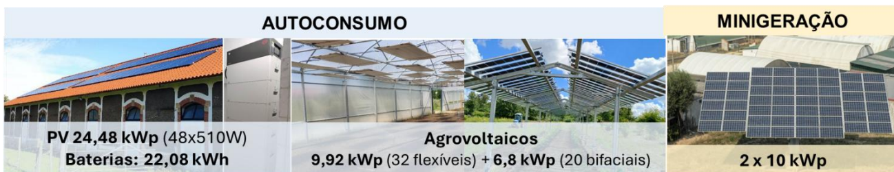
Figura 25 – Tecnologias de produção de energia fotovoltaica no AgroBioTech.
