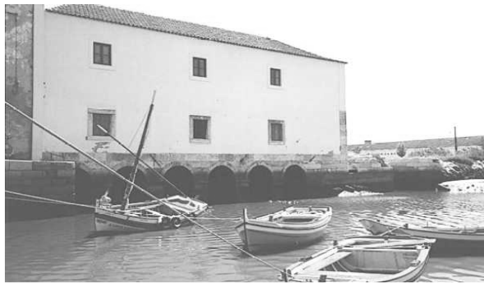
Figure 9: Moita mill (Moinho do Cais).
