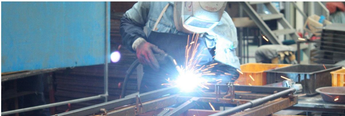
Figura 20 Equipamento de Soldadura e Armação
