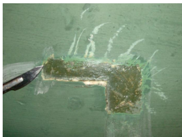
Fig. 106 Tom original (verde escuro) do interior dos caixotões vazios, durante um teste de limpeza.
