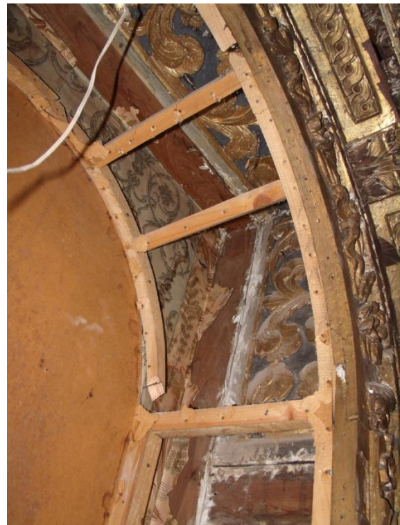
Fig. 113 Aspecto do nicho de um dos retábulos com a talha original e paralelepípedo.
