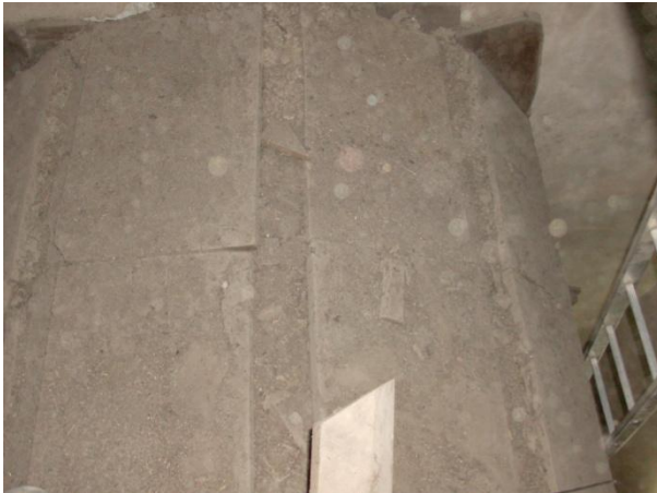
Fig. 171 Tardo do nicho em abóbada de berço, antes da limpeza.
