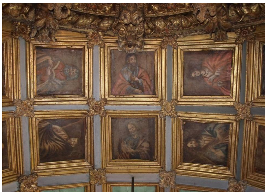
Fig. 193 Pormenor do teto antes da intervenção.
