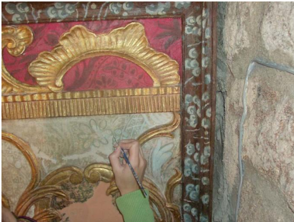
Fig. 155 Reintegração da decoração do fundo do frontal da mesa de altar do retábulo colateral do lado da Epístola.
