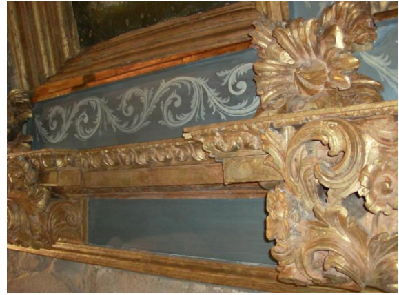
Fig. 192 Pannel da sanca sem qualquer decaração.
