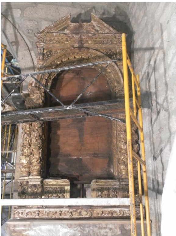
Fig. 142 Montagem do remate triangular.
