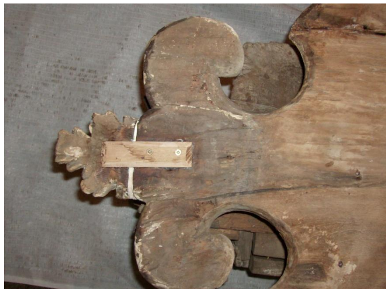
Fig. 117 Reforço estrutural, devido à fractura da peça.
