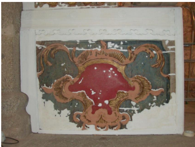
Fig. 150 Mesa de altar com os respectivos preenchimentos de lacunas (retábulo colateral do lado da Epístola).
