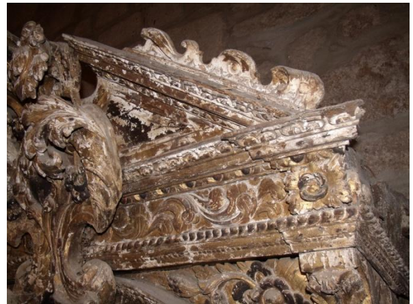
Fig. 88 Lacunas ao nível do ouro e bolo arménico (retábulo colateral lado da Epístola).
