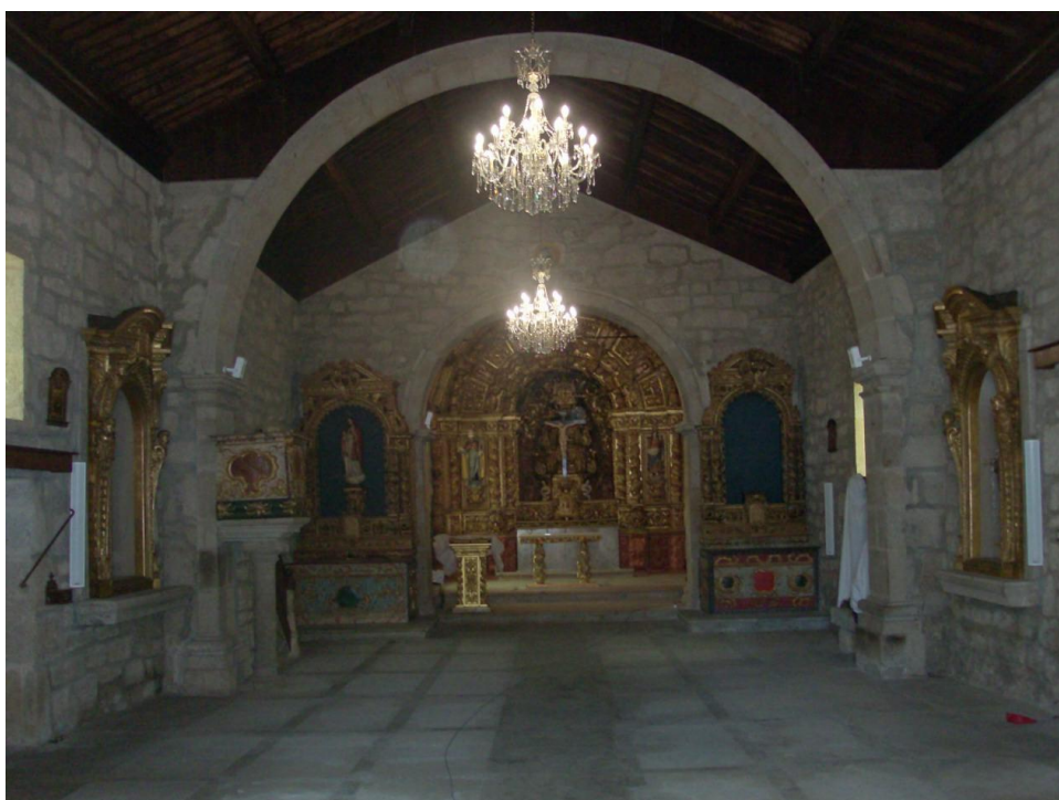
Fig. 189 Aspeto geral do interior da igreja depois da intervenção.
