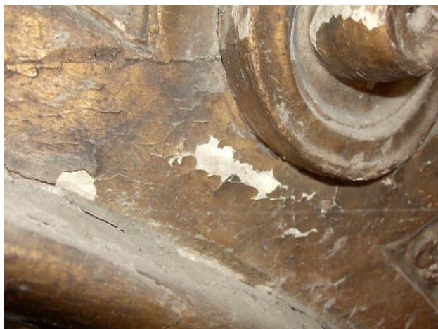
Fig. 95 Destacamento da camada de ouro (retábulo lateral lado do Evangelho).
