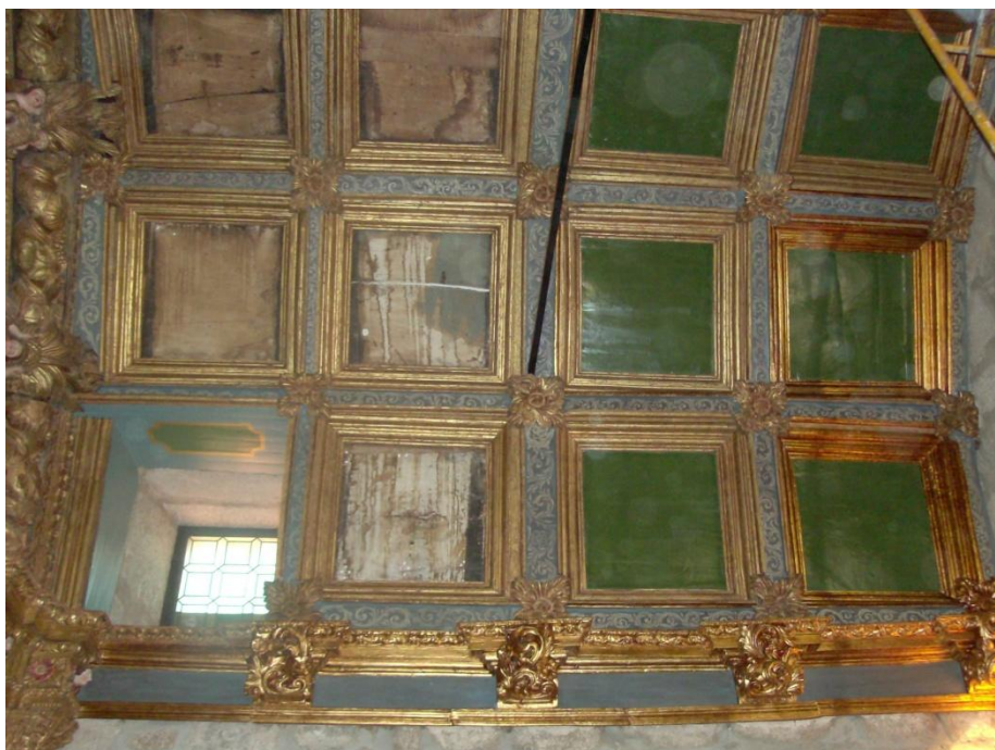
Fig. 196 Teto e sanca do lado da Epístola depois da intervenção (faltando as telas).
