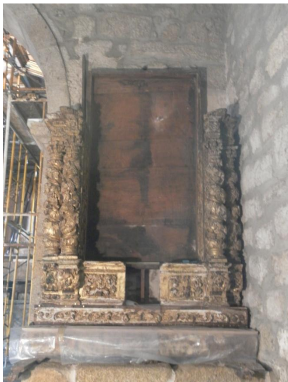
Fig. 140 Montagem das colunas.
