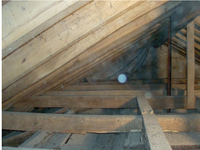
Fig. 178 Tardo do teto antes da intervenção.
