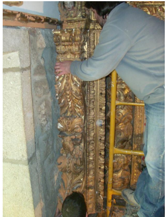
Fig. 100 Bloco maciço torcido (corpo do altar-mor).
