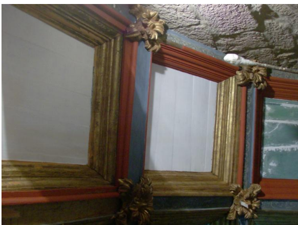
Fig. 186 Preenchimentos no interior dos cixotões vazios.
