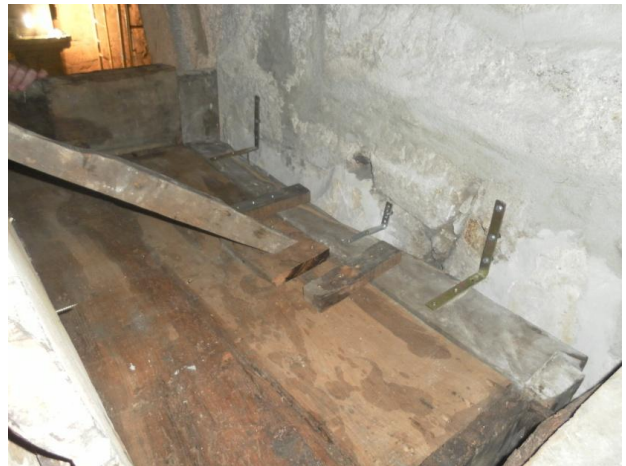
Fig. 145 Reforço estrutural com ligações metálicas em “L” (retábulo lado da Epístola).
