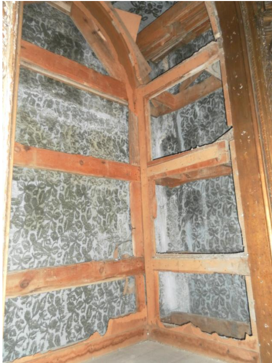
Fig. 93 Estrutura em madeira de um dos retábulos (lado do Evangelho).
