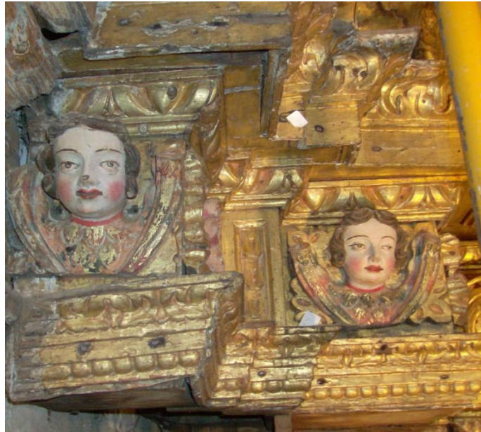
Fig. 174 Marcação de peças a branco para reforçar estruturalmente.
