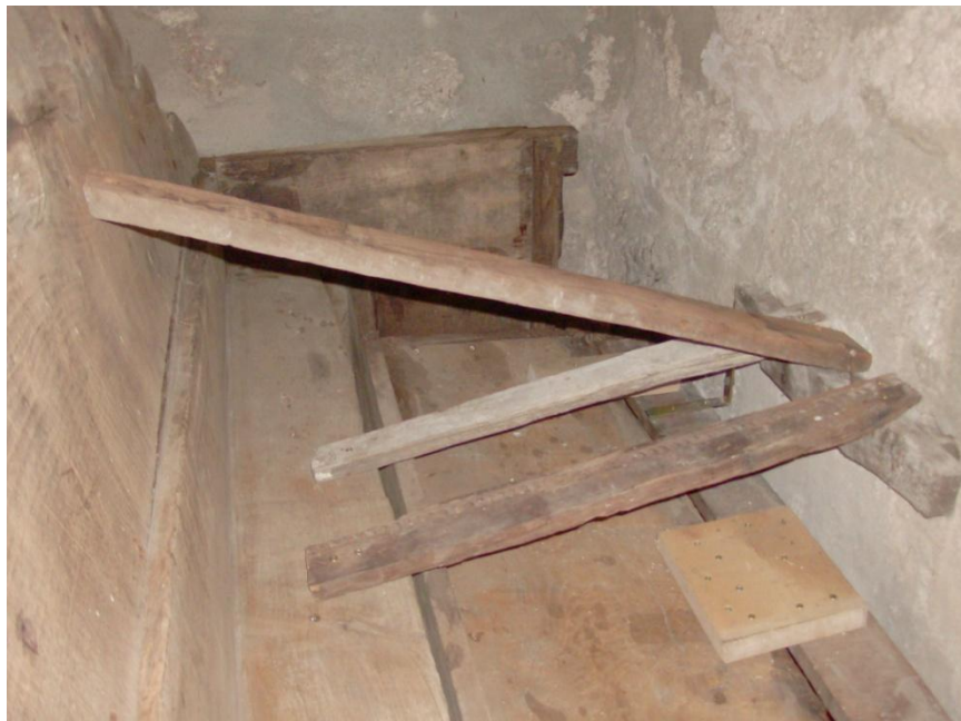
Fig. 146 Reforço estrutural com ligações metálicas em “L” (retábulo lado do Evangelho) e reforço com parafusos das madeiras originais.
