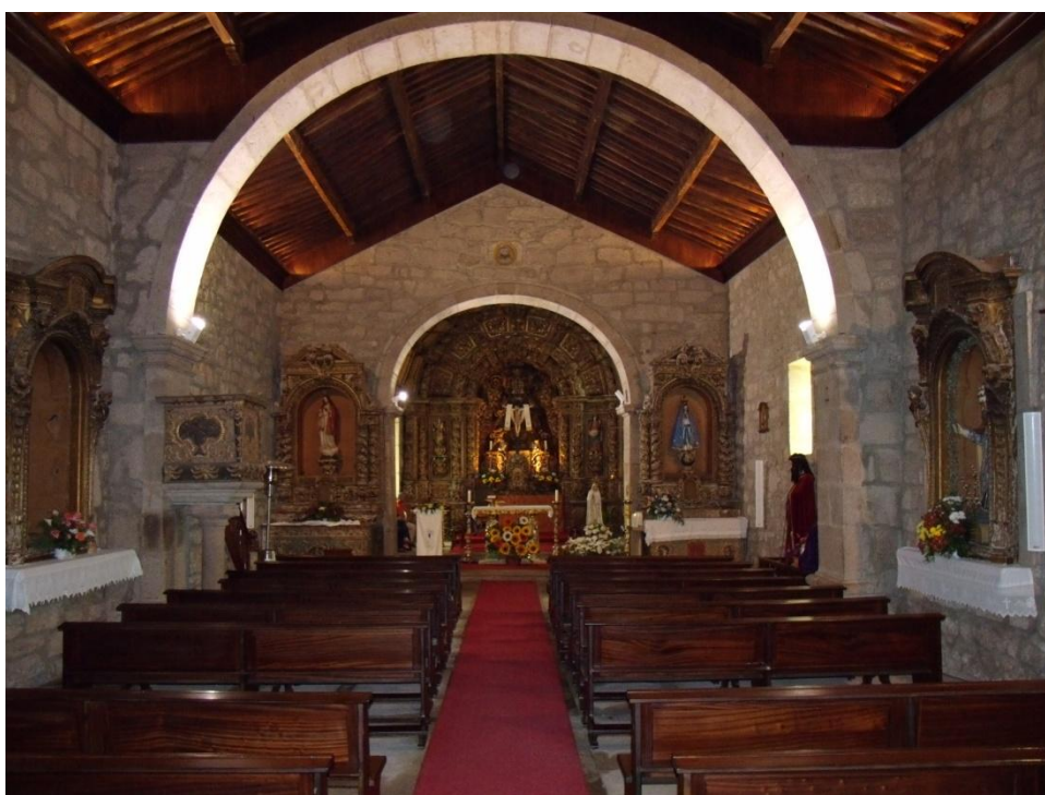
Fig. 188 Aspeto geral do interior da igreja antes da intervenção.
