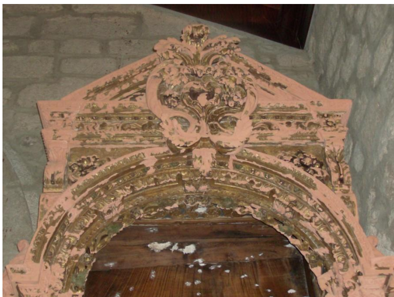
Fig. 149 Preenchimento ao nível do ouro no ático do retábulo do lado da Epístola.
