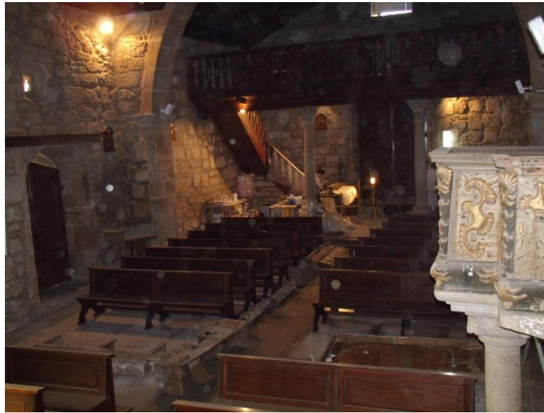
Fig. 109 Aspeto do estaleiro no incício das obras.
