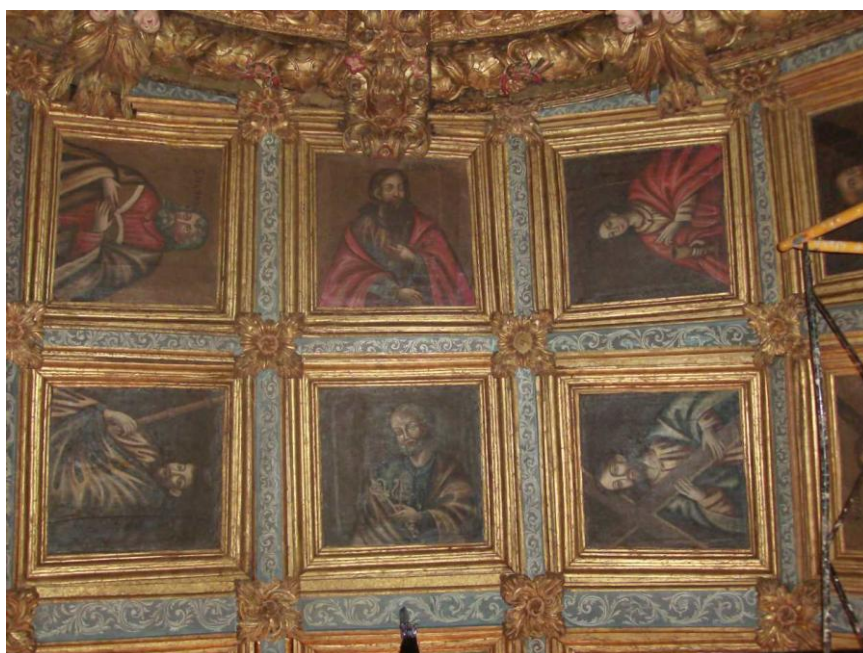
Fig. 194 Pormenor do teto depois da intervenção.
