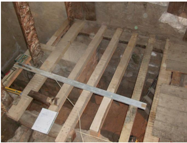
Fig. 181 Montagem da estrutura do soalho.
