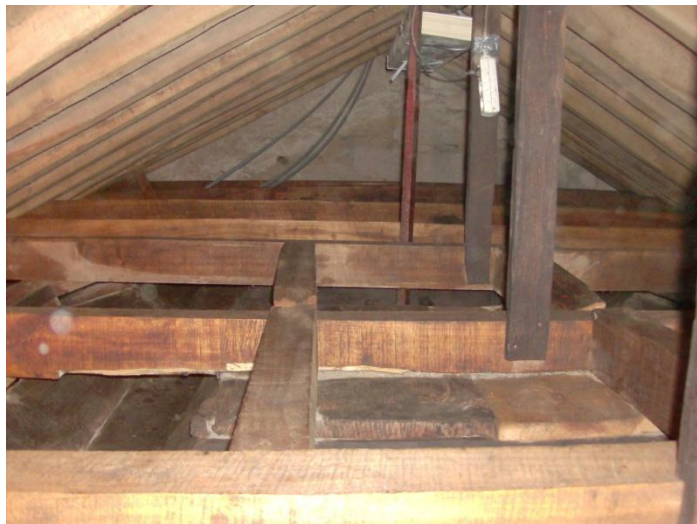
Fig. 179 Tardo do teto depois da intervenção.
