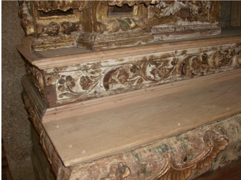
Fig. 132 Tampos de madeira substituídos (fotografia tirada após a montagem do retábulo).
