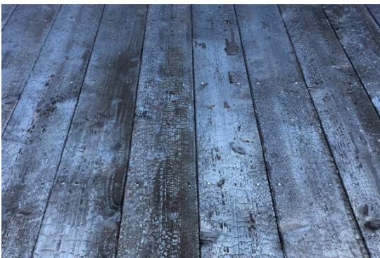
Procesos de quemado de revestimiento exterior equipamientos
