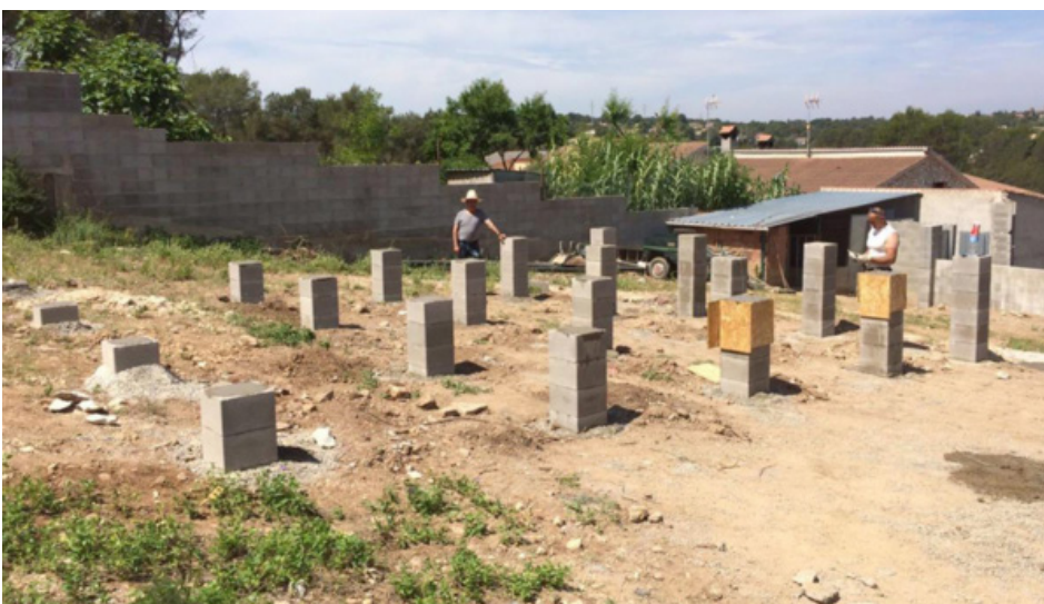
Bases regulares de hormigón armado tipo.
