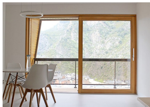
Puerta balconera de madera y puerta con perfiles de acero tipo a instalar
