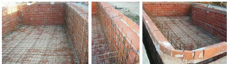
Fases ejecución vaso piscina.
