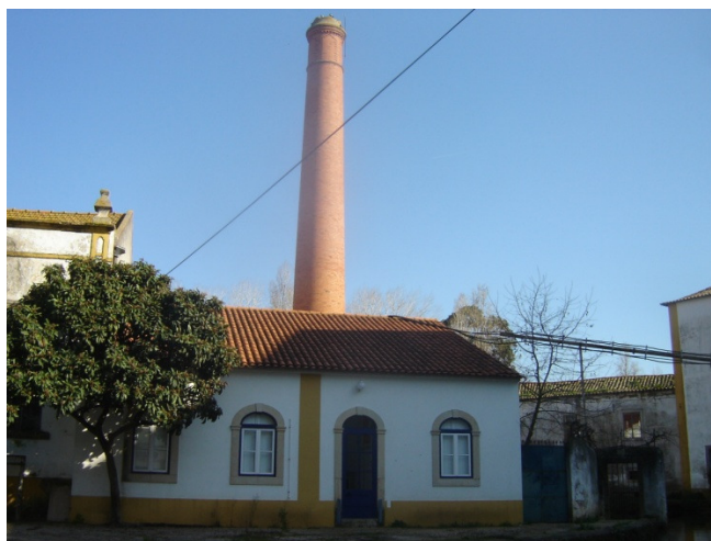
Figura 42 - Estado actual do edifício.
