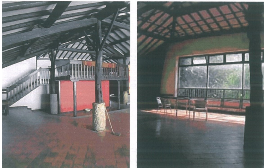
Figura 33 - Interior do edifício E06.
