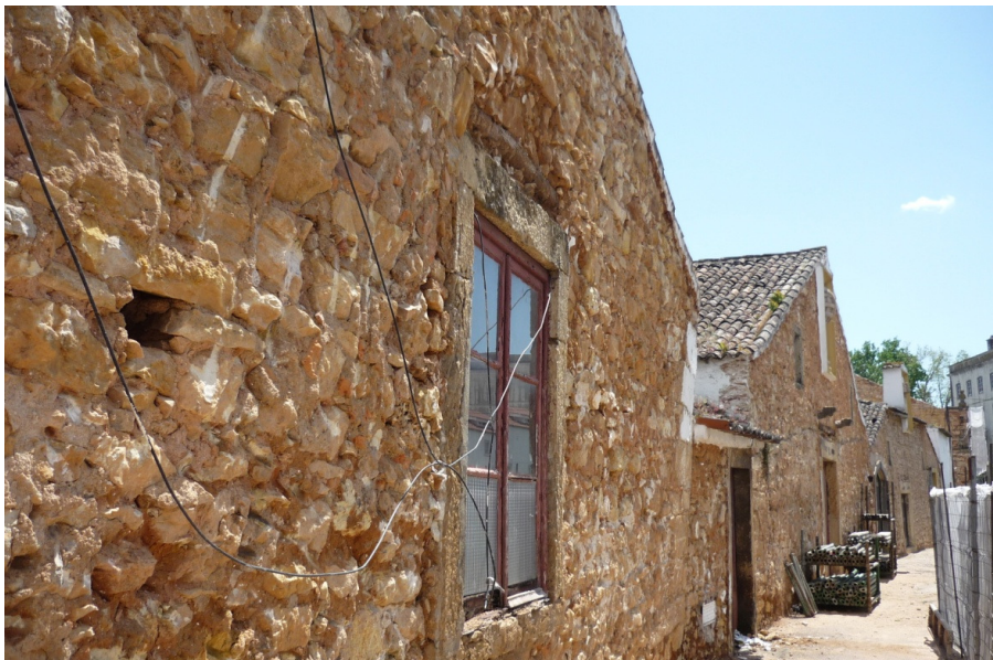
Figura 109: Fachadas exteriores após a remoção do revestimento.
