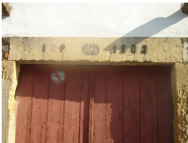
Figura 6 - Verga com as iniciais de João Torres Pinheiro e a data de 1903.
