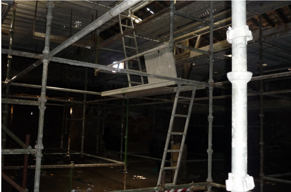
Figura 108: Andaime montado no edifício E03.
