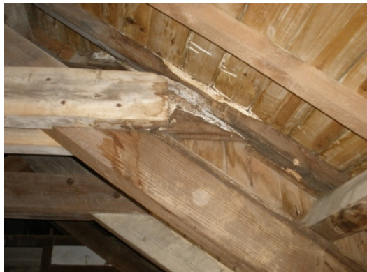
Figura 98:exemplo de consolidação com aplicação de novo elemento de madeira.
