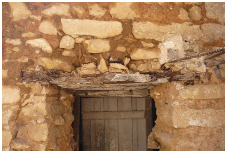
Figura 60 - Tipo de alvenaria (de juntas desalinhadas) encontrado nos edifícios em estudo.
