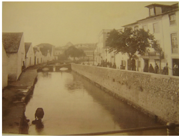
Figura 22 - Fotografia antiga onde não é visível a actual conduta de passagem de água (António da Silva Magalhães. Colecção Particular Ma H. Mota Lima. Arquivo Fotográfico Silva Magalhães).
