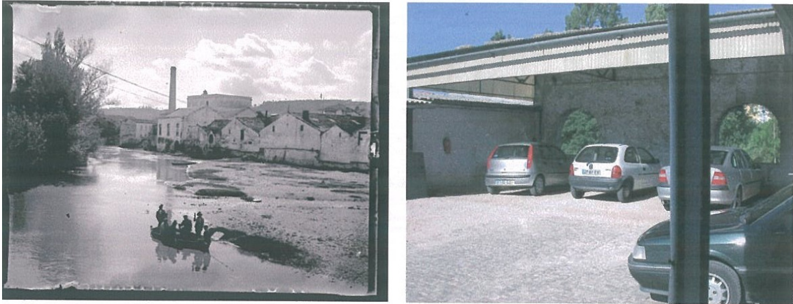
Figura 36 - Imagens do edifício antes das obras de adaptação a refeitório e no estado actual (António da Silva Magalhães. Coleção Particular Ma H. Mota Lima. Arquivo Fotográfico Silva Magalhães).
