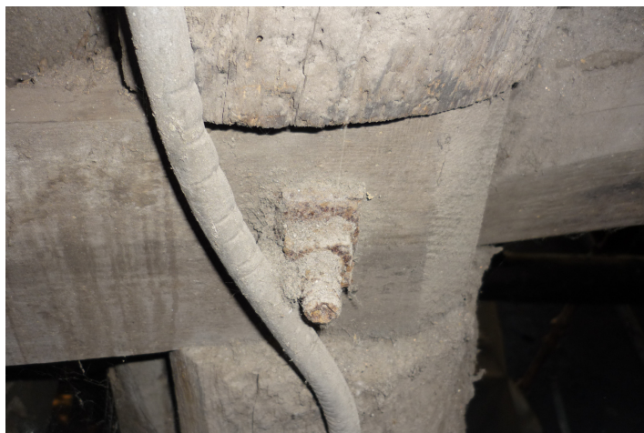
Figura 71 - Cavilhas de aço com sistema de aperto.
