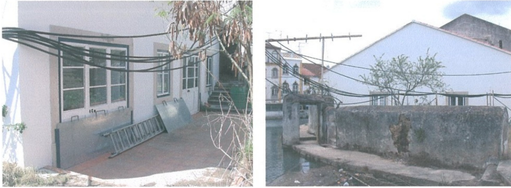
Figura 43 - Tardoz do edifício actual.
