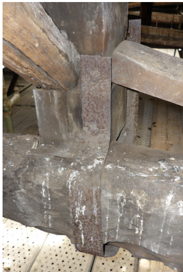
Figura 72 - utilização de braçadeiras como reforço nas ligações.
