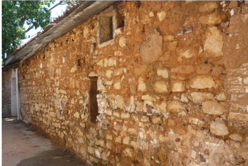
Figura 61 - Paredes de alvenaria de pedra com assentamento aleatório e juntas desalinhadas.
