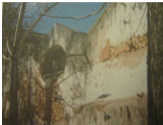
Figura 23 - Edifício E02 no estado actual
