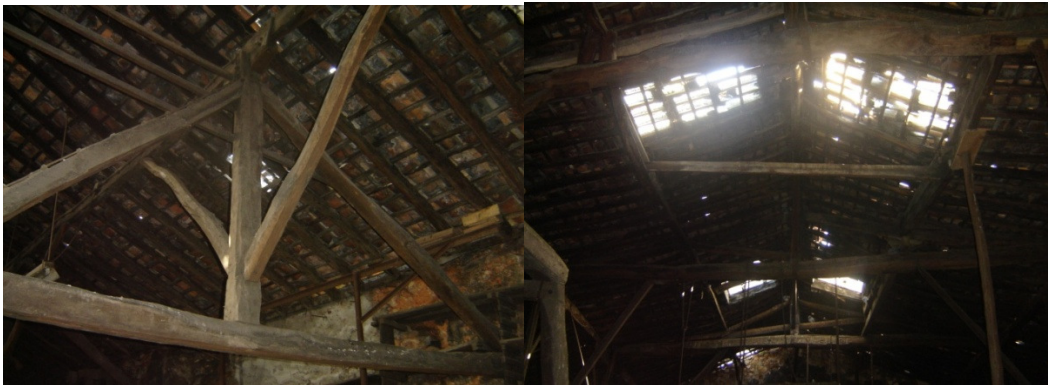
Figura 67: fotografia da cobertura onde podem ser observados os seus constituintes.
