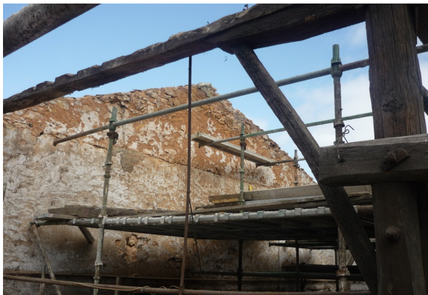
Figura 110: E03 após a remoção dos elementos de cobertura.
