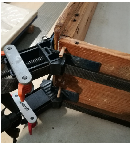
Figura 103- Pormenor das cintas de aperto durante a montagem da estrutura do gavetão. Fonte: própria
