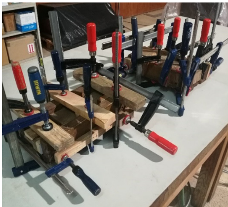
Figura 106- Montagem das peças que compõe as estruturas paralelepípedicas laterais ao gavetão. Fonte: própria
