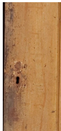
Figura 68- Perda de policromia na área da fechadura da porta esquerda do armário. Fonte: Lab.Foto IPT
