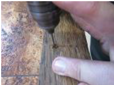
Figura 74- Processo de remoção de acessórios metálicos com mini-berbequim. Fonte: Maria Folgado
