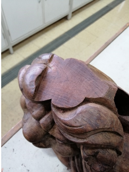
Figura 82- Vista superior do nivelamento das superfícies de contacto entre a madeira original e a de preenchimento. Fonte: própria
