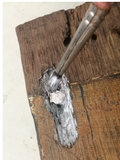
Figura 78- Aplicação de cola branca na superfície para posterior aplicação de pasta Rayon®. Fonte: própria
