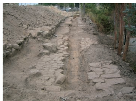
fig. 23 e 24 Rua da Quelha. Diferentes momentos de pavimentação da rua.
