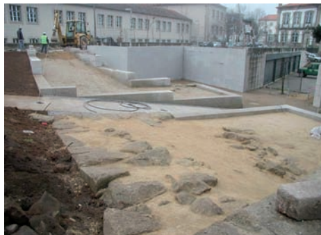
fig. 42 e 43 Vistas gerais da Porta Norte após o Restauro.
