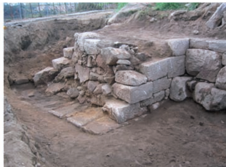
fig. 4 Vista geral da Muralha e torreão leste após limpeza dos níveis de aterro.
