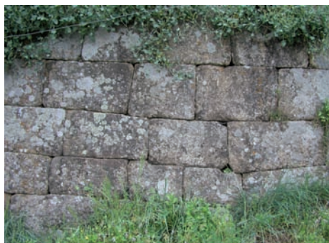
fig. 10 Pormenor do paramento externo da muralha.
