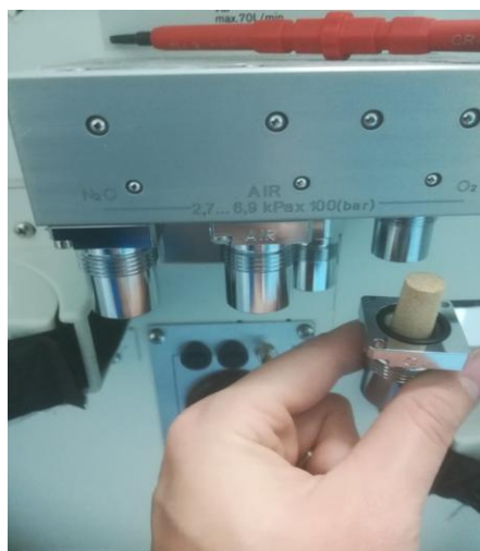
Figura 58 - Substituição dos filtros da entrada de gás
