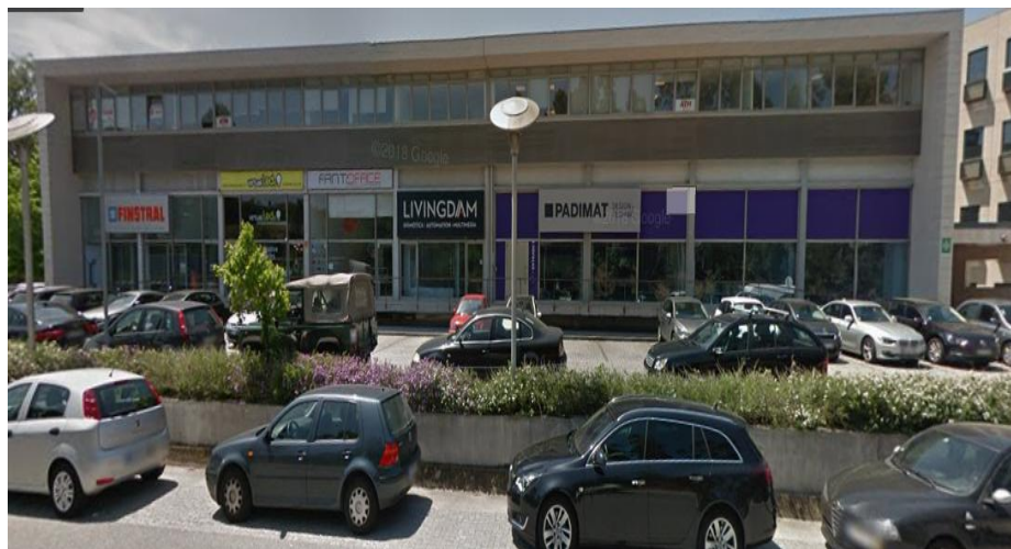
Figura 3 - Sucursal ATM-Manutenção Total na cidade da Maia
