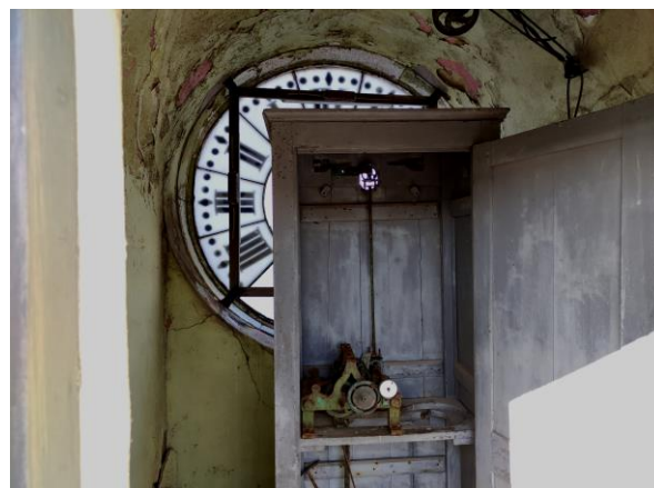
Figura 83 – Relógio – Interior Fachada Poente Fonte: Autor
