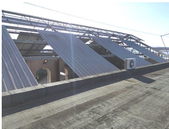
Figura 77 – Cobertura Inclinada de duas Águas Gare Fonte: Autor
