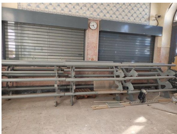
Figura 72 – Sala de Espera – Foto 1 Fachada Poente Fonte: Autor
