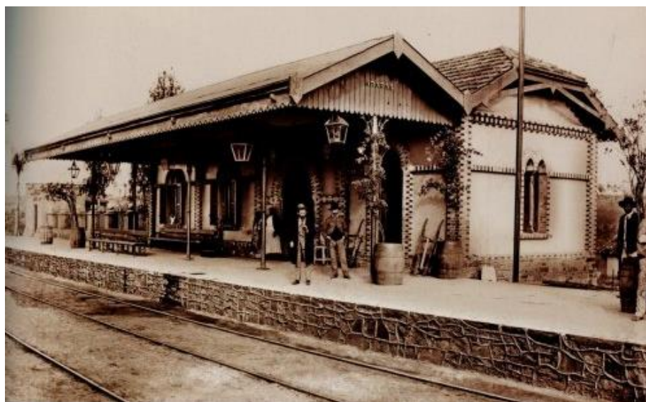
Figura 125 – Estação Ferroviária de Araras
