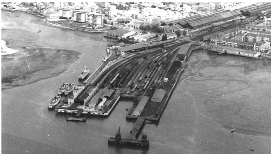
Figura 20 – Complexo Ferroviário do Barreiro
