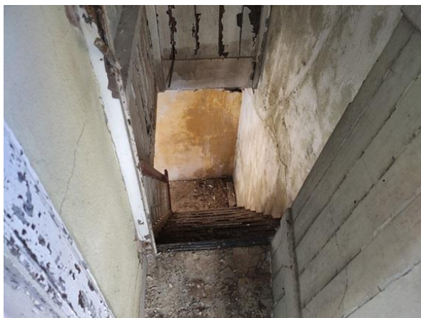
Figura 60 – Escadas de Acesso – Torre 1 Fachada Poente Fonte: Autor
