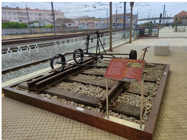
Figura 107 – Elementos Básicos da Via Férrea Fonte: Autor
