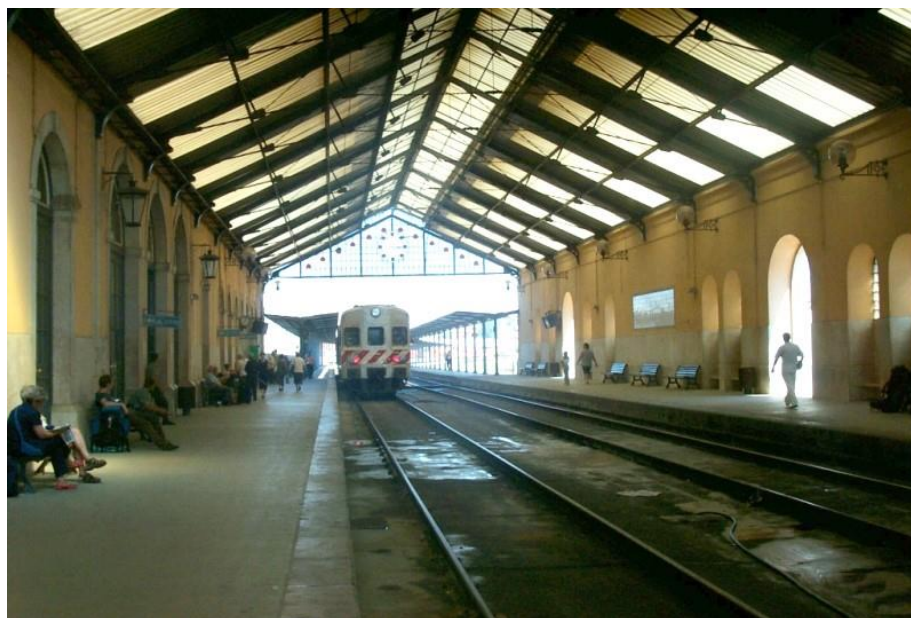
Figura 54 – Estação Ferro-Fluvial Barreiro Mar – Gare Fonte: https://pt.m.wikipedia.org/wiki/Ficheiro:Barreiro_Station_Lisboa.jpg
