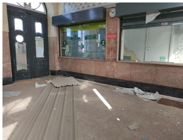
Figura 73 – Sala de Espera – Foto 2 Fachada Poente Fonte: Autor
