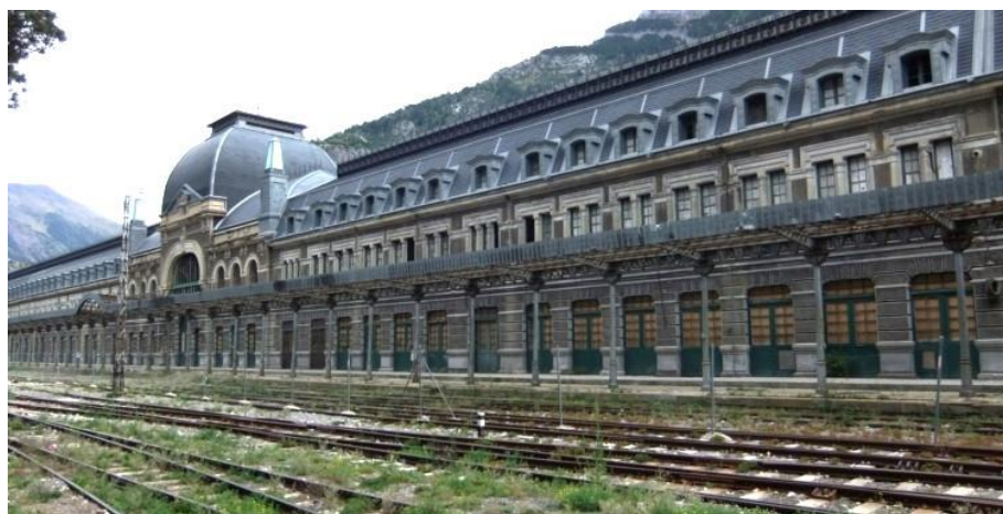
Figura 112 – Estação de Canfranc – Instalações abandonadas – Foto 1 Fonte: https://www.nit.pt/
