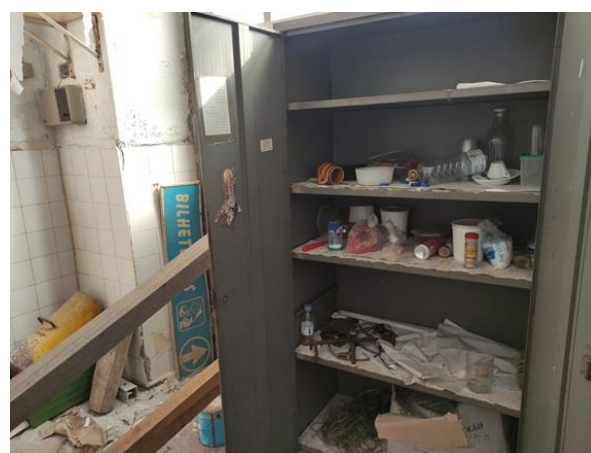
Figura 65 – Zona Técnica 2 Fachada Poente Fonte: Autor
