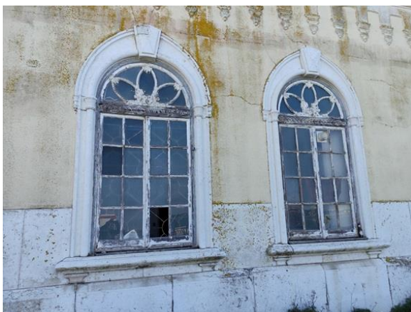
Figura 78 – Janelas – Piso Térreo Fachada Poente Fonte: Autor
