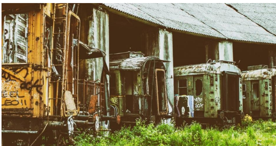
Figura 113 – Estação de Canfranc – Instalações abandonadas – Foto 2 Fonte: https://experience.acciona.com/transport/new-canfranc-station/
