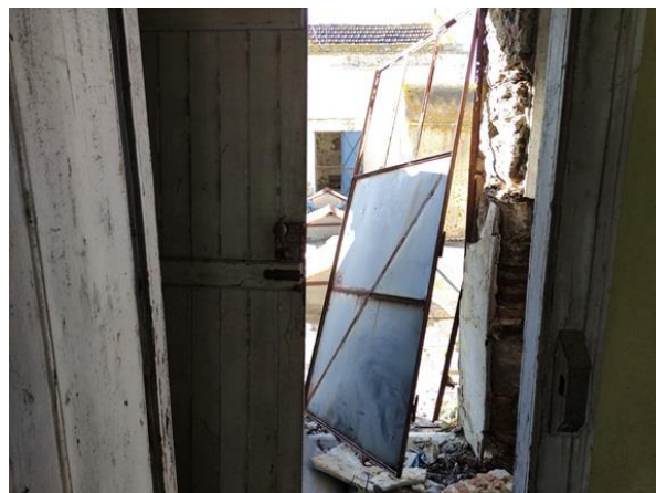
Figura 57 – Porta Cobertura – Fachada Poente Fonte: Autor
