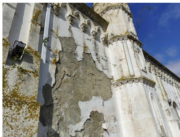
Figura 75 – Parede Exterior – Revestimento Fachada Nascente Fonte: Autor
