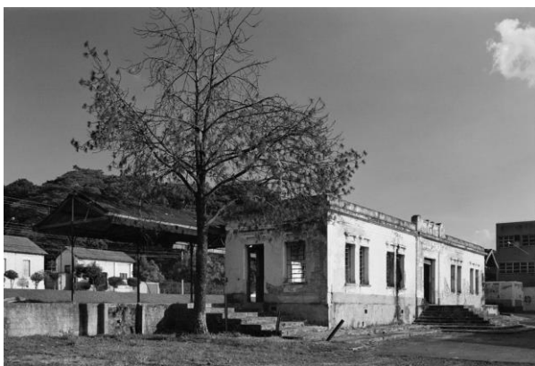
Figura 126 – Estação Ferroviária de Araras Instalações abandonadas – Foto 1 Fonte: Nelson Kon – AUM Arquitetos
