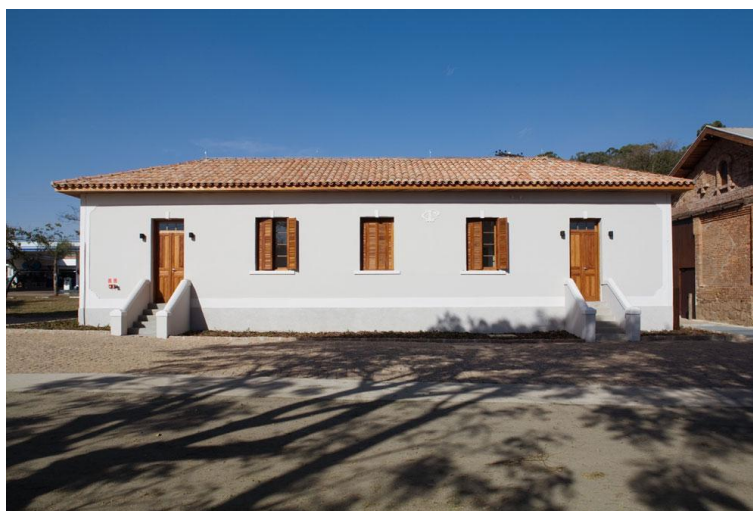
Figura 137 – Centro Cultural Araras – Edifício de apoio ao Centro Cultural Fonte: Nelson Kon – AUM Arquitetos
