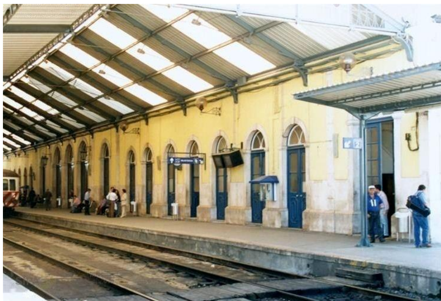
Figura 47 – Estação Ferro-Fluvial Barreiro Mar – Alçado Principal – Fachada Poente/Gare Fonte: https://restosdecoleccion.blogspot.com/
