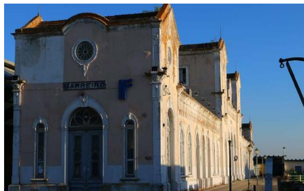
Figura 24 – Estação Ferro-Fluvial Barreiro Mar Vista Atual Fonte: APAC, Agosto 2016
