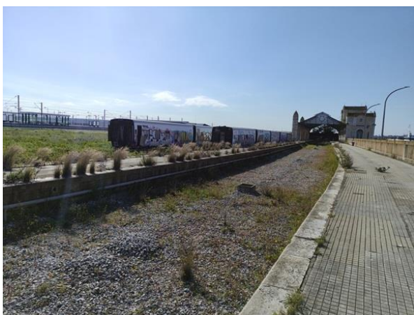
Figura 86 – Canal Ferroviário Plataformas de embarque – Exterior Fonte: Autor
