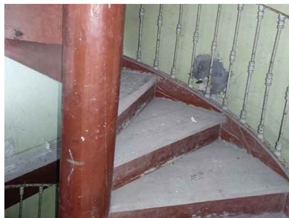
Figura 61 – Escadas de Acesso – Torre 2 Fachada Poente Fonte: Autor
