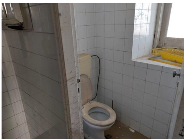
Figura 68 – Instalações Sanitárias – Foto 1 Fachada Poente Fonte: Autor
