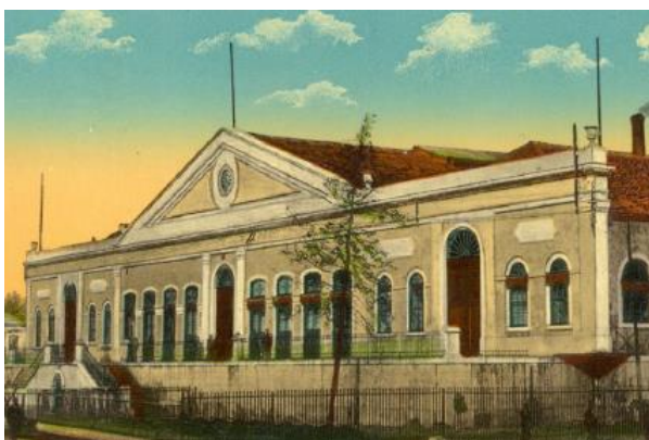
Figura 29 – Primitiva Estação Ferroviária do Barreiro – 1910 Fonte: J. Fernandes Alves e C. a
