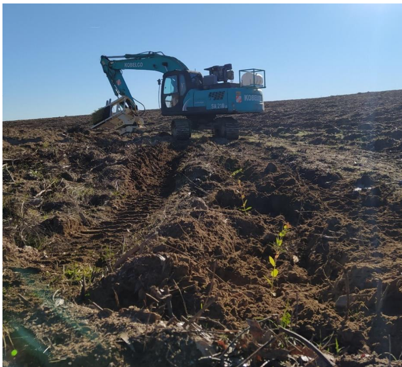
Figura 22 - Estado da instalação de plantas após a preparação do terreno com meios tradicionais e a plantação com recurso à alfaia Risutec.
