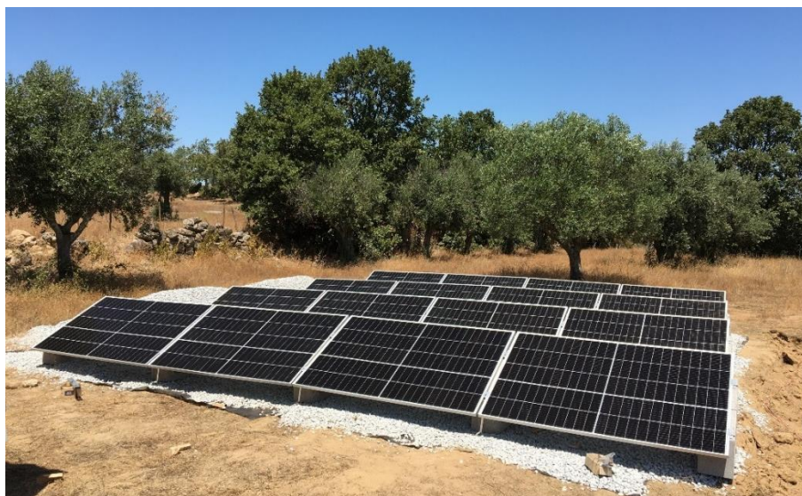
Figura 6.31 - Implantação dos módulos no terreno após a devida preparação do terreno.
