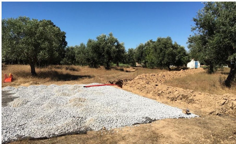
Figura 6.30 - Preparação do local da implantação com manta geotêxtil e gravilha.
