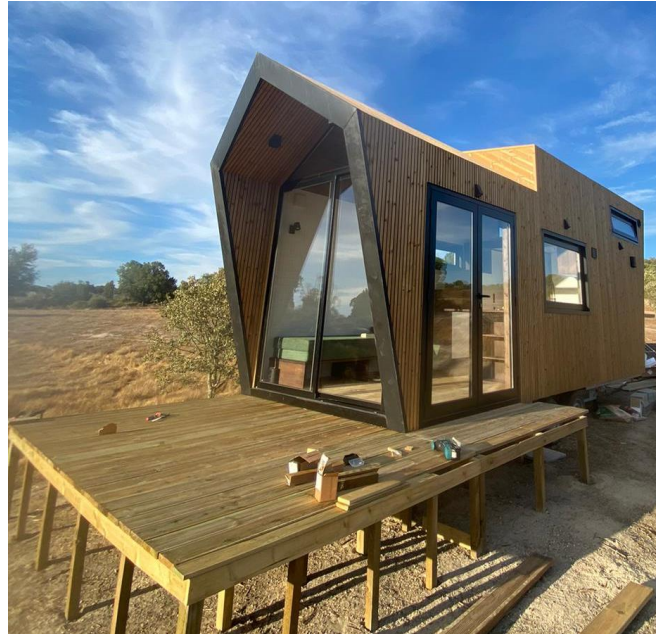
Figura 6.45 - Tiny house, local para estudo do sistema fotovoltaico OFF-Grid .
