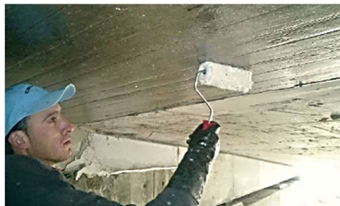
Figura 93 – Aplicação de primário [36]
