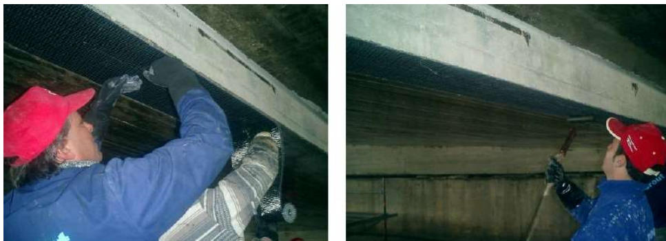
Figura 94 – Aplicação da manta e impregnação com a ajuda de rolo [36]
