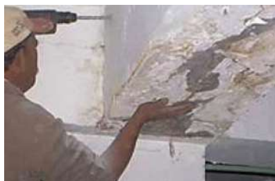
Figura 70 – Furação da superfície [30]
