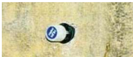
Figura 54 – Sonda para medir o teor de humidade do betão in-situ [5]
