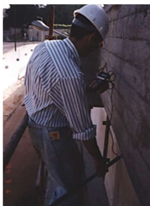
Figura 53 – Medição dos potenciais eléctricos em obra [24]
