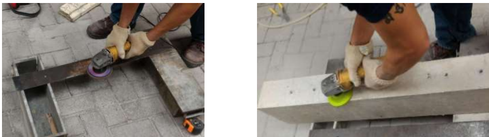
Figura 88 – Limpeza das superfícies de chapas de aço e betão [34]
