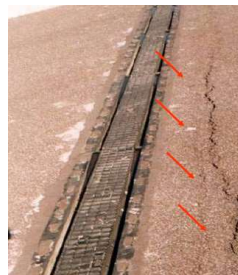
Figura 31 – Fissuração devido a cargas excessivas [5]
