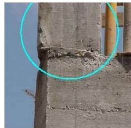
Figura 7 - Erro de geometria do pilar [5]
