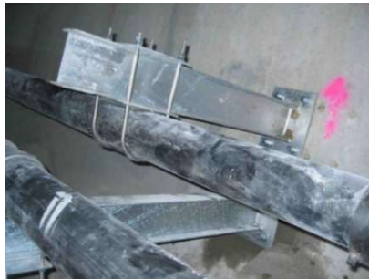
Figura 101 – Fixador metálico anti vibratório ligado a uma estrutura de betão armado [40]
