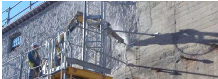
Figura 80 – Preparação do substrato [31]
