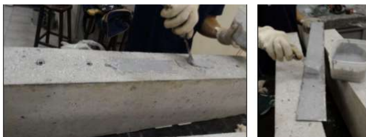
Figura 89 – Aplicação de resina epóxida nas chapas e no betão [34]
