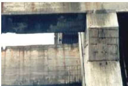
Figura 15 – Deficiente recobrimento [7]
