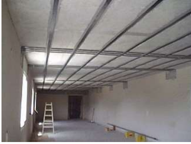
Figura 91 – Laminados aplicados em laje [35]
