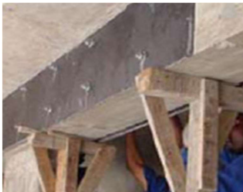
Figura 87 – Reforço por adição de chapas coladas [33]
