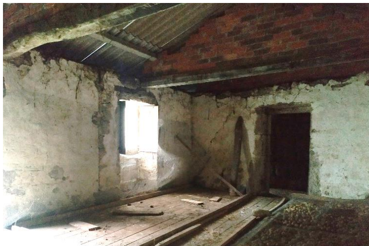
Fig. H11. Interior. Sala.
