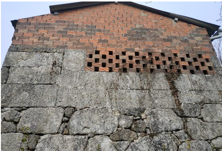
Fig. H9. Fachada sur.
