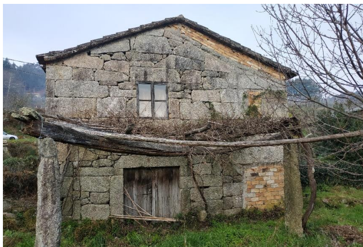
Fig. G6. Fachada sur
