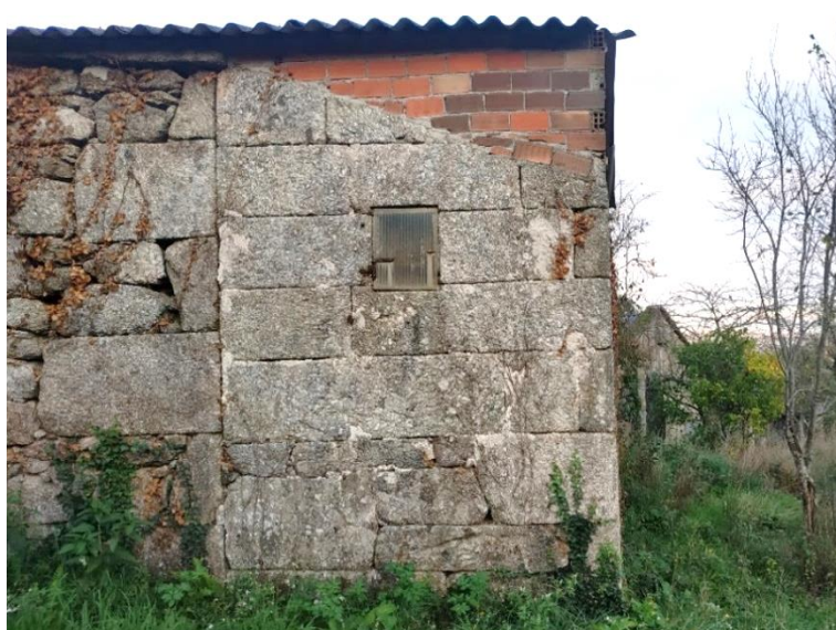
Fig. H6 e H7. Fachada leste e oeste.
