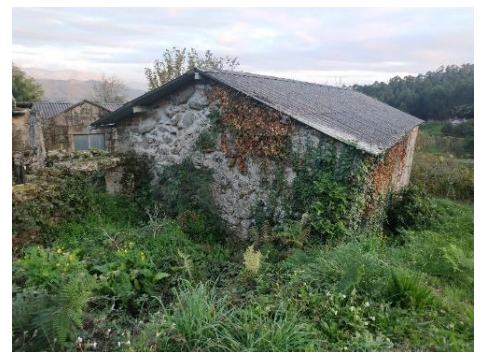
Fig. H10. Fachada norte.
