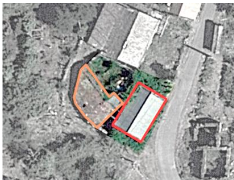
Fig. C1. Implantación. Vista aérea. S/E. ↑N
