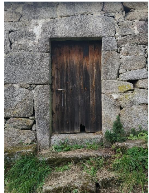
Fig. H14. Porta de acceso á primeira planta na fachada leste.
