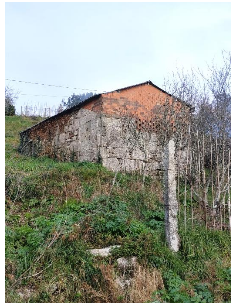
Fig. H8. Fachada sur.
