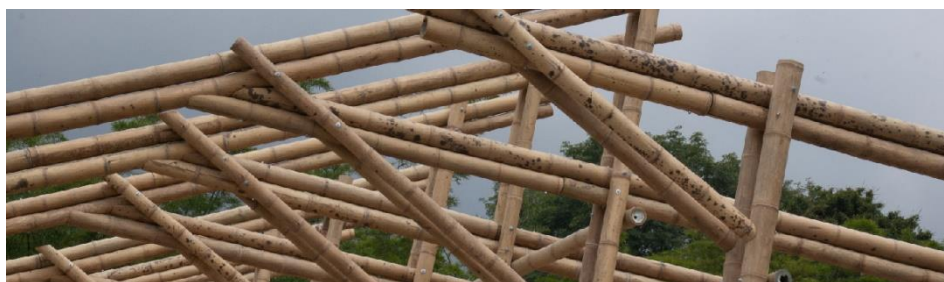
Fig. 104. estrutura dunha cuberta en canas de bambú
