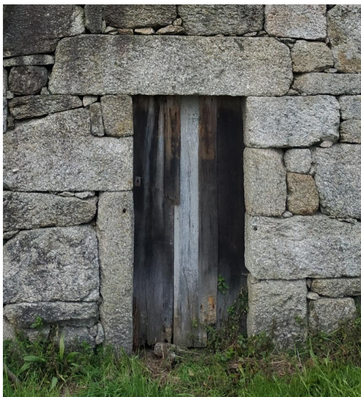
Fig. C10. Porta na fachada leste
