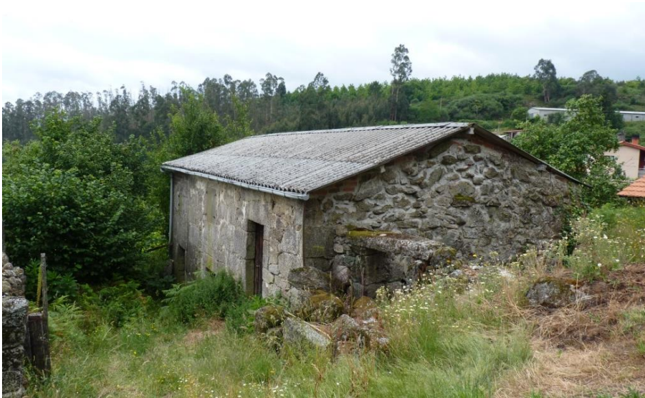
fig. 86. Fotografía da vivenda 08, fachada norte e leste.
