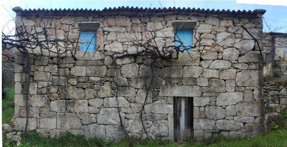
Fig. 84. Fotografía da vivenda 03, fachada leste.
