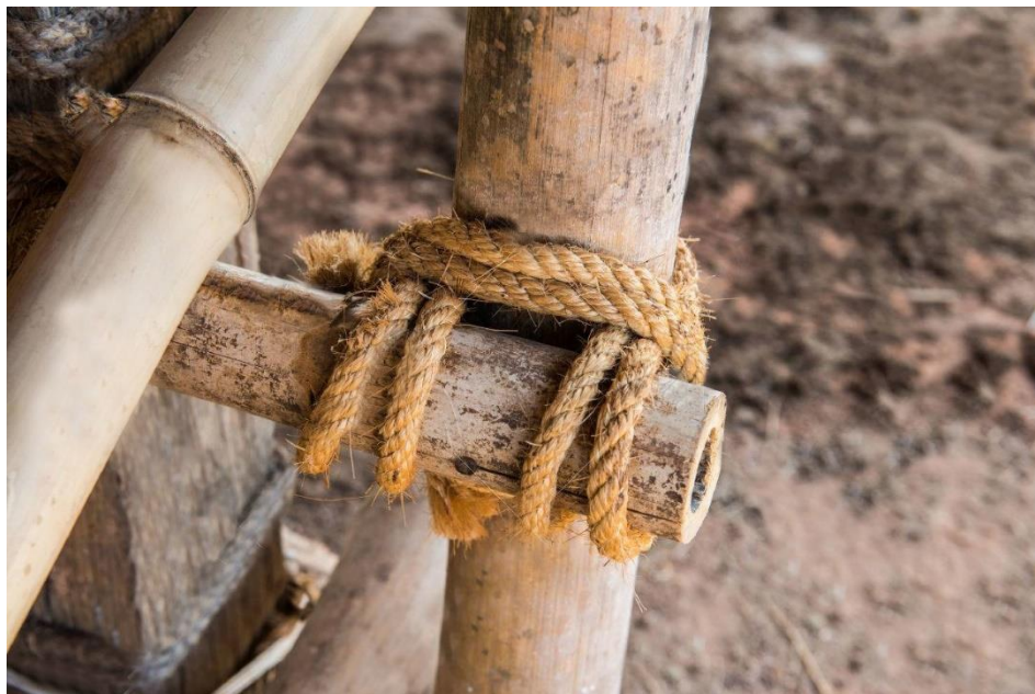
Fig. 105. Atado da estrutura en canas de bambú.
