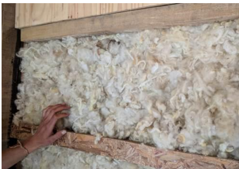
Fig. 107. Instalación de illamento de lá de ovella a granel.
