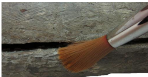
FIG. 72: Limpeza superficial de poeiras e sujidades com pincel de cerdas macias. (Autoria própria, 2013.)
