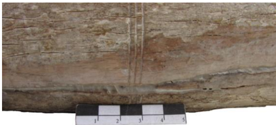
FIG. 49: Pormenor onde é visível o adesivo resultante de uma intervenção posterior, na fenda convexa. (Autoria própria, 2013.)
