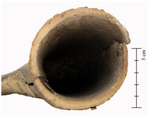
FIG. 60: Distorção volumétrica evidenciada na base da campânula. (Autoria própria, 2013.)
