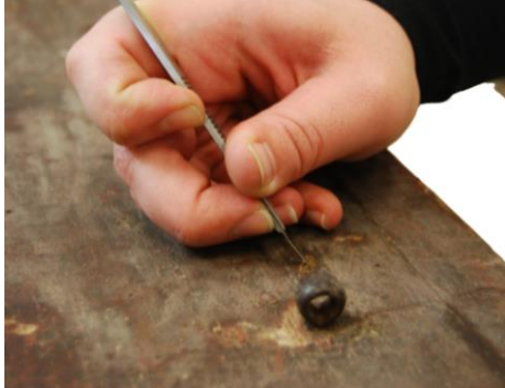
FIG. 169: Desoxidação dos elementos metálicos. (Autoria própria, 2012)
