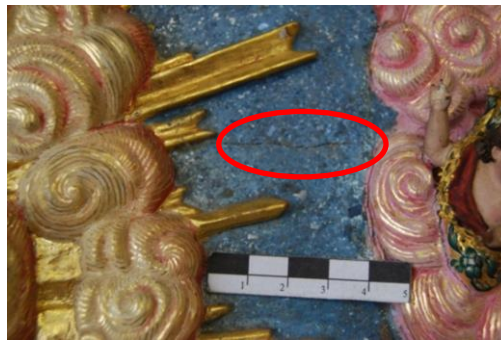
FIG. 162: Fissura existente nas camadas policromas do fundo da composição escultórica. (Autoria própria, 2012)
