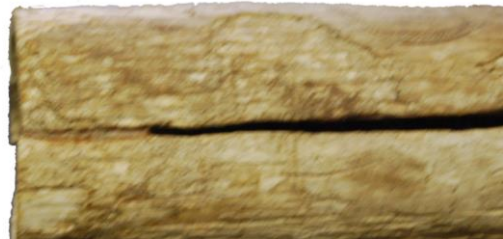
FIG. 110: Pormenor do resultado obtido na fenda côncava após a integração. (Autoria própria, 2013.)
