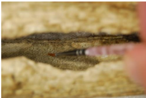
FIG. 105: Aplicação do reforço dos preenchimentos com a tela de nylon. (Autoria própria, 2013.)
