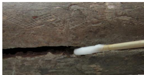
FIG. 73: Humedecimento do adesivo com um isopo embebido em água desionizada+etanol. (Autoria própria, 2013.)
