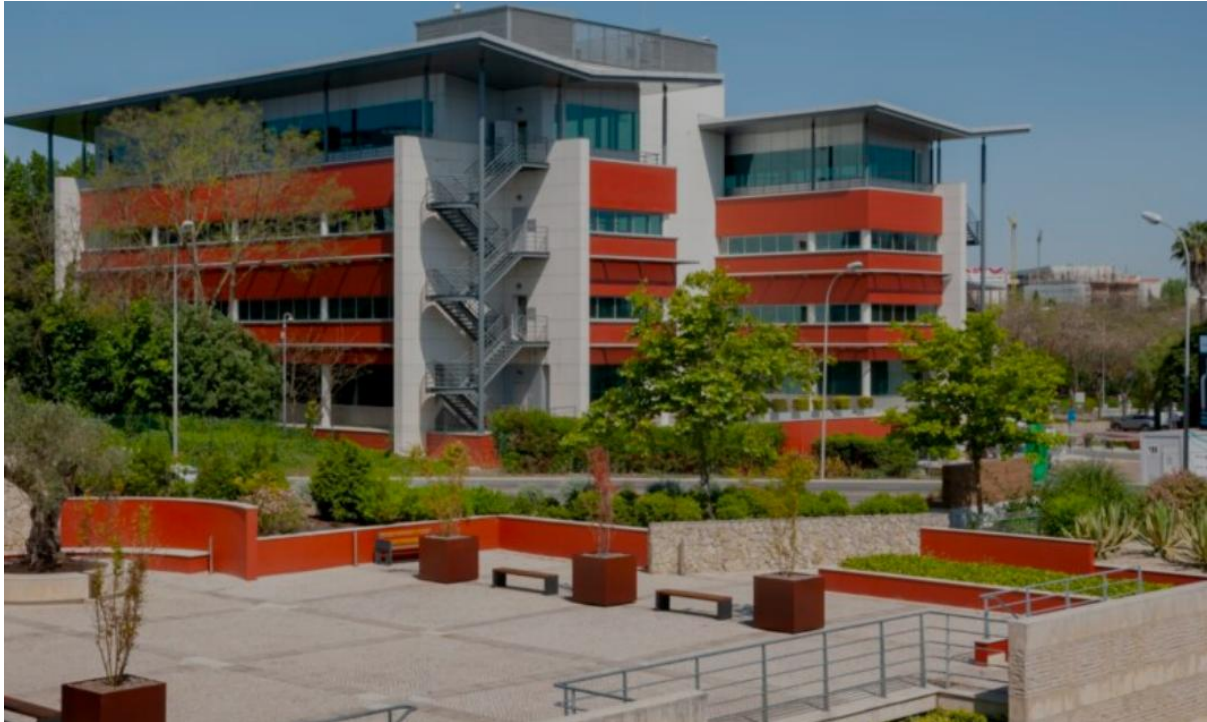
Figura 3.2 – Q51, o primeiro edifício de escritórios a receber a classificação Outstanding em Portugal, localizado na Grande Lisboa [27]
