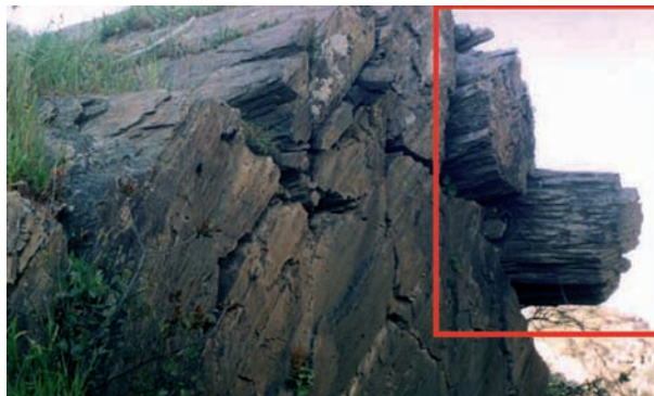
fig. 20 Aspecto geral da Rocha-Tipo antes da intervenção. O toppling que esta rocha apresenta é um dos maiores problemas da sua estabilidade. Assinala-se a zona onde foi decidido intervir. Foto: Compósito.
