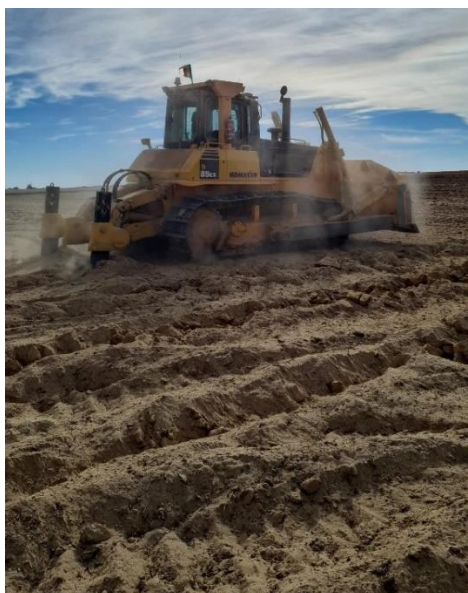
Figura 13 - Realização de ripagem a 70cm de profundidade
