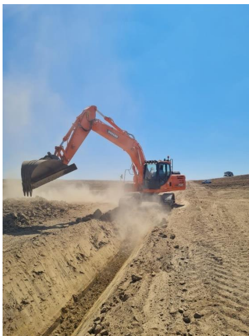
Figura 11 - Abertura de vala com máquina giratória
