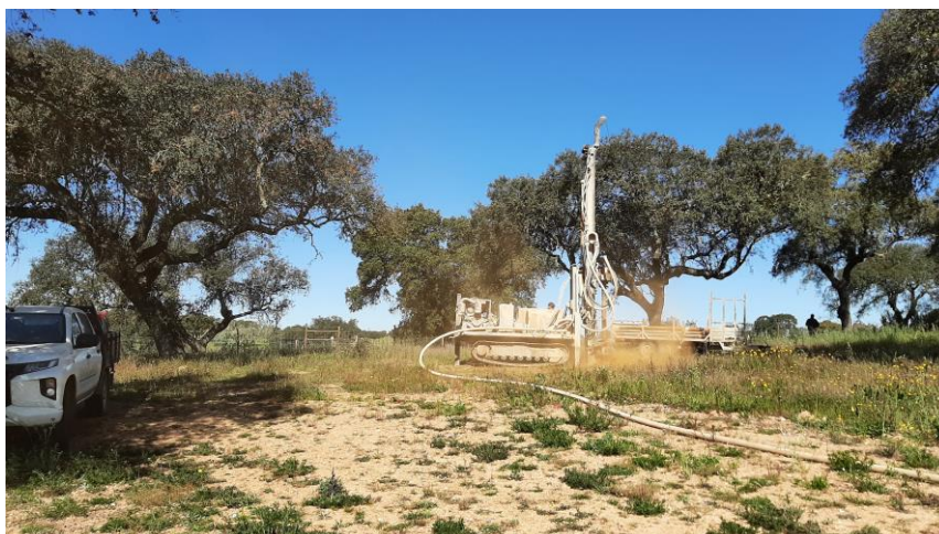
Figura 28 - Perfuração de sola para captação de água
