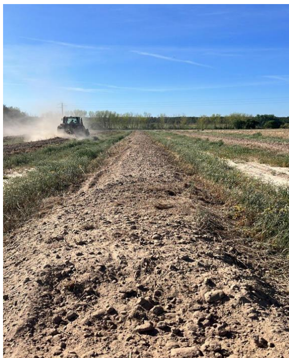
Figura 20 - Passagem com fresa armadora no topo dos camalhões
