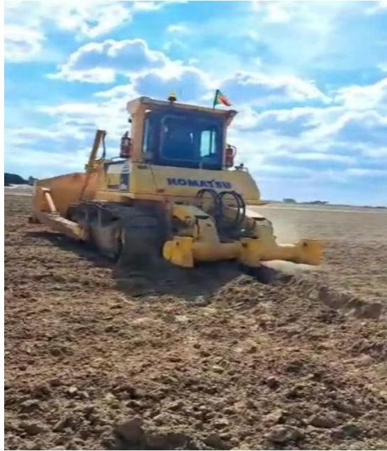
Figura 14 - Realização de ripagem a 1,2cm de profundidade
