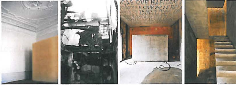
Figura 55. Restauro interior em estuque e com alto rodapé antes do incêndio
