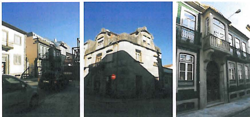
Figura 73. Coberturas Tradicionais na Rua de Gontim
