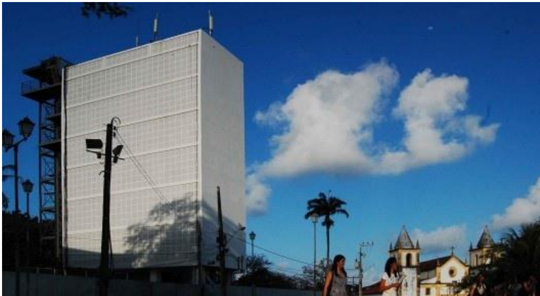
Figura 22- Caixa de água de Nunes Luís
