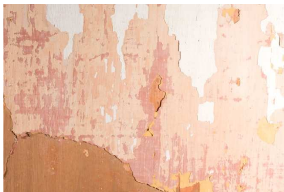
8-33: Levantamento fotográfico da cor – PDCDB 29
