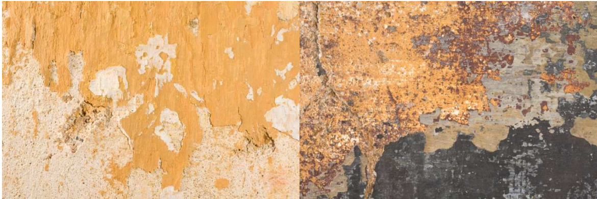
8-31: Levantamento fotográfico da cor – JJ 122 – Paramentos
