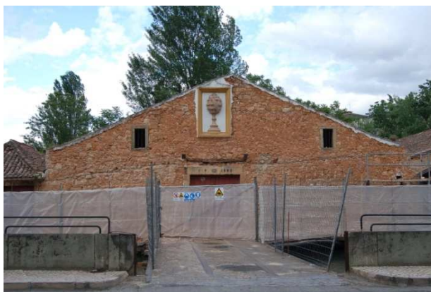
Fig. 6-1: Lagares d'el Rei, Tomar – Obra de Recuperação dos Edifícios – Remoção de todos os revestimentos. Fonte: Autora.
