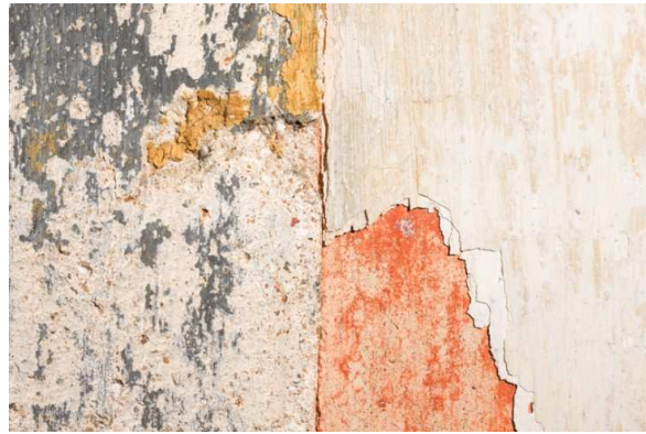
8-46: Levantamento fotográfico da cor – PD 67 (Soco e paramentos)
