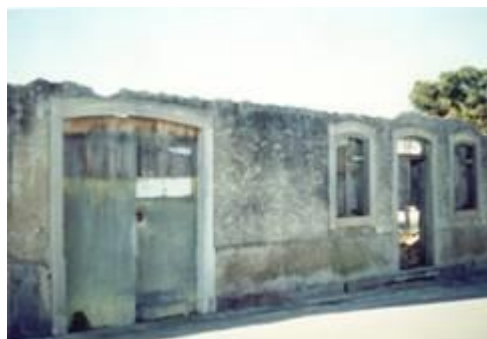
Figura 15 - Casa Gandraesa em ruínas ( www.seixo.net )
