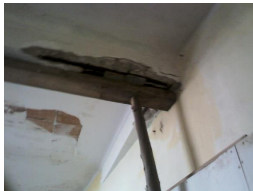
Figura 87 - Pormenor de viga no teto do r/ch Dto
