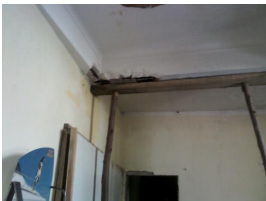
Figura 83 - Viga no teto do r/ch Dto
