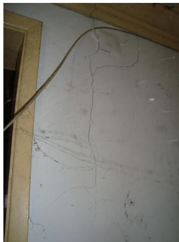
Figura 26 - Fissura vertical
