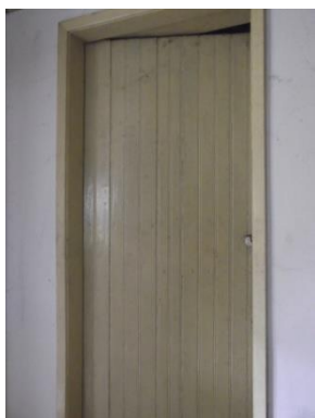
Figura 59 - Porta da cozinha para o corredor
