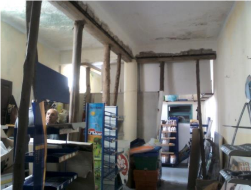
Figura 88 - Vista geral sobre sala do r/ch Dto
