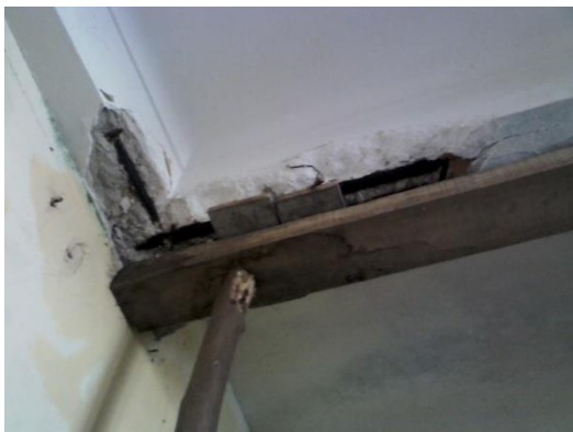
Figura 84 - Pormenor de viga no teto do r/ch Dto
