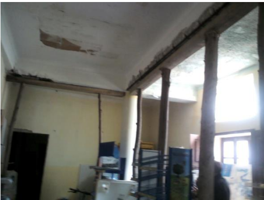
Figura 89 - Vista geral sobre sala do r/ch Dto
