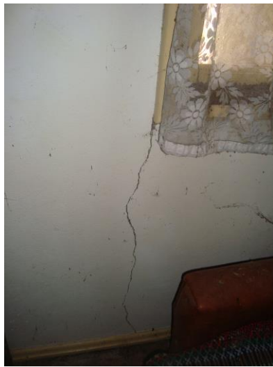
Figura 24 - Fissura vertical
