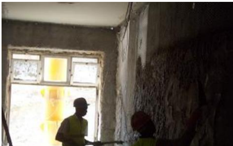
Figura 28 – Exemplo da aplicação de reboco projetado ( http://run.unl.pt/bitstream/10362/8550/1/Mauricio_2012.pdf )
