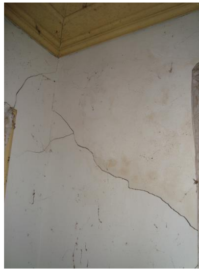
Figura 25 - Fissura diagonal
