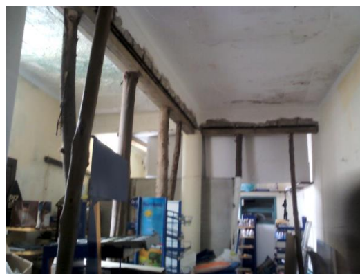
Figura 86 - Vista geral sobre sala do r/ch Dto
