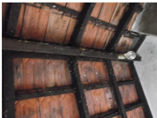
Figura 49 - Cobertura da cozinha (nova)
