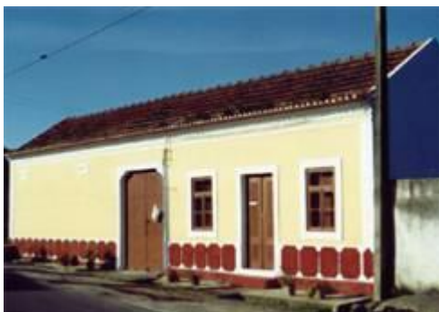
Figura 14- Casa gandraesa com fachada recuperada ( www.seixo.net )
