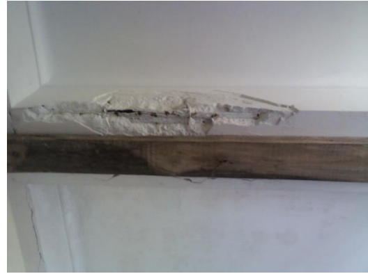
Figura 91 - Pormenor de viga no teto do r/ch Dto
