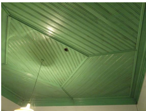
Figura 54 - Teto da sala
