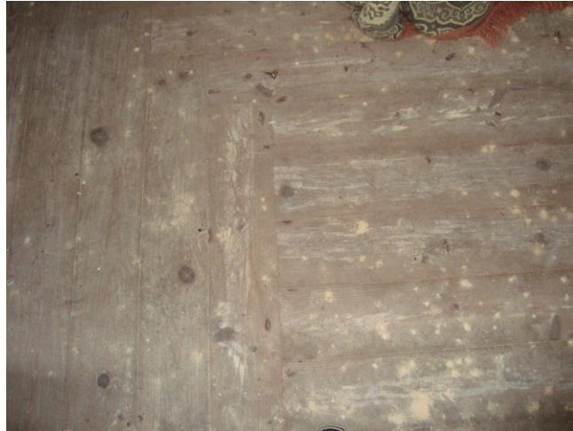
Figura 21 - Pavimento Desgastado
