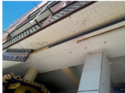
Figura 92 - Pala na parte frontal do teto do r/ch
