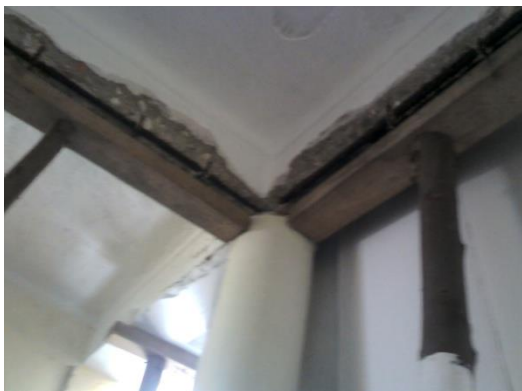
Figura 82 - Viga no teto do r/ch Dto
