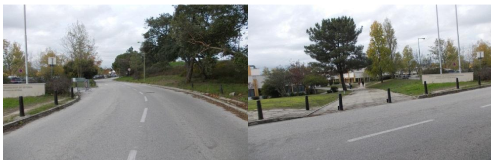
Figura 1. Vias de acesso no Campus IPS.
