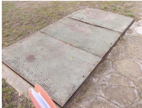
Figura 8. Conduta central de água da EST.
