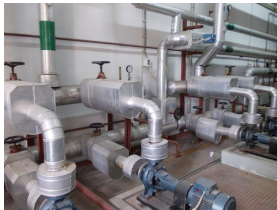
Figura 9. Casa das bombas da EST.
