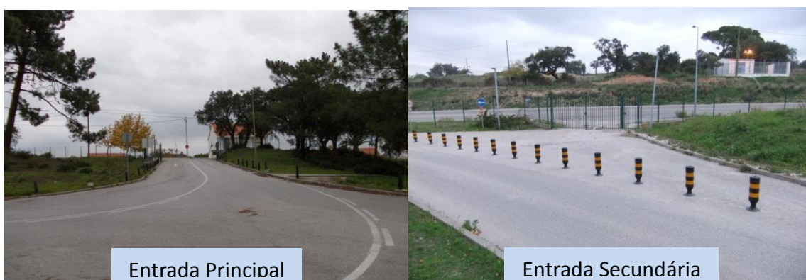
Figura 2. Entrada principal e secundária.
