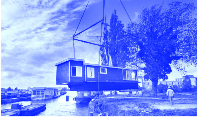
IMAGEM 24 - Instalação das casas flutuantes De Ceudel, autor desconhecido, Países Baixos.
