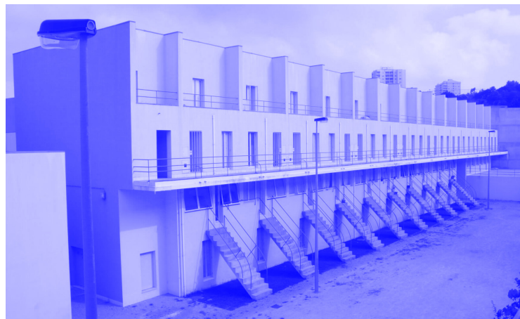
IMAGEM 18 - Vista de um dos pátios do Bairro da Bouça, Porto. Arquivo Álvaro Siza.
