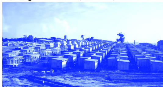
IMAGEM 10 - Bairro de Casas Desmontáveis da Quinta da Calçada, em construção, Lisboa, 1939.
