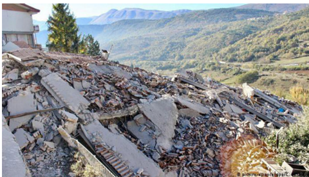
Figura 4 Destruição em L'Aquila, 30 de Outubro de 2016
