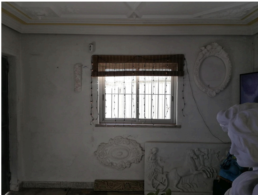
Figura nº24 / Parede da Esquerda (porta fechada)
