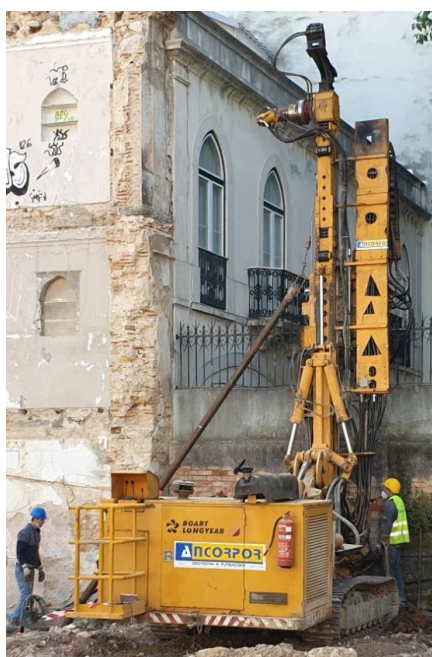
Figura 74: Construção de microestacas
