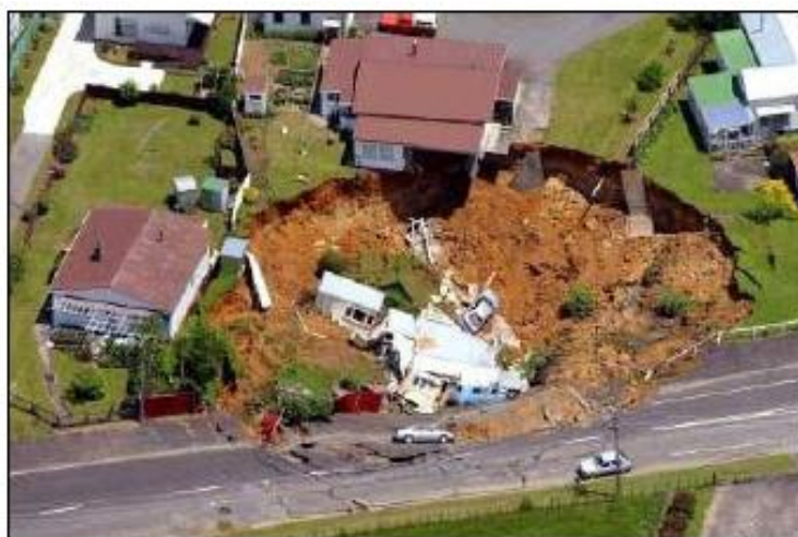
Figura 46: Quarteirão afetado pela subsidência devido ao rebaixamento do nível freático
