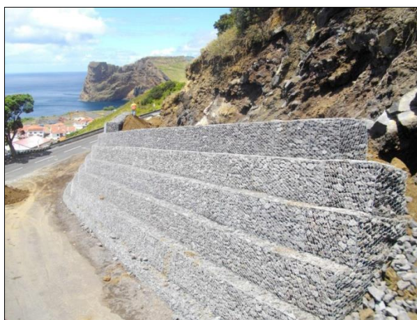
Figura 56: Muros de Gabiões
