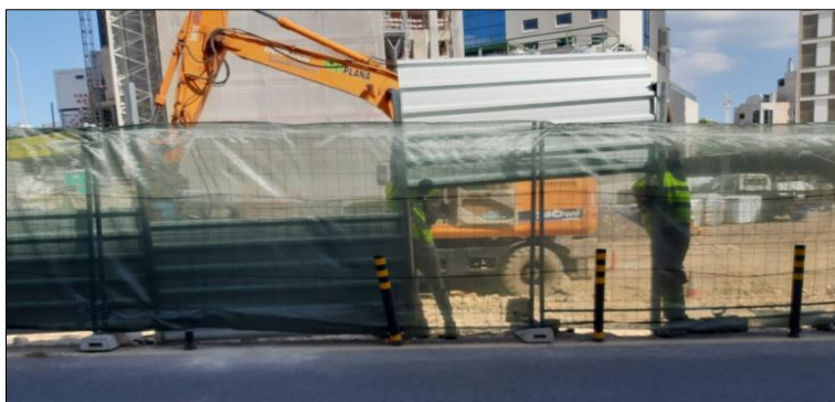
Figura 71: Vedação da obra
