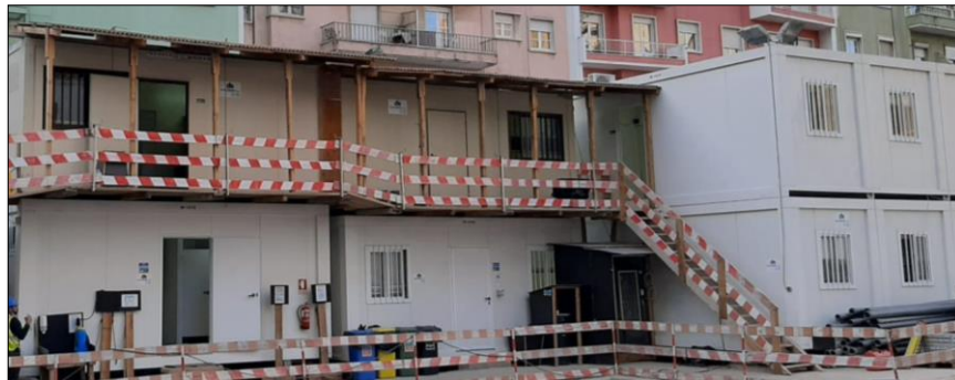
Figura 73: Preparação da plataforma de trabalho
