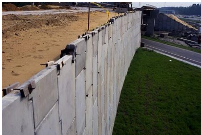
Figura 57: Muros de terra armada
