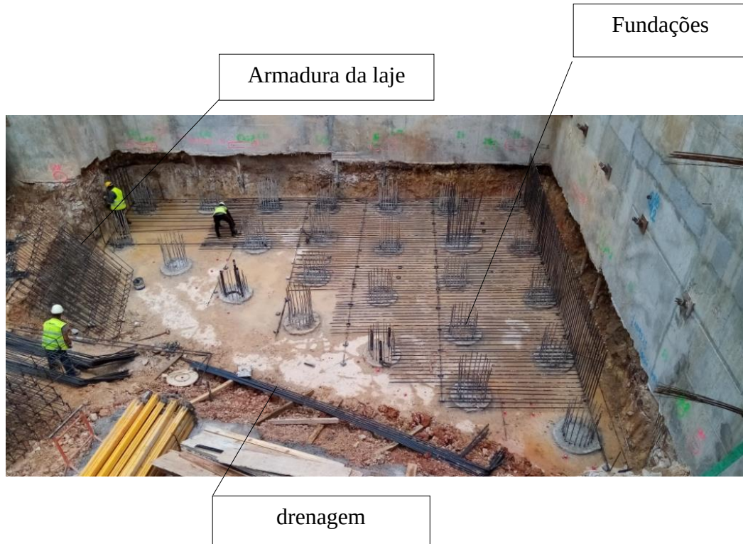
Figura 83: Execução das restantes fundações do edifício, do sistema de drenagem interior, superestrutura e lajes
