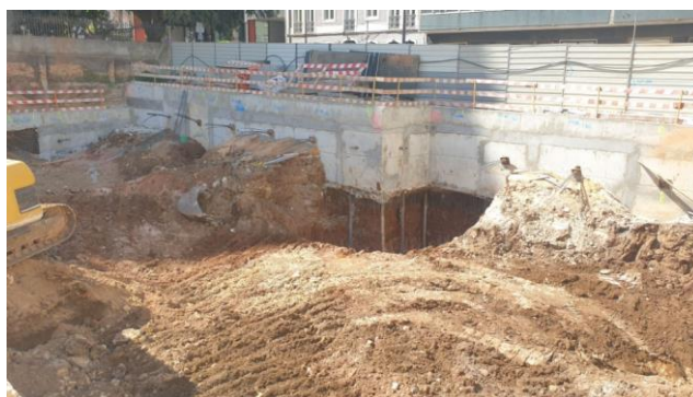
Figura 80: Muro com os painéis betonados e ancorados
