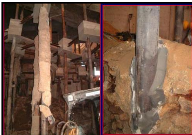
Figura 54: Blocos de sustentação da estrutura existente apoiados nas microestacas (esquerda) no Theatro Circo de Braga
