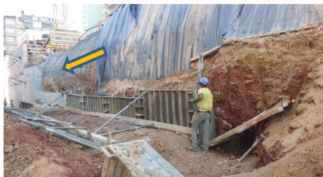
Figura 81: Troço do muro de contenção
