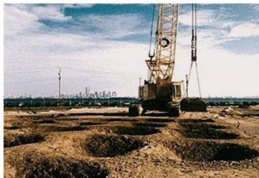
Figura 17: Compactação dinâmica
