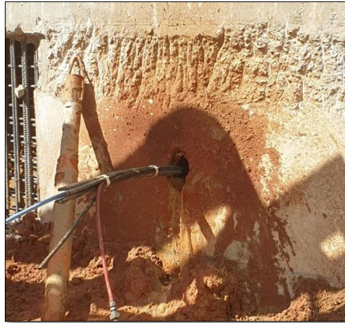
Figura 72: Vedação da obra
