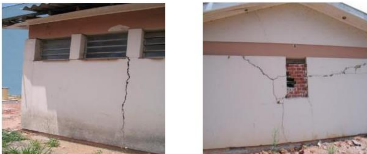
Figura 44: Exemplos de danos devido a variações volumétricas
