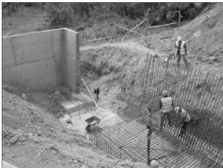
Figura 58: Muro de betão armado
