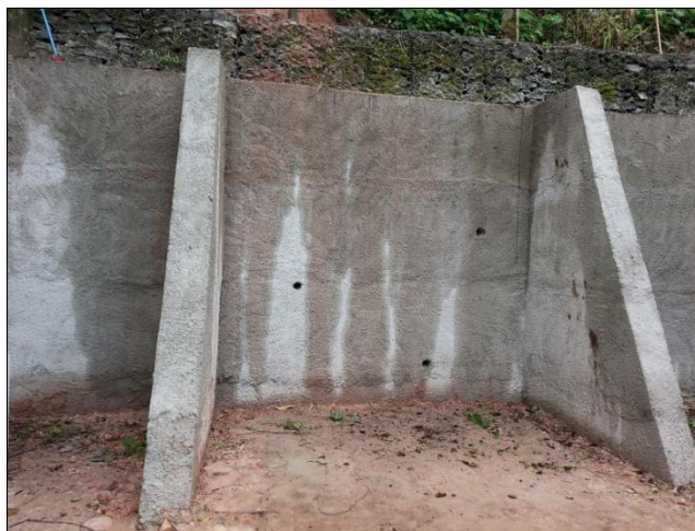
Figura 59: Muro de betão armado
