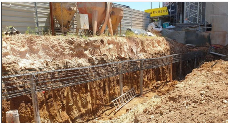
Figura 76: Cofragem na zona da face do intradorso
