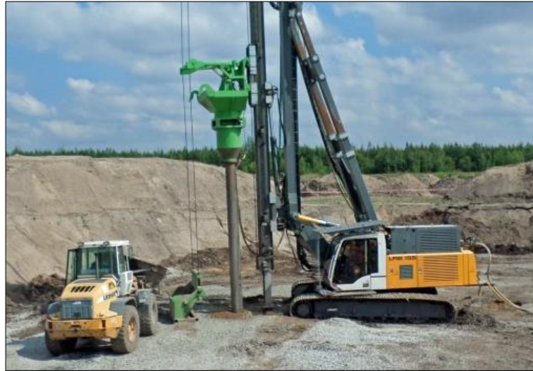
Figura 18: Vibro compactação
