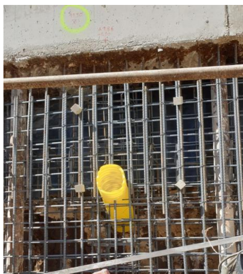
Figura 78: Negativos para a realização das ancoragens
