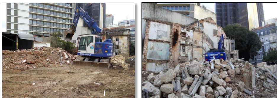
Figura 70: Fase de demolição
