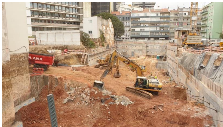
Figura 77: Escavação alternada dos painéis
