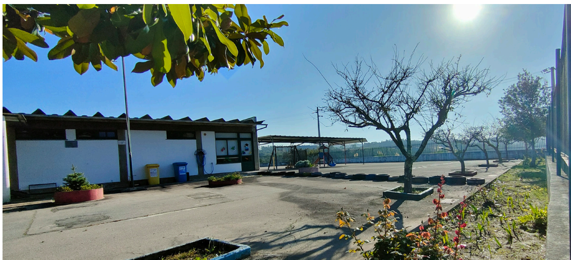
Fig.60- Fotografia da limitação do espaço recreio
