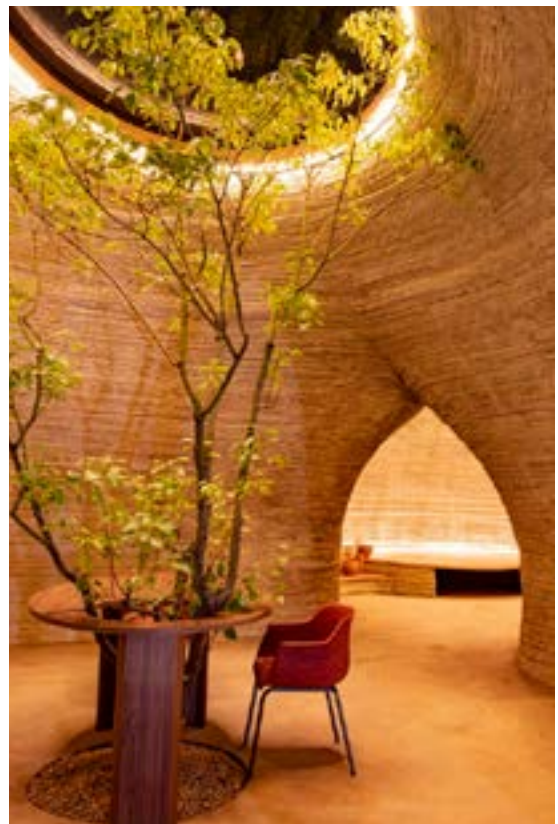
Casa Impressa em 3D com Tecnologia TECLA de Mario Cucinella Architects
