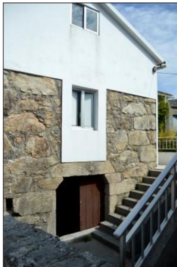
Fig. 139. Muro pincho da casa-vivenda Nº18 onde non se atopa a porta de acceso a vivenda.
