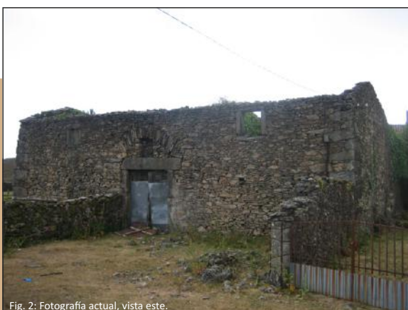
Fig. 2: Fotografía actual, vista este.
