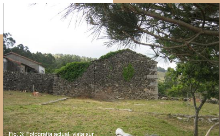
Fig. 3: Fotografía actual, vista sur
