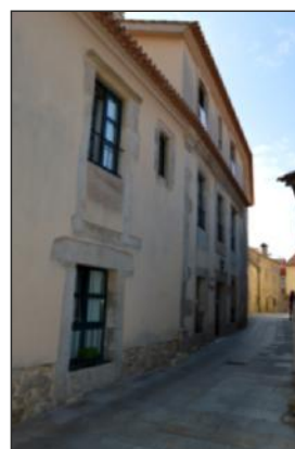
Fig. 110. Casa-vivenda Nº16, fachada este.
