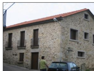
Fig. 36. Transformación profunda dunha casa-vivenda que data do ano 1882, no barrio do Eido de Abaixo. Oia.
