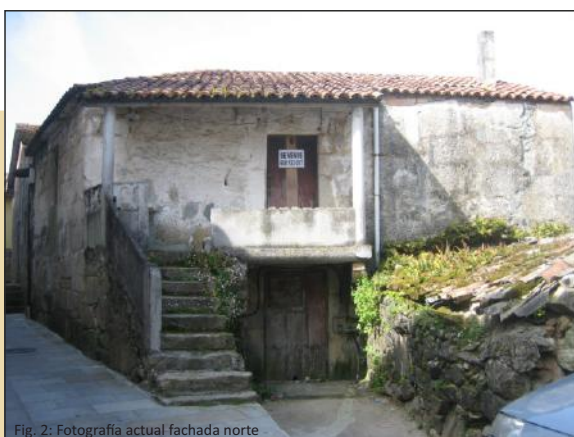
Fig. 2: Fotografía actual fachada norte
