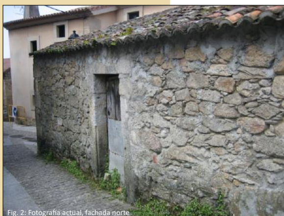
Fig. 2: Fotografía actual, fachada norte
