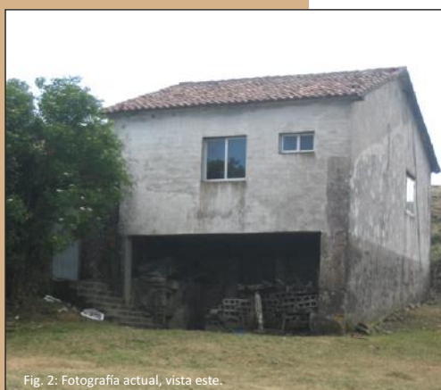
Fig. 2: Fotografía actual, vista este.
