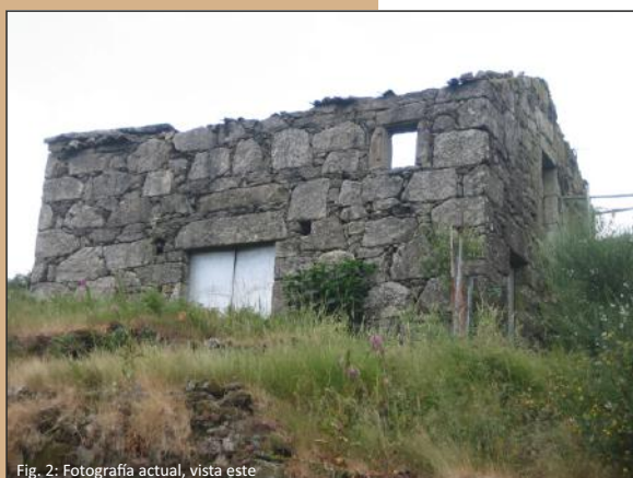
Fig. 2: Fotografía actual, vista este
