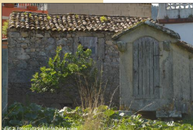
Fig. 2: Fotografía actual fachada norte
