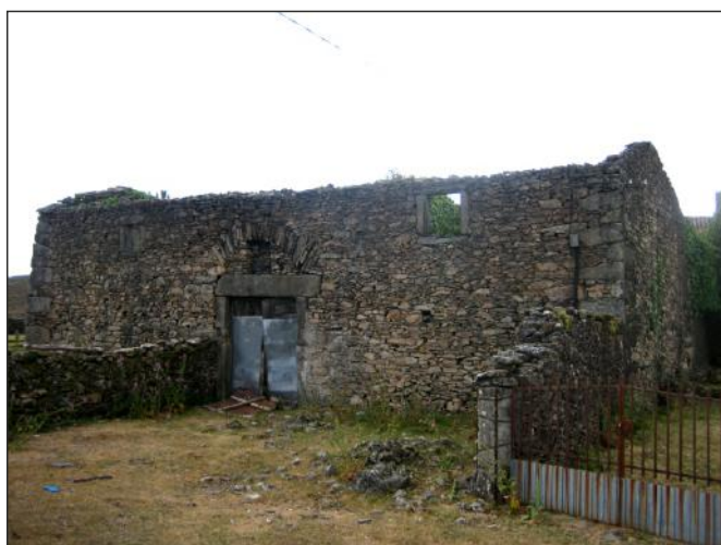
Fig. 193. Casa-vivenda Nº11, fachada este.
