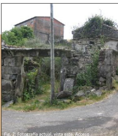
Fig. 2: Fotografía actual, vista este. Acceso
