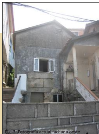
Fig. 3: Fotografía actual fachada oeste
