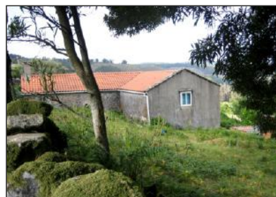
Fig. 190. Casa-vivenda Nº01, fachada oeste e sur.
