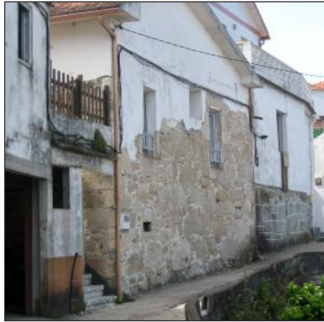
Fig. 126. Fachada principal da casa-vivenda Nº19.
