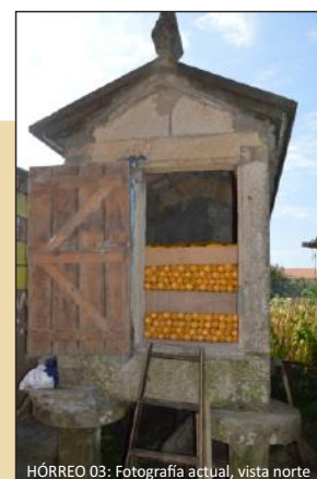
HÓRREO 03: Fotografía actual, vista norte
