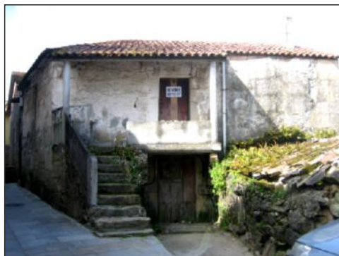
Fig. 113. Fachada principal casa-vivenda Nº07.
