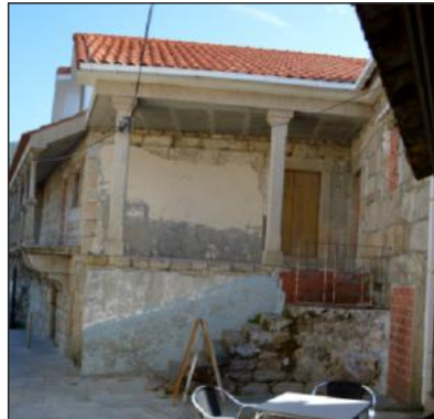
Fig. 97. Escada lateral, acesso a casa-vivenda Nº04.
