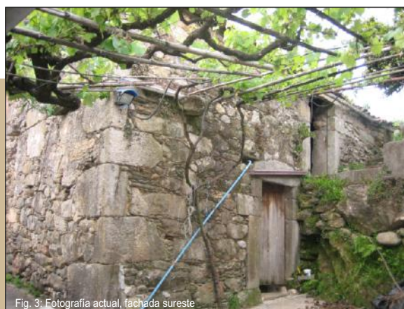
Fig. 3: Fotografía actual, fachada sureste
