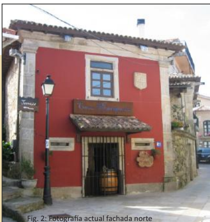
Fig. 2: Fotografía actual fachada norte
