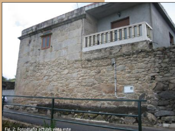
Fig. 2: Fotografía actual, vista este
