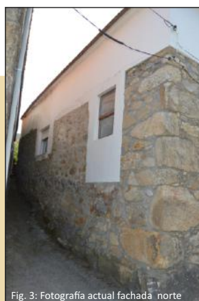
Fig. 3: Fotografía actual fachada norte
