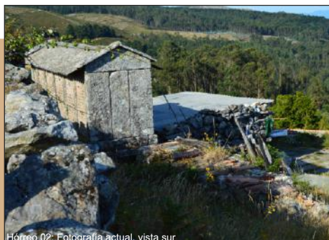
Hórreo 02: Fotografía actual, vista sur
