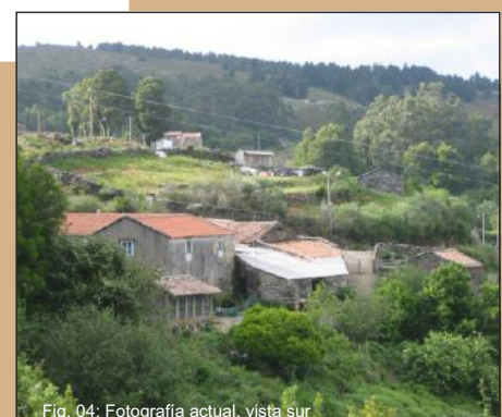
Fig. 04: Fotografía actual, vista sur
