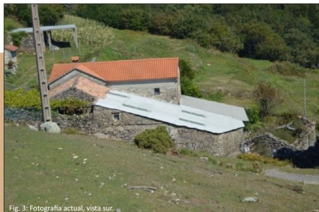
Fig. 3: Fotografía actual, vista sur.
