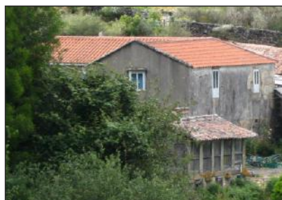
Fig. 189. Casa-vivenda Nº01, fachada este.
