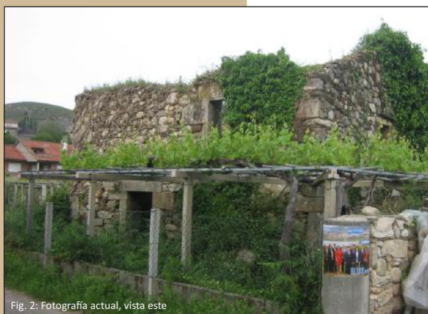
Fig. 2: Fotografía actual, vista este
