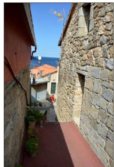
Fig. 104. Vista da rúa dende a casa-vivenda Nº14.
