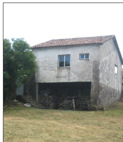
Fig. 192. Casa-vivenda Nº12, fachada este.
