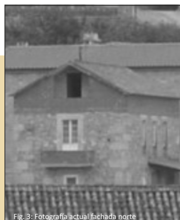
Fig. 3: Fotografía actual fachada norte
