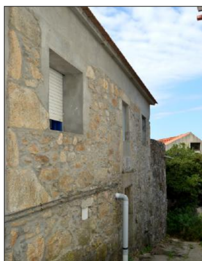
Fig. 146. Fachada traseira da casa-vivenda Nº27.
