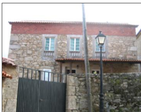
Fig. 111. Fachada principal da casa-vivenda Nº33.
