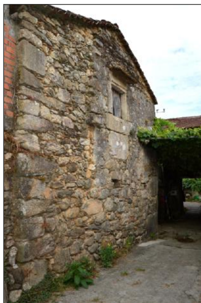
Fig. 219. Casa-vivenda Nº05, muro de lousa e granito.
