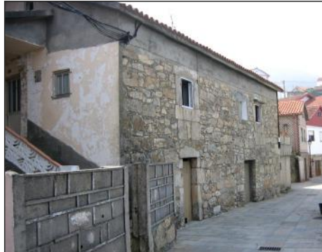
Fig. 125. Fachada principal da casa-vivenda Nº11.
