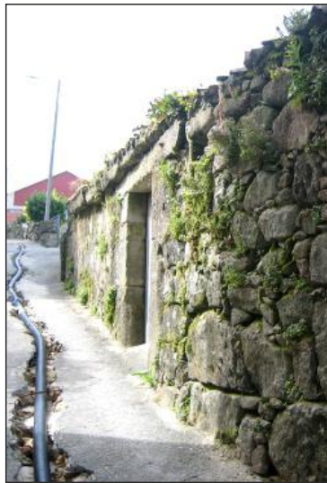
Fig. 137. Casa-vivenda Nº17, acceso por muro lonxitudinal.
