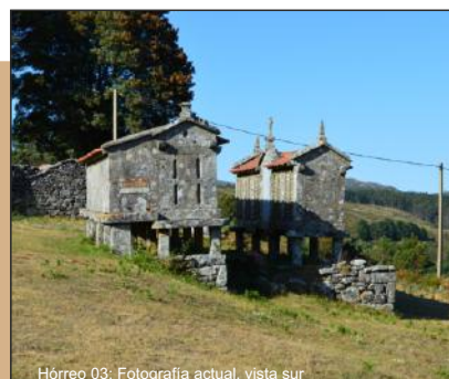
Hórreo 03: Fotografía actual, vista sur
