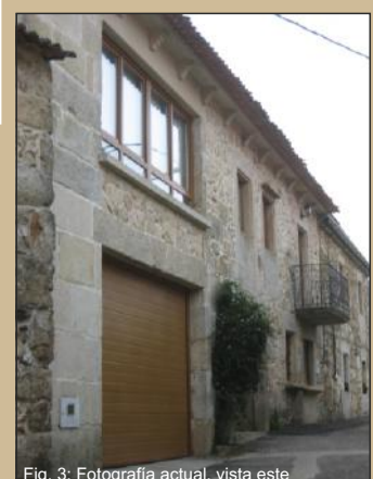
Fig. 3: Fotografía actual, vista este
