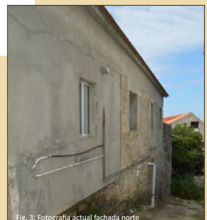
Fig. 3: Fotografía actual fachada norte
