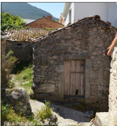
Fig. 2: Fotografía actual, fachada norte
