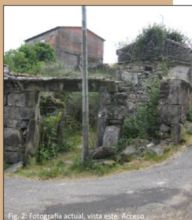
Fig. 2: Fotografía actual, vista este. Acceso
