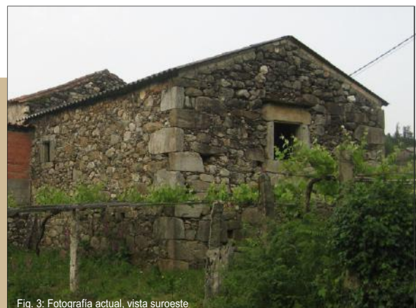
Fig. 3: Fotografía actual, vista suroeste
