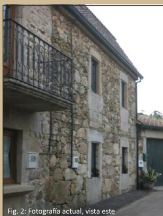
Fig. 2: Fotografía actual, vista este
