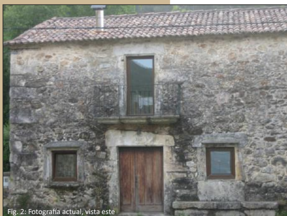
Fig. 2: Fotografía actual, vista este
