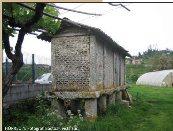
HÓRREO 4: Fotografía actual, vista sur.
