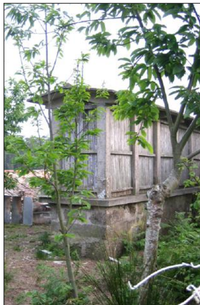
Fig. 231. Hórreo 03, de albanalería, granito e tixolo.
