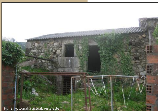
Fig. 2: Fotografía actual, vista este
