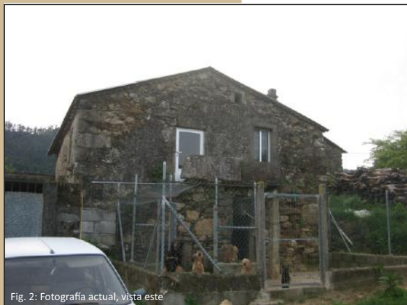
Fig. 2: Fotografía actual, vista este
