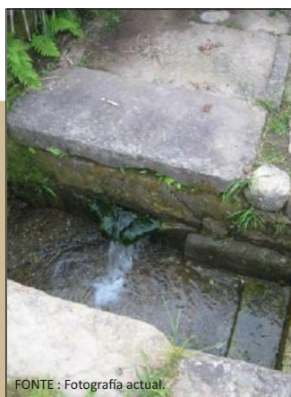
FONTE : Fotografía actual.
