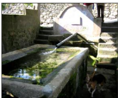
Fig. 243 . Intervención en patrimonio etnográfico inadecuada.
