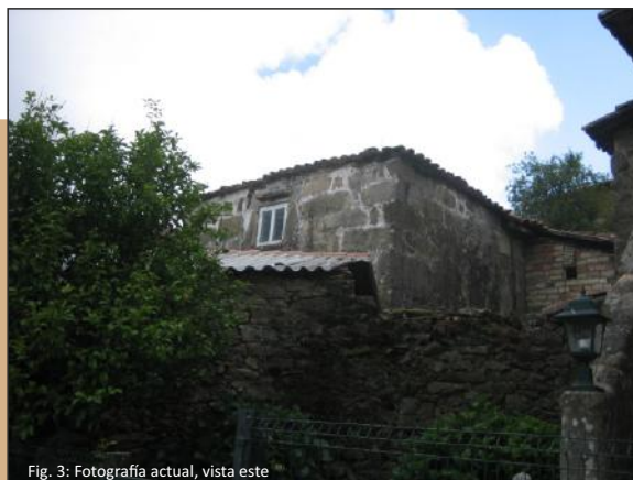
Fig. 3: Fotografía actual, vista este
