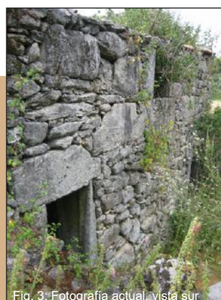
Fig. 3: Fotografía actual, vista sur
