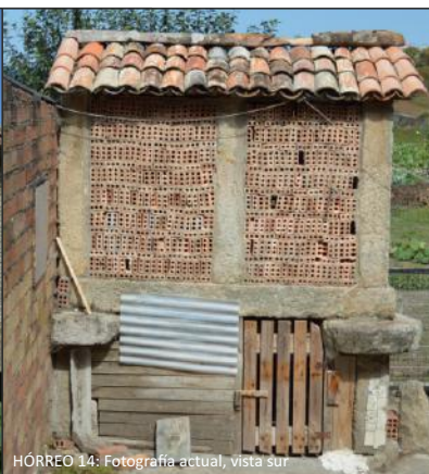
HÓRREO 14: Fotografía actual, vista sur
