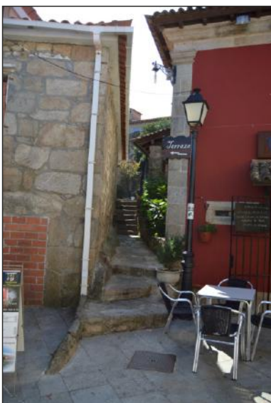
Fig. 102. Escada entremedianeras, acceso a casa-vivenda Nº05.
