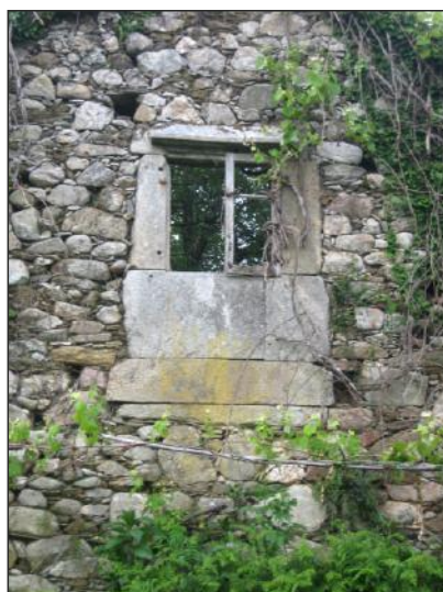
Fig. 222. Fachada da casa-vivenda Nº07, composta por granito e lousa.
