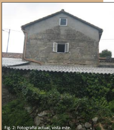
Fig. 2: Fotografía actual, vista este.
