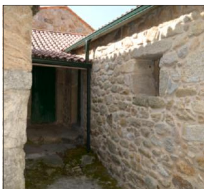
Fig. 95. Casa-vivenda N°15, fachada traseira (oeste).
