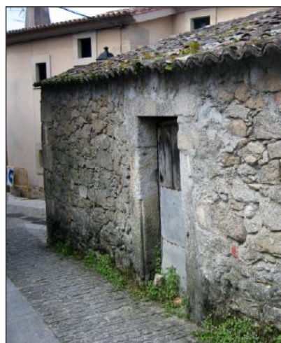
Fig. 144. Acceso a casa-vivenda Nº24, altura de 2m.
