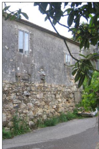
Fig. 220. Casa-vivenda Nº06, muro de granito e lousa.
