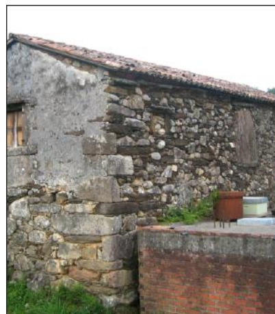
Fig. 225. Casa-vivenda Nº11, muro de granito e lousa.
