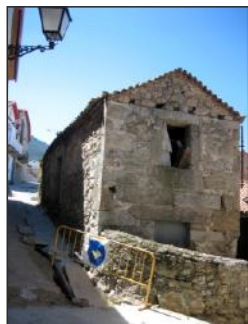
Fig. 129. Casa-vivenda Nº17, fachada hacia a rúa.
