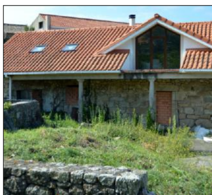
Fig. 90. Casa-vivenda N°04, aberturas na fachada lateral (norte).
