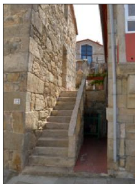
Fig. 107. Fachada norte da casa-vivenda Nº13.
