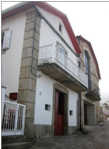
Fig. 127. Fachada principal da casa-vivenda Nº22.
