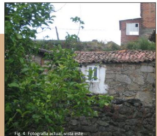
Fig. 4: Fotografía actual, vista este
