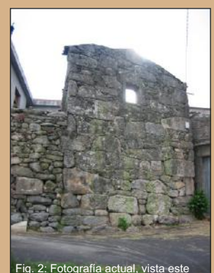
Fig. 2: Fotografía actual, vista este
