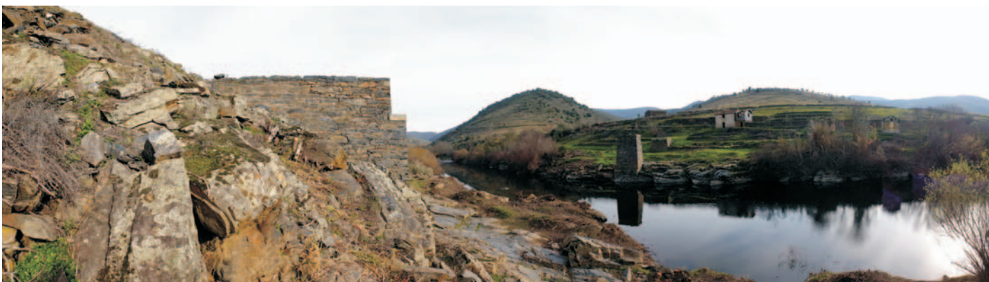
Figura 2 – Pegões da Ponte de Cilhades, Felgar, Torre de Moncorvo (EP 155, Foto 0155-0002)
