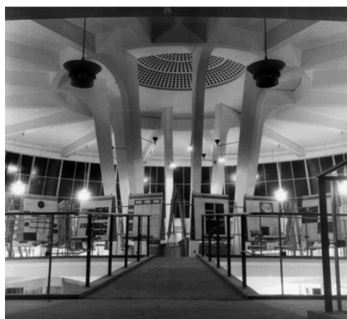
Figura 12. Interior/ exterior do edifício Bouwcentrum, em Roterdão
