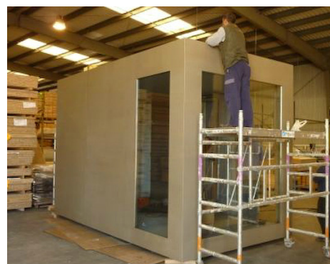
Fig. 70 – Aspectos exterior da Casa pré-fabricada, em estaleiro, do módulo técnico
