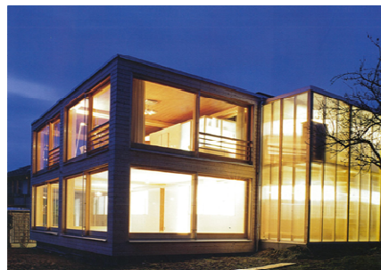
Fig. 46 – Aspecto final da habitação.
