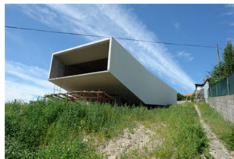
Figura 6. Pormenor de execução de uma habitação do Arq. Paulo Vilarinho
