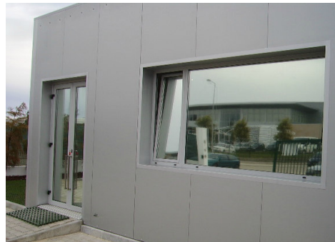
Fig. 71 – Aspectos exterior da Casa pré-fabricada, do módulo técnico
