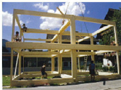
Fig. 45 – Aspectos da construção da Casa para duas famílias, utilizando materiais pré-fabricados.
