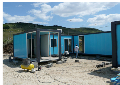
Fig. 69 – Aspectos exterior da Casa pré-fabricada, do módulo técnico
