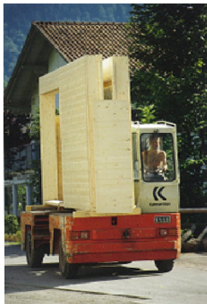
Fig. 44 – Transporte dos módulos pré-fabricados.
