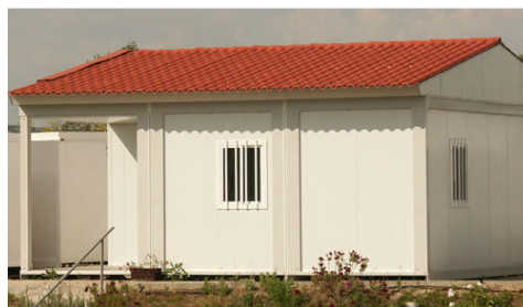
Fig. 66 – Aspectos da construção da Casa pré-fabricada, da movex.
