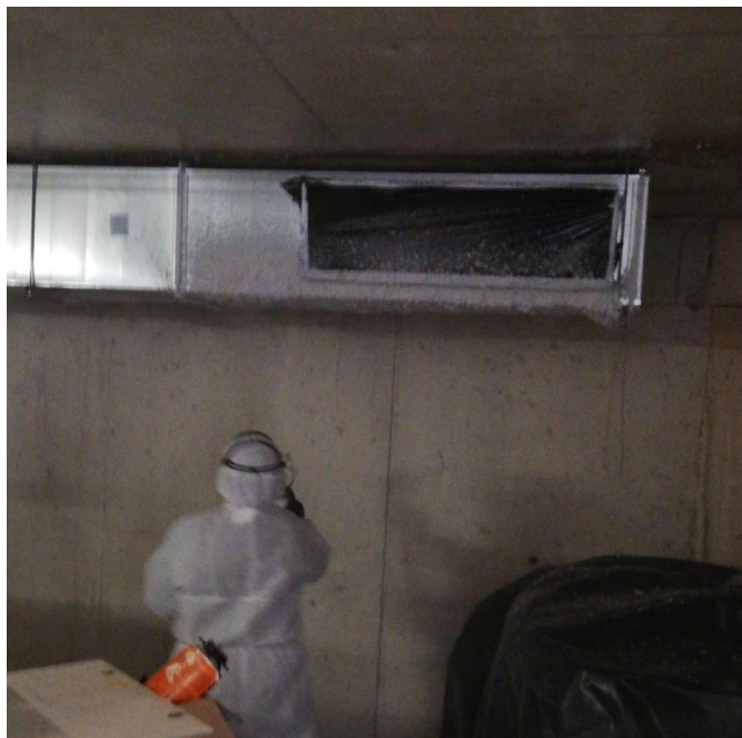
Figura 14 - Trabalho de Projeção – Obra Palmares
