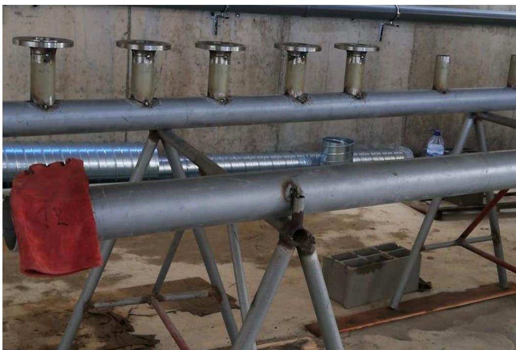
Figura 60 - Produção dos coletores na central técnica
