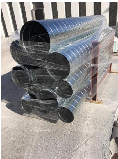
Figura 7 - Spiro utilizado em obra
