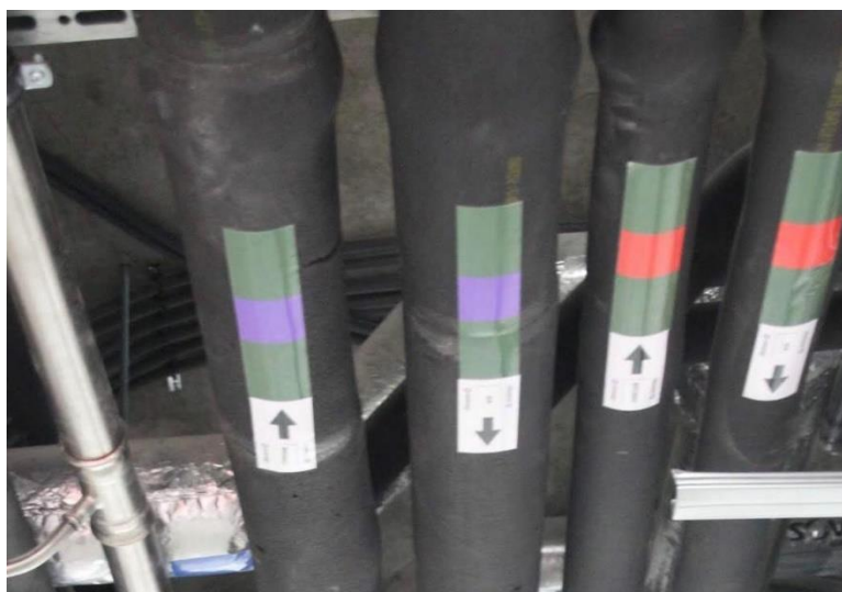
Figura 62 - Identificação das linhas hidráulicas
