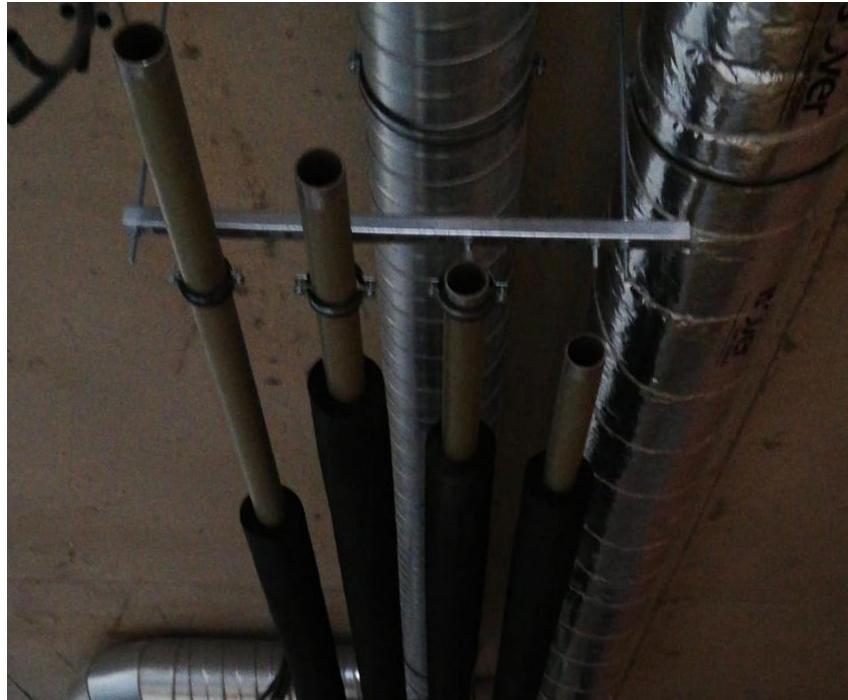
Figura 46 – Tubagens de ferro preto instaladas em obra
