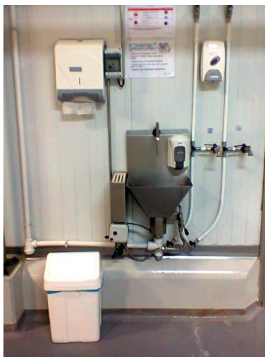
Figura 16 - Lava mãos equipado com dispensador de detergente, desinfetante, papel para secagem higiénica e contentor de recolha de inutilizados.
