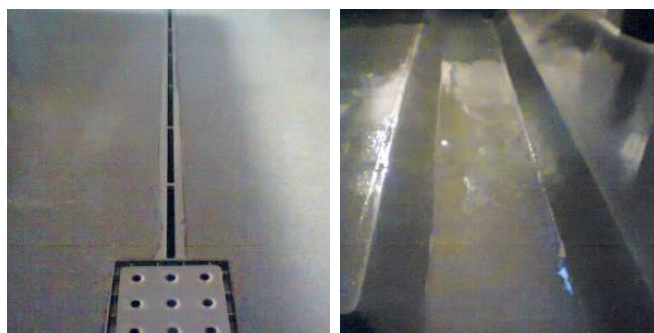
Figura 13 - Caleiras de águas residuais.
