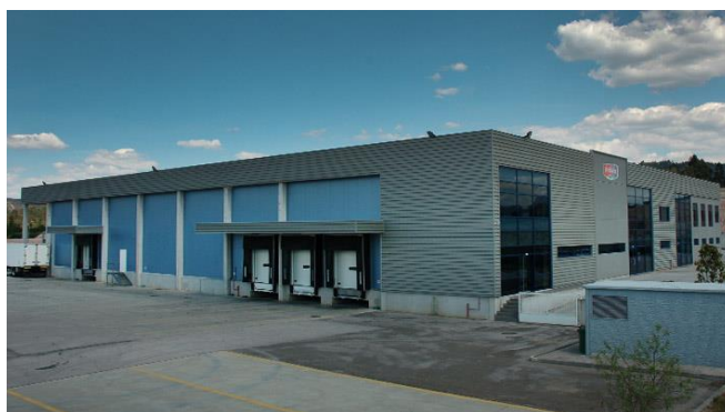
Figura 1 - Instalações exteriores da empresa.
