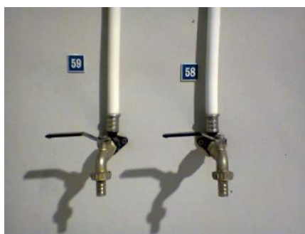
Figura 12 - Torneira numerada para identificação no Plano de controlo de cloro.
