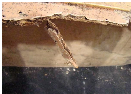
Fig. 62 .Pormenor de lacuna volumétrica com elemento do retábulo em desagregação devido à ação dos insetos xilófagos
