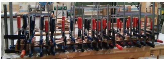
Fig. 213 Apertos das colagens das peças de reconstituição das áreas deterioradas de uma das pilastras (perspetiva lateral)
