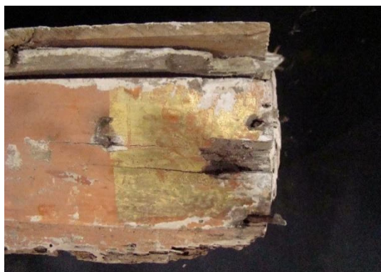
Fig. 61 Pormenor elemento do entablamento com desgaste da folha metálica; elementos metálicos corroídos
