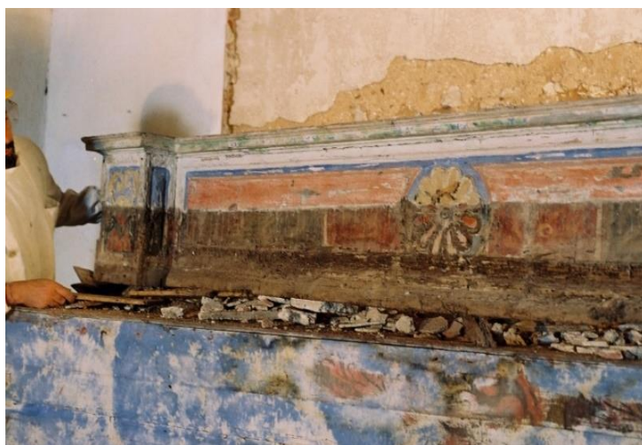
Fig. 43 Desmontagem do painel central
