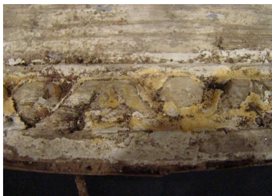
Fig. 70 Pormenor cornija com repintes pulverulentos, poeiras superficiais e lacunas dos estratos policromos
