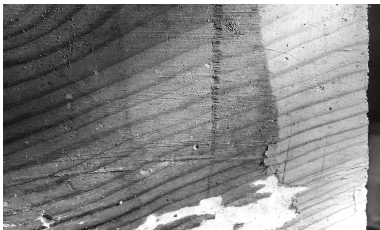
Fig.145 Marcas de plaina no topo biselado de uma das tábuas do painel de fixação da tela
