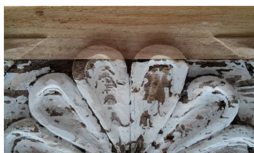
Fig.235 Pormenor da reconstituição formal e compositiva do ornato do painel central do embasamento, seguindo a continuidade de formas, alinhamentos e volumes através da técnica de entalhe com formões e goiva
