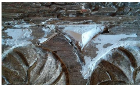
Fig.260 Preenchimento com pasta celulósica Rayon – Lovadi-301-Fibroxil®
