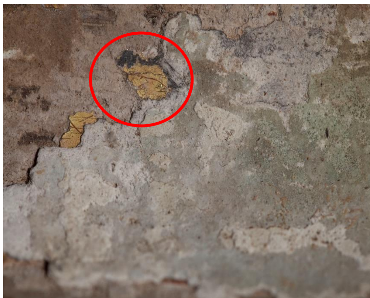
Fig.134 Macrofotografia de uma área de um friso da base da pilastra esquerda, onde são visíveis os vários estratos preparatórios e pictóricos das intervenções realizadas sobre o douramento, tido como original
