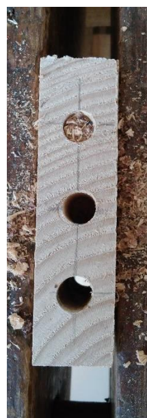
Fig.228 Pormenor da abertura de furos para colocação de cavilhas para uma união de topo de peça de preenchimento
