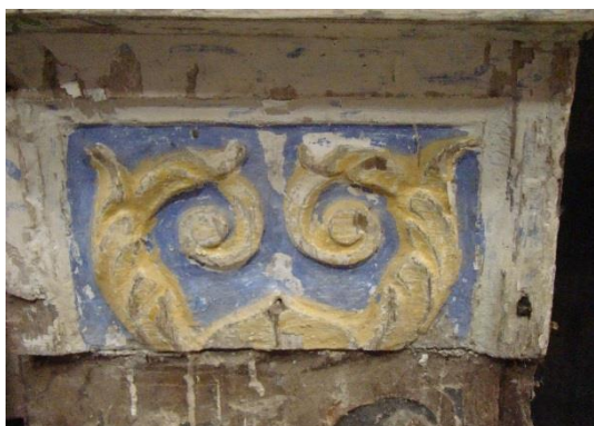
Fig. 44 Pormenor da mísula com repintes e corte efetuado para acoplamento de uma banqueta
