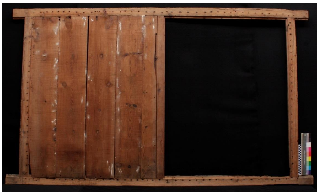
Fig. 103 Vista geral da estrutura de fixação da tela com o conjunto de tábuas do lado direito
