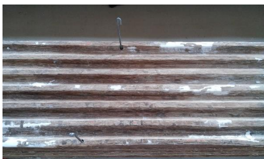
Fig. 206 Recurso a elementos metálicos para verificação e ensaio dos encaixes e ligações das peças originais
