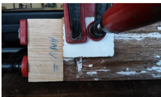
Fig.232 Aperto após a colagem da peça de preenchiment
