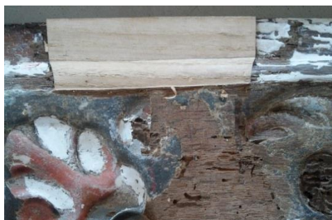
Fig.238 Pormenor da modelação de uma peça de preenchimento da mísula através da técnica de entalhe com formões e goivas
