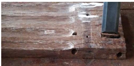
Fig.210 Ablação localizada, por acertos, rebaixo e nivelamento a formão, de áreas de madeira deteriorada pela corrosão dos elementos metálicos – pregos em aço macio
