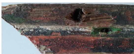
Fig. 26 . Exemplo de um elemento com imitação de materiais pétreos
