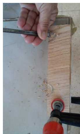
Fig.241 Preparação da peça de madeira nova para preenchimento da lacuna
