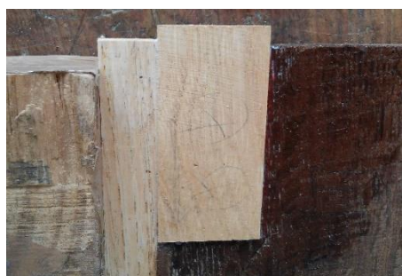
Fig. 222 Pormenor do preenchimento de lacuna no anverso de uma mísula com madeira nova
