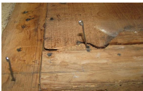
Fig.205 Recurso a elementos metálicos para verificação e ensaio dos encaixes e ligações das peças originais
