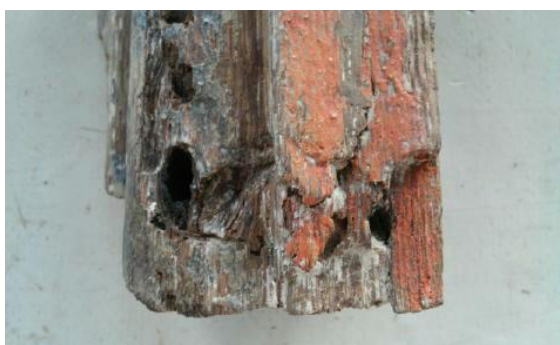
Fig.175 Friso com repintes; orifícios de elementos metálicos; lacunas da madeira; vestígios de corrosão
