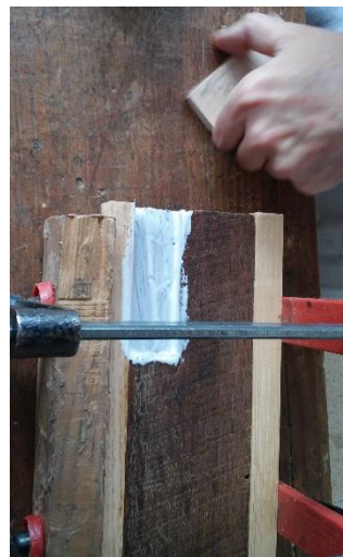
Fig. 220 Colagem e apertos das colagens da peça de preenchimento de lacuna no anverso de uma mísula
