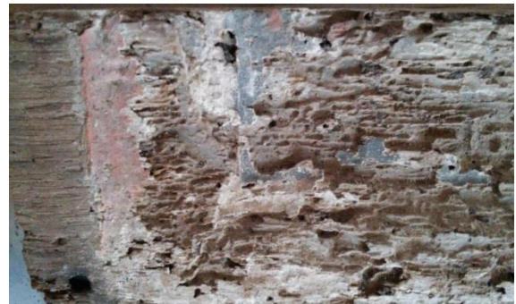
Fig.171 Elemento sem vestígios de forma (entalhe) pela ação de insetos xilófagos
