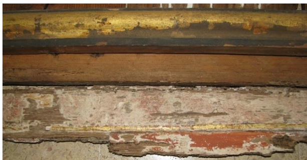
Fig.161 Sujidade e pulverulência nos estratos de superfície
