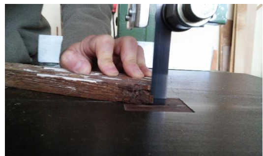
Fig.203 Ablação, por corte, da madeira deteriorada do friso – com lacunas e sem resistência mecânica – pela ação de fungos lenhívoros e insectos xilófagos, para preenchimento com madeira
