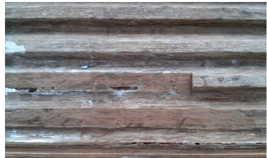
Fig. 199 Desbaste das caneluras da pilastra deterioradas pela ação dos insetos xilófagos, para permitir o preenchimento com madeira
