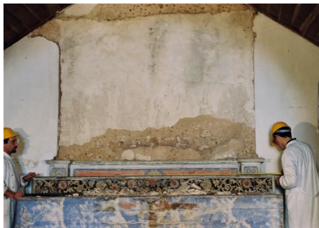
Fig. 41 Desmontagem de elementos do retábulo
