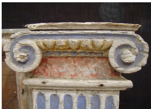
Fig. 54 Pormenor do capitel com repintes e lacunas ao nível da estrutura
