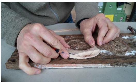
Fig. 190 Utilização do perfilómetro para posterior execução do desenho do friso
