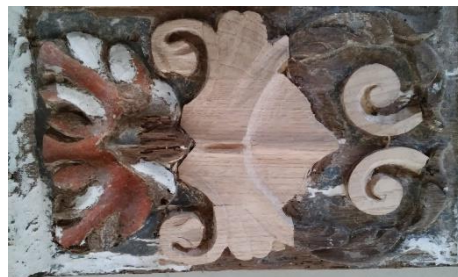
Fig.249 Pormenor da modelação volumétrica das madeiras de preenchimento, através da técnica de entalhe – após a fase de desbaste grosso
