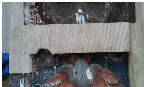
Fig.242 Preenchimento da lacuna
