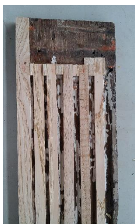
Fig.250 Pormenor da preparação de um conjunto de bites e peças em madeira para o preenchimento de lacunas
