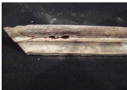
Fig. 67 Friso do embasamento aplicado em intervenção anterior
