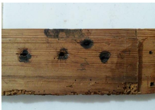
Fig. 79 Elemento do suporte do painel de fixação da tela, com manchas de corrosão nas áreas envolventes à utilização de elementos metálicos e vestígios da ação dos insetos xilófagos
