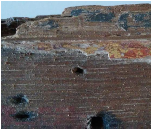
Fig.166 Orifícios de elementos metálicos, repinte; lacunas da madeira
