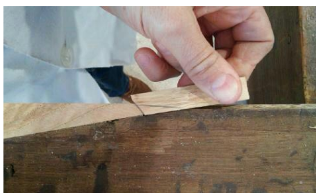
Fig.258 Pormenor de preenchimento de lacuna. Ensaio antes do corte
