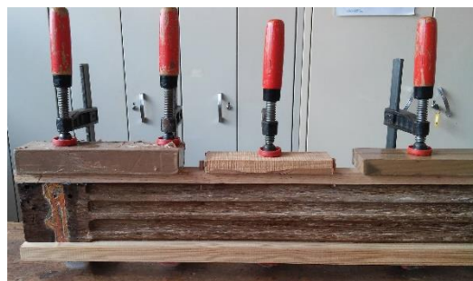
Fig.218 Aperto da colagem de duas peças em madeira nova numa peça lateral da pilastra
