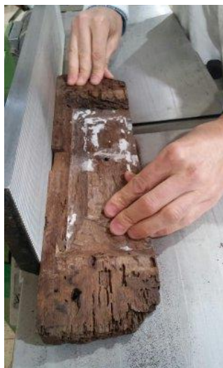
Fig.204 Ablação, por desbaste, da madeira deteriorada do friso – com lacunas e sem resistência mecânica – pela ação de fungos lenhívoros e insectos xilófagos, para preenchimento com madeira
