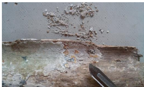
Fig. 265 Pormenor da remoção mecânica do primeiro repinte
