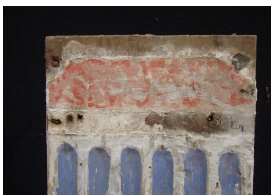
Fig. 72 Pormenor da pilastra com repintes e orifícios de elementos metálicos corroídos
