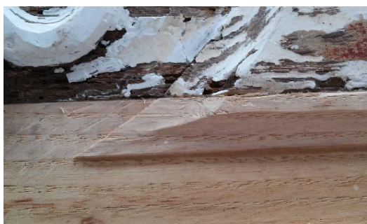
Fig. 236 Pormenor da reconstituição formal e compositiva do painel central do embasamento, seguindo a continuidade de formas, alinhamentos e volumes através da técnica de entalhe com formões e goivas
