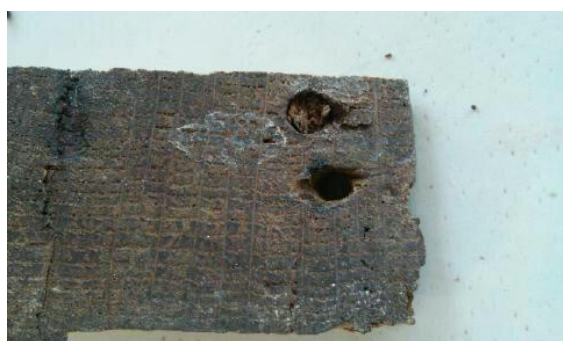
Fig.174 Anverso de um elemento estrutural com cavilha original; orifício de elemento metálico; vestígios de grude
