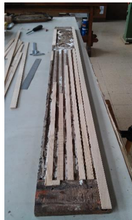
Fig.255 Pormenor da preparação da colagem dos bites em madeira para preenchimento de lacunas
