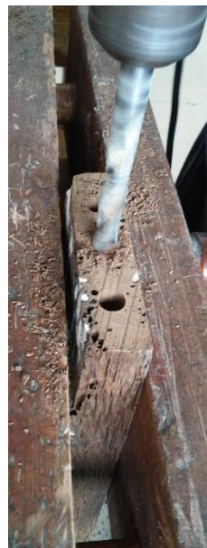
Fig.231 Pormenor da perfuração dos orifícios para as cavilhas que irão assegurar o reforço da união colada no topo da peça original a preencher com madeira nova
