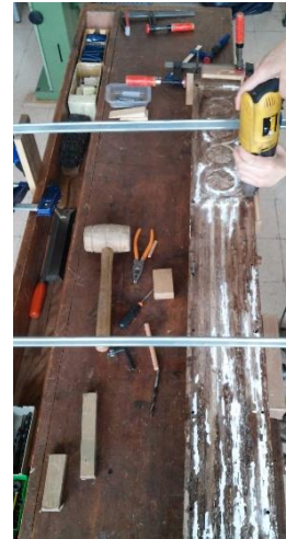
Fig. 209 Execução de furos com berbequim e brocas de 6, 8 e 10 Ø mm, colocação de cavilhas de madeira para reforço das colagens (em substituição dos pregos em aço macio)
