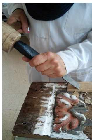
Fig.237 Pormenor da modelação de uma peça de preenchimento da mísula através da técnica de entalhe com formões e goivas
