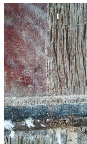
Fig. 264 Pormenor da remoção mecânica dos repintes
