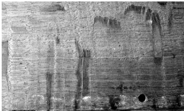
Fig.137 Marcas de enxó no verso do painel central do embasamento
