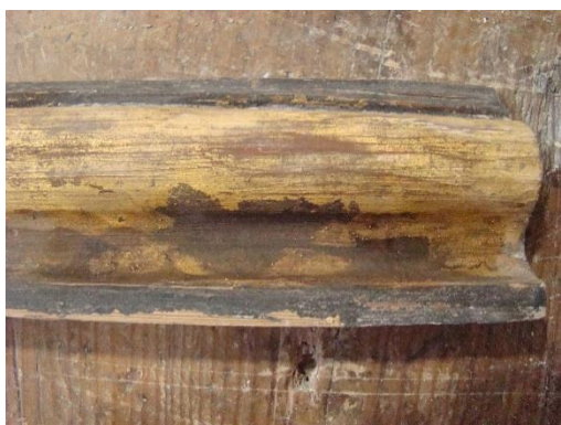
Fig. 32 . Pormenor do desgaste da folha metálica
