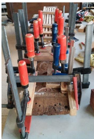
Fig. 211 Apertos das colagens das peças de reconstituição das áreas deterioradas de uma das pilstras
