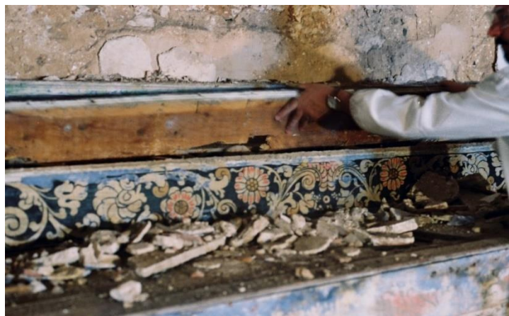
Fig. 42 Pormenor da remoção do tampo da banqueta
