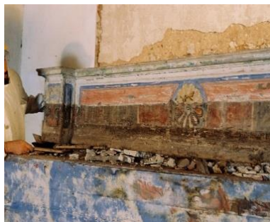
Fig. 24 . Desmontagem do embasamento onde são visíveis a repolicromia e os repintes
