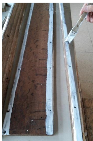
Fig. 227 Aplicação de cola branca nos elementos de uma pilastra
