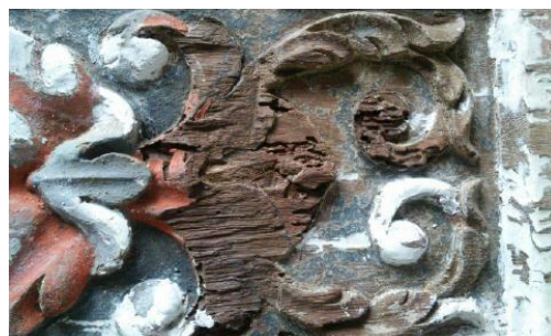
Fig.239 Mísula antes do preenchimento com madeira para preenchimento com modelação volumétrica
