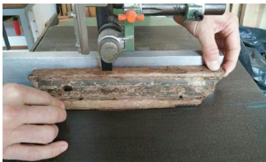
Fig.202 Ablação, por corte, da madeira deteriorada do friso – com lacunas e sem resistência mecânica – pela ação de fungos lenhívoros e insectos xilófagos, para preenchimento com madeira
