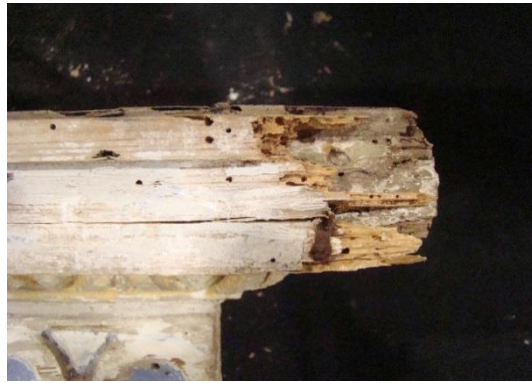
Fig. 60 Pormenor do friso do entablamento com perda de volumetria
