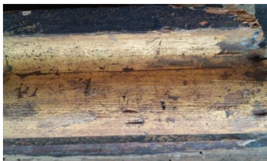
Fig.172 Moldura com lacunas no estrato pictórico e sujidades superficiais
