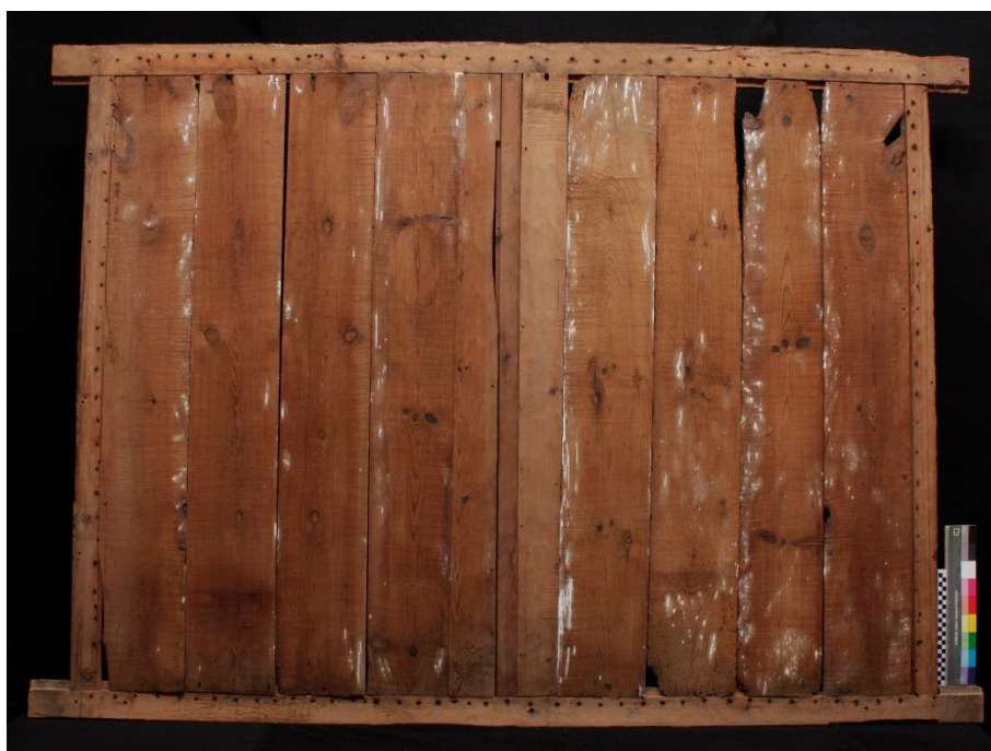
Fig. 105 Vista geral da estrutura de fixação da tela, pelo anverso
