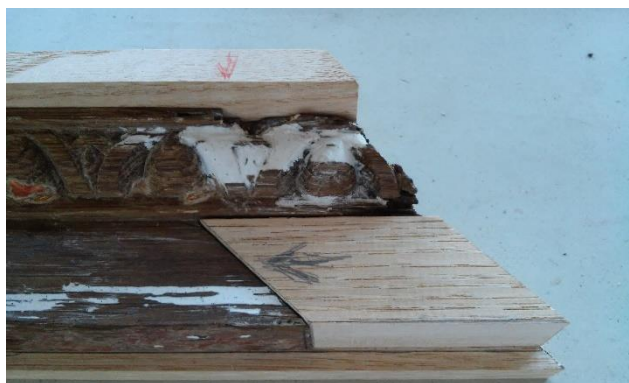
Fig. 40 .Exemplo de um preenchimento com madeira de castanho num dos elementos do retábulo que tinha sido pontualmente ablacionado.
