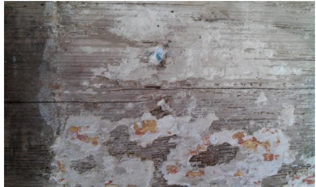
Fig.167 Superfície repintada e pulverulenta
