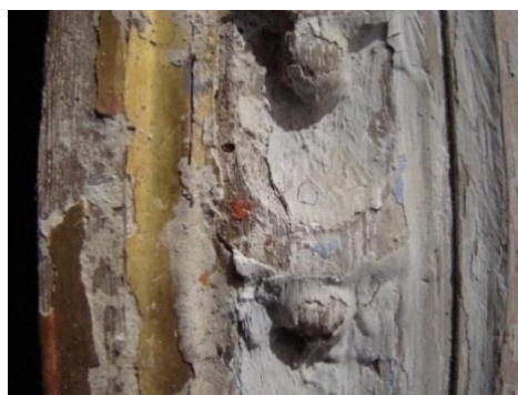
Fig. 38 .Estratos pictóricos pulverulentos e sem coesão.
