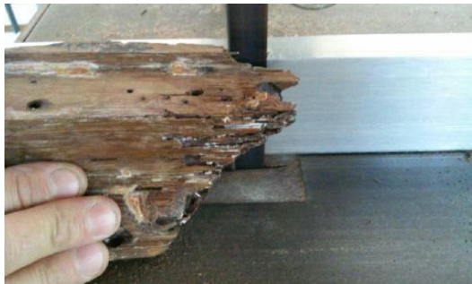
Fig.200 Ablação, por corte, da madeira deteriorada do friso – com lacunas e sem resistência mecânica – pela ação de fungos lenhívoros e insectos xilófagos, para preenchimento com madeira
