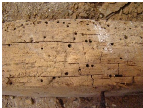
Fig. 29. Podridão Cúbica num dos elementos do retábulo
