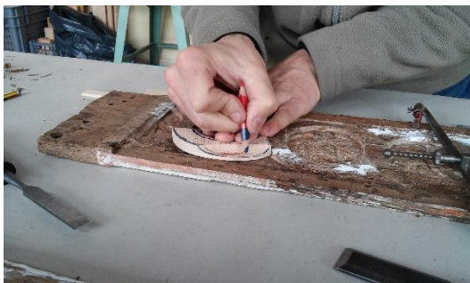
Fig. 188 Risco da peça para aperfeiçoamento da forma à área de preenchimento
