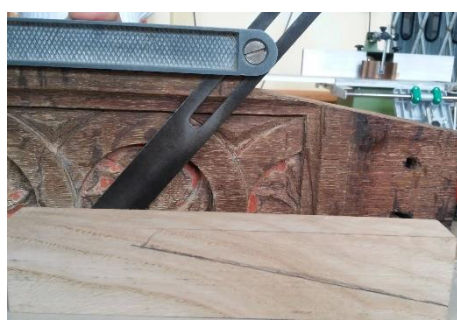
Fig. 224 Desenho na madeira nova da peça para preenchimento da lacuna na madeira de uma das pilastras.
