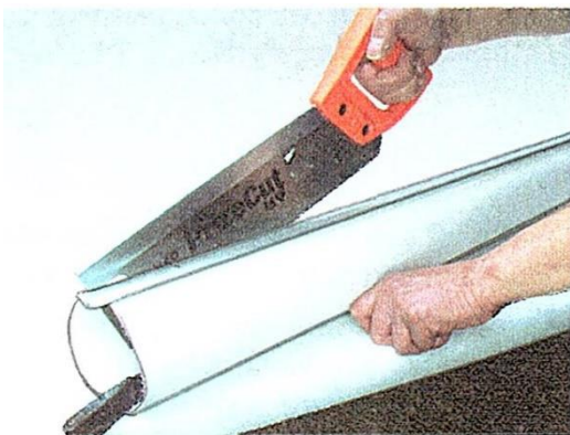
Figura Z2 - O perfil serve de régua para serrar o tubo, ao longo deste (Casablanca & Van Velzen, 2011, p. 34)
