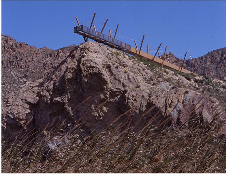
[Fig.5.37] Imagen pasarela mirador Alto de Bayna.
