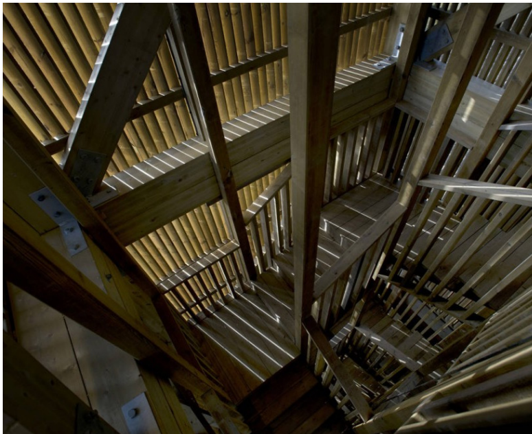
[Fig.5.51] Escalera de acceso al mirador de la torre.
