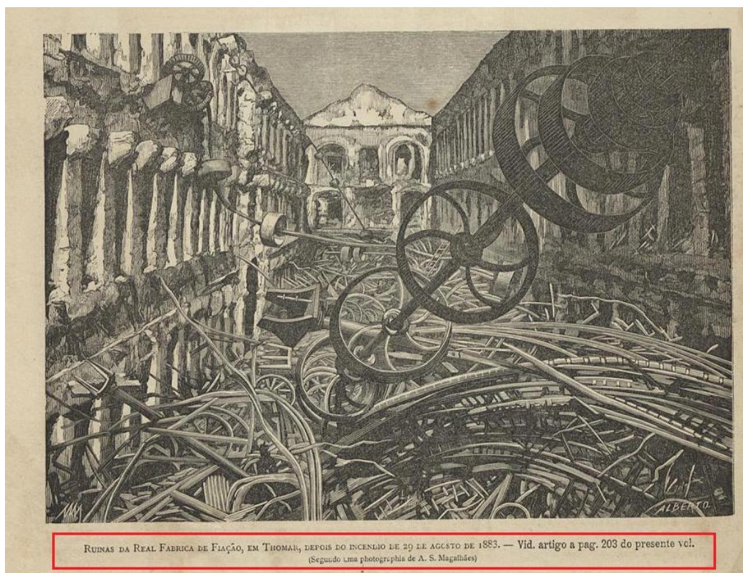
Fig. 6: Incendio na Real Fábrica de Fiação em agosto de 1883 4
