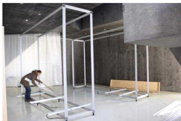
Fig 100: Montagem das estruturas
