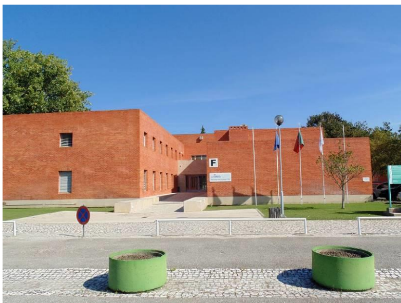
Fig 2: Edifício F do campus do IPT onde está instalado o AFSM.
