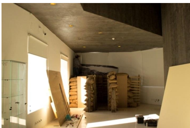
Fig 101: Montagem da trincheira
