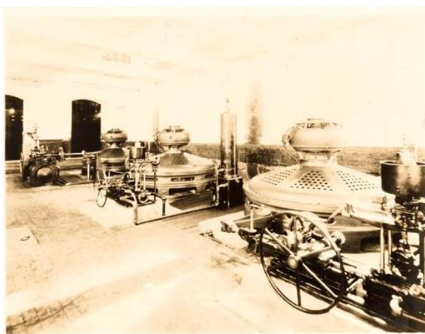
Fig 175: Sala de turbinas, Fábrica na Austria
