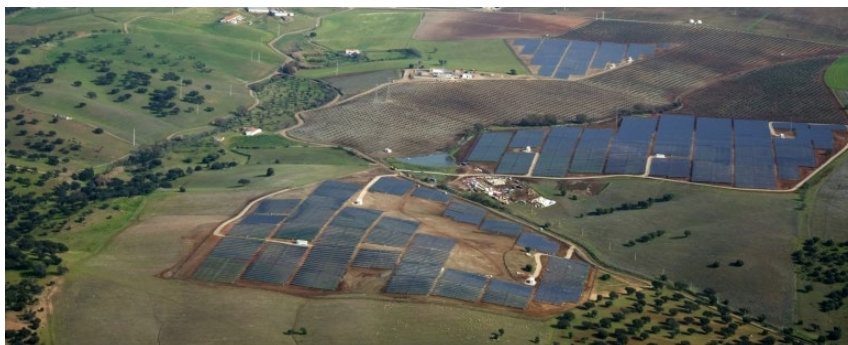
Figura 3.2 Central Fotovoltaica de Serpa (Maso, 2007),
