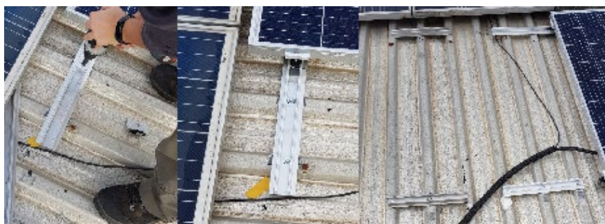
Figura 7.10 – Montagem da estrutura para o módulo fotovoltaico.
