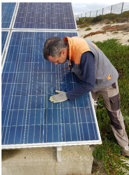
Figura 7.3 – Inspeção dos módulos fotovoltaicos do Hotel MH Peniche
