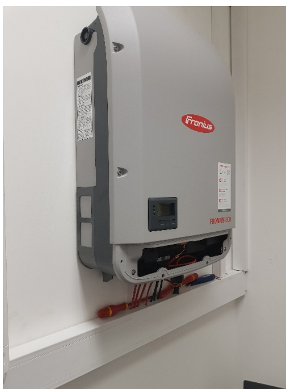
Figura 3.30 -Finalização da montagem de um Fronius Eco
