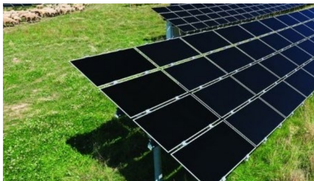
Figura 3.6 - Painéis com células de película fina (Energyinformative, 2012 a)
