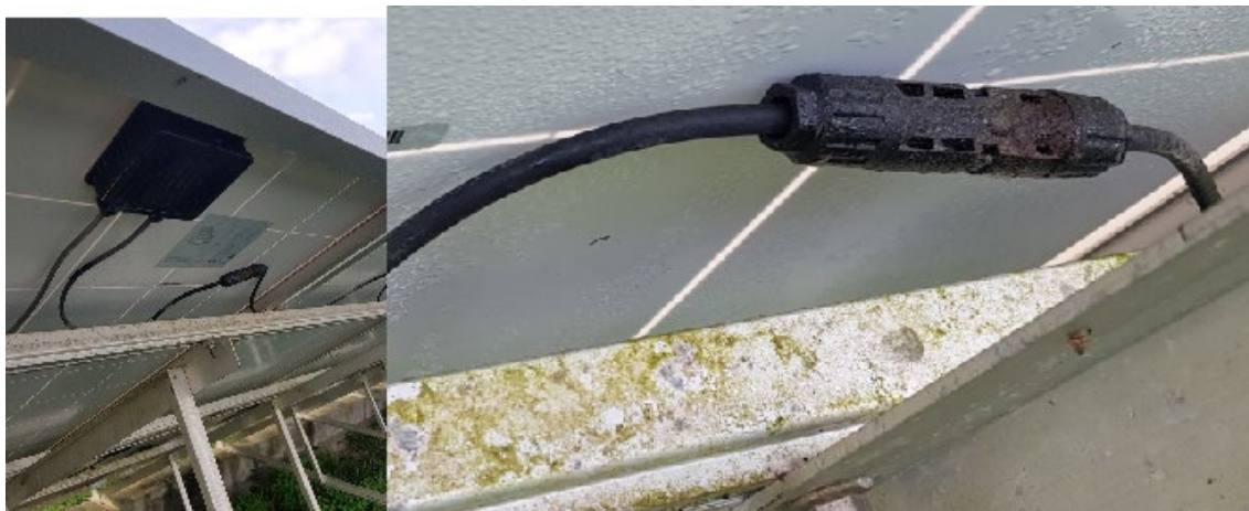
Figura 7.5 – Outro exemplo da ação destrutiva do sal no sistema.
