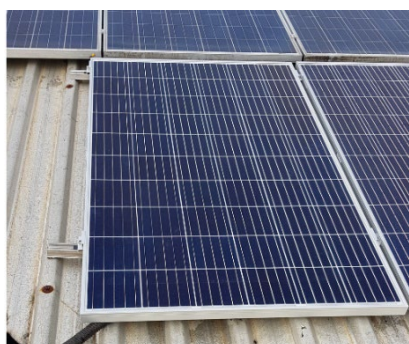
Figura 7.11 – Finalização da instalação do novo módulo
