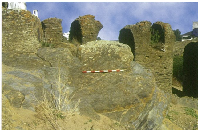
Fig. 15. Entalle en el afloramiento rocoso relacionado con el amarre de embarcaciones
