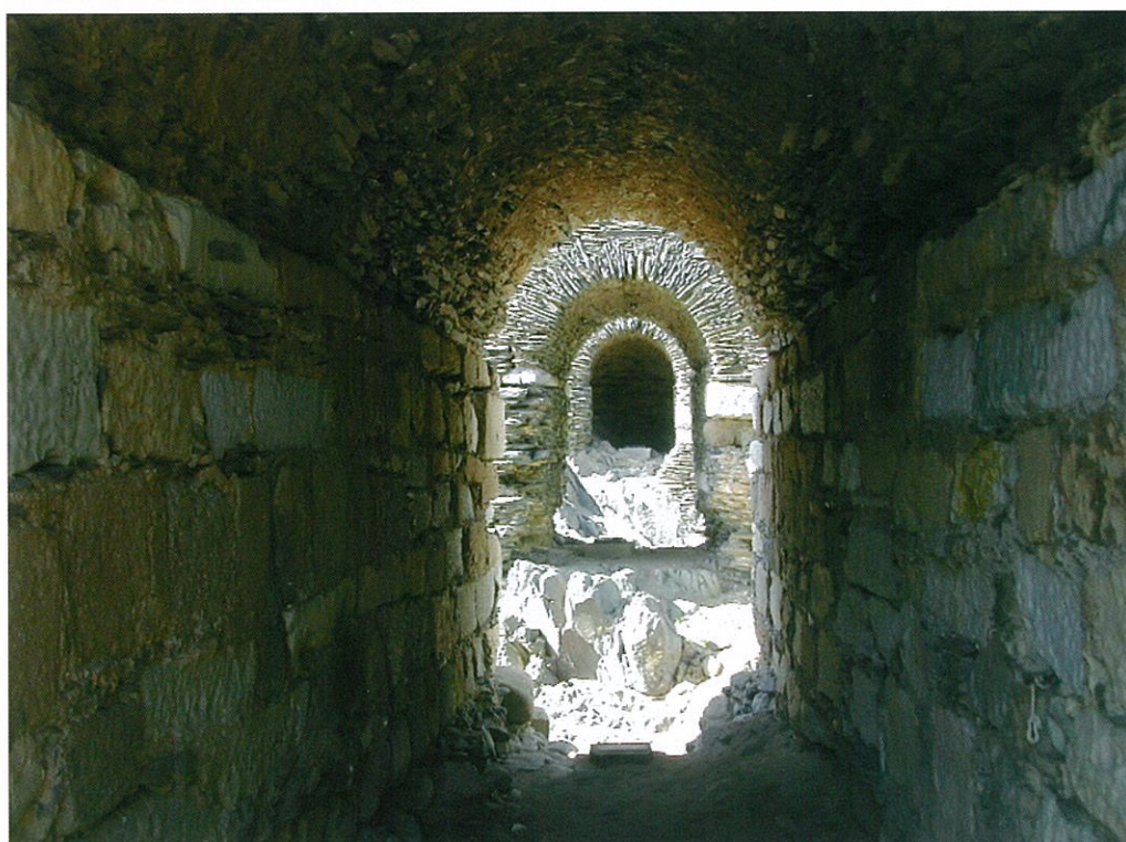
Fig. 13. Túnel de la Torre principal y de los primeros pilares
