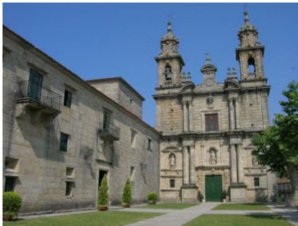
Ilustración 26: Fachada Principal. Fotografía del autor
