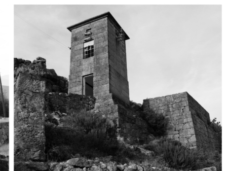
3- POSTO DE TRANSFORMAÇÃO ELÉCTRICA
